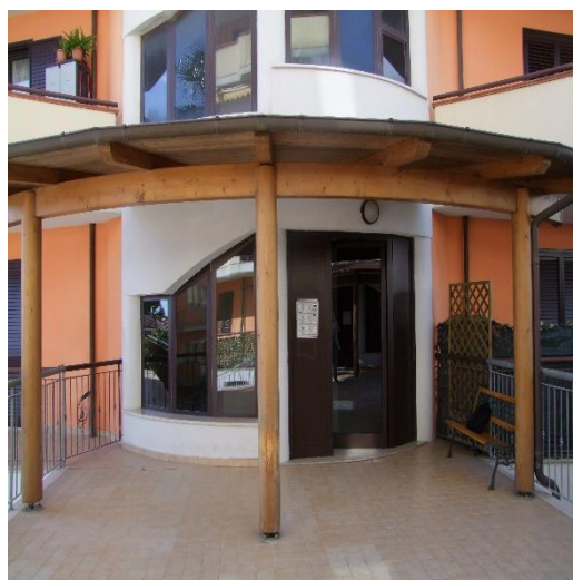
FOTO 06: FABBRICATO PLURIFAMILIARE IN VIA FONTE IOANNA, N. 1, P.LLA 4640
