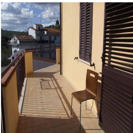
FOTO 21: BALCONE DELL'APPARTAMENTO AL PIANO 3°, P.LLA 4640 SUB. 53 (A/2)
