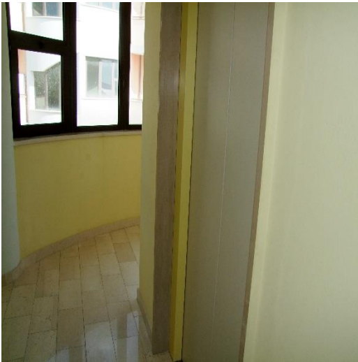
FOTO 13: BALLATOIO COMUNE AL PIANO 3°, P.LLA 4640 SUB. 5 (B.C.N.C.)
