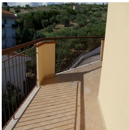
FOTO 22: BALCONE DELL'APPARTAMENTO AL PIANO 3°, P.LLA 4640 SUB. 53 (A/2)
