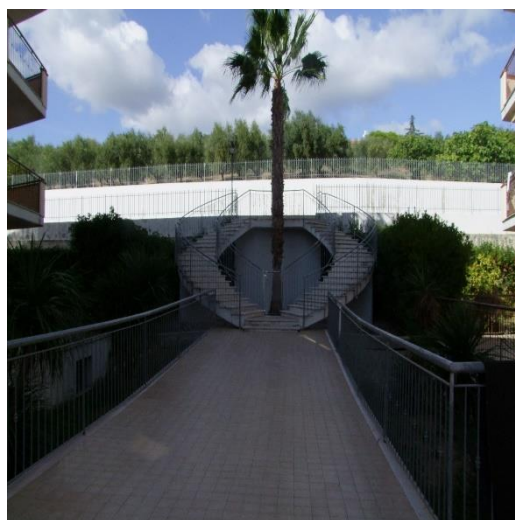
FOTO 10: INGRESSO COMUNE AL PIANO TERRA IN VIA FONTE IOANNA, N. 1, P.LLA 4640, P.LLA 4640 SUB. 1 (B.C.N.C.)
