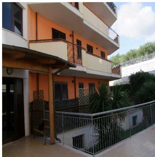
FOTO 08: FABBRICATO PLURIFAMILIARE IN VIA FONTE IOANNA, N. 1, P.LLA 4640
