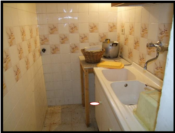
F. 21: INTERNO DELL'APPARTAMENTO UBICATA AL PIANO SEMINTERRATO IN VIA MARCHIONNE, S.N.C., LOCALITÀ MARCHIONNE – SAN GIOVANNI LIPIONI (CH), P.LLE 396 SUB. 6 (A/3)
