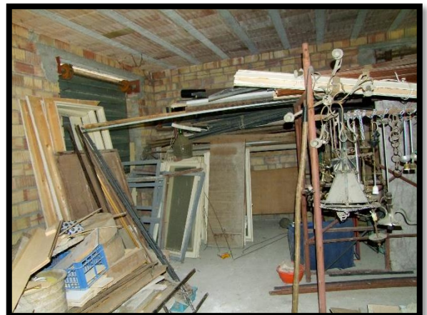
F. 30: INTERNO DELLA CANTINA UBICATA AL PIANO TERRA IN VIA MARCHIONNE, S.N.C., LOCALITÀ MARCHIONNE, SAN GIOVANNI LIPIONI (CH), P.LLE 396 SUB. 3 (F/3)
