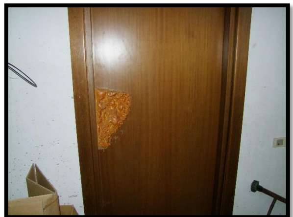
F. 24: INGRESSO DELLA CANTINA UBICATA AL PIANO TERRA IN VIA MARCHIONNE, S.N.C., LOCALITÀ MARCHIONNE, SAN GIOVANNI LIPIONI (CH), P.LLE 396 SUB. 3 (F/3)
