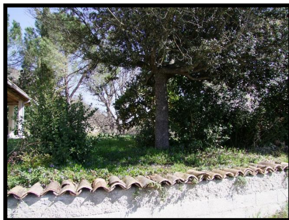
F. 10: AREA COMUNE PERTINENZIALE UBICATA AL PIANO TERRA IN VIA MARCHIONNE, S.N.C., LOCALITÀ MARCHIONNE – SAN GIOVANNI LIPIONI (CH), P.LLE 396 SUB. 1 (B.C.N.C.)
