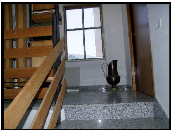
F. 49: ACCESSO ALLA MANSARDA UBICATA AL PIANO 2° SOTTOTETTO IN VIA MARCHIONNE, S.N.C., LOCALITÀ MARCHIONNE – SAN GIOVANNI LIPIONI (CH), P.LLE 396 SUB. 1 (B.C.N.C.)
