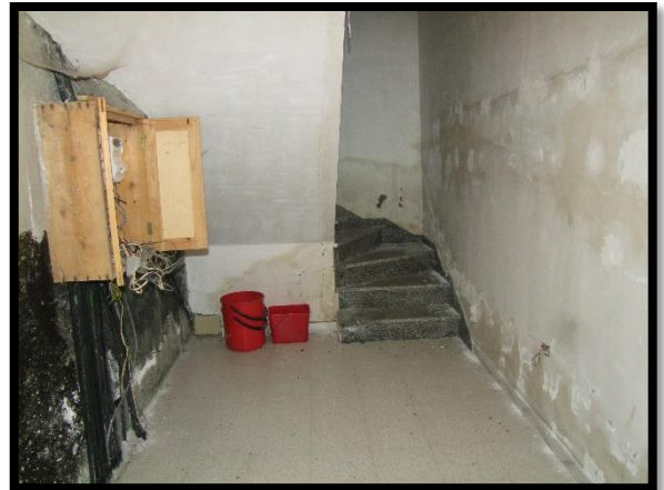
F. 22: INTERNO DELL'APPARTAMENTO UBICATA AL PIANO SEMINTERRATO IN VIA MARCHIONNE, S.N.C., LOCALITÀ MARCHIONNE – SAN GIOVANNI LIPIONI (CH), P.LLE 396 SUB. 6 (A/3)
