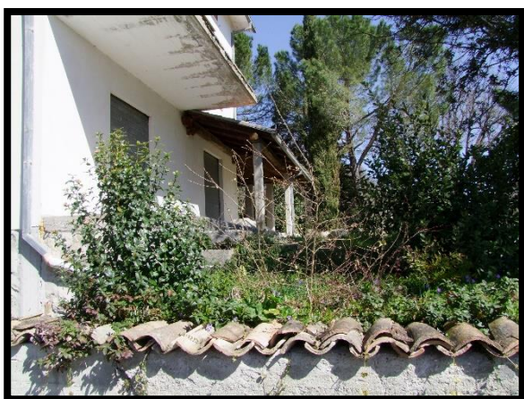
F. 11: AREA COMUNE PERTINENZIALE UBICATA AL PIANO TERRA IN VIA MARCHIONNE, S.N.C., LOCALITÀ MARCHIONNE – SAN GIOVANNI LIPIONI (CH), P.LLE 396 SUB. 1 (B.C.N.C.)
