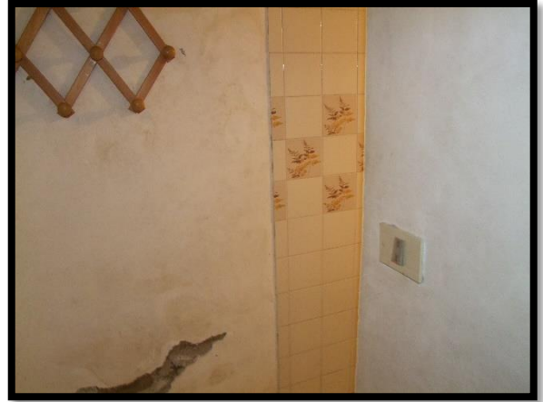
F. 20: INTERNO DELL'APPARTAMENTO UBICATA AL PIANO SEMINTERRATO IN VIA MARCHIONNE, S.N.C., LOCALITÀ MARCHIONNE – SAN GIOVANNI LIPIONI (CH), P.LLE 396 SUB. 6 (A/3)
