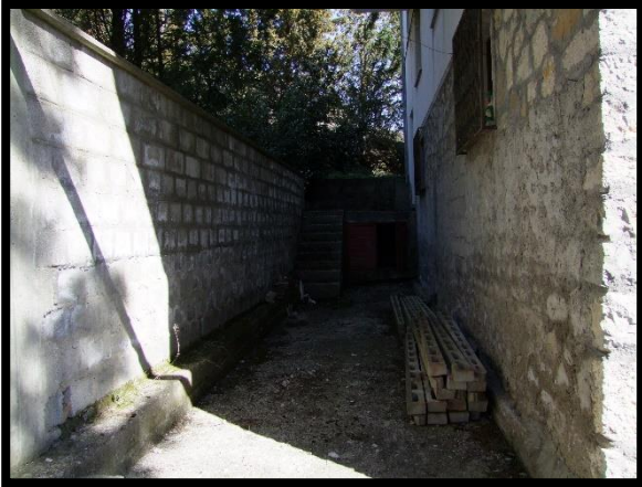
F. 13: AREA COMUNE PERTINENZIALE UBICATA AL PIANO SEMINTERRATO IN VIA MARCHIONNE, S.N.C., LOCALITÀ MARCHIONNE – SAN GIOVANNI LIPIONI (CH), P.LLE 396 SUB. 1 (B.C.N.C.)
