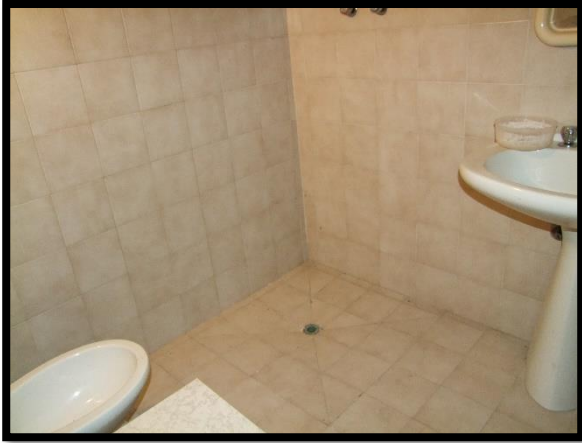
F. 19: INTERNO DELL'APPARTAMENTO UBICATA AL PIANO SEMINTERRATO IN VIA MARCHIONNE, S.N.C., LOCALITÀ MARCHIONNE – SAN GIOVANNI LIPIONI (CH), P.LLE 396 SUB. 6 (A/3)
