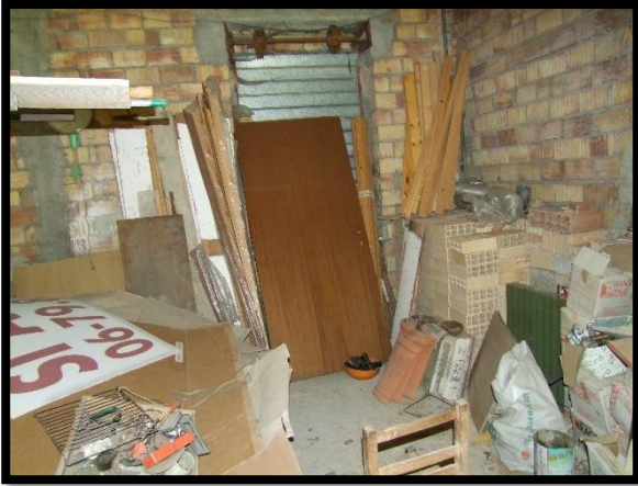
F. 31: INTERNO DELLA CANTINA UBICATA AL PIANO TERRA IN VIA MARCHIONNE, S.N.C., LOCALITÀ MARCHIONNE, SAN GIOVANNI LIPIONI (CH), P.LLE 396 SUB. 3 (F/3)
