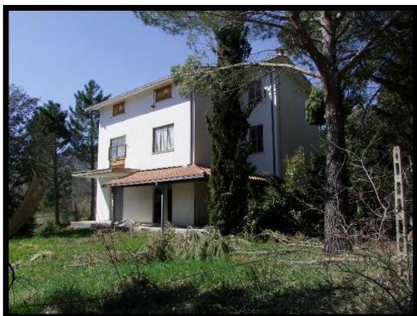
F. 61: FABBRICATO PLURIFAMILIARE UBICATO IN VIA MARCHIONNE, S.N.C., LOCALITÀ MARCHIONNE – SAN GIOVANNI LIPIONI (CH), P.LLE 396 SUB. 3, 4, 5 3 6
