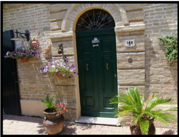
F. 09: INGRESSO DELL'ABITAZIONE UBICATA AL PIANO TERRA IN CONTRADA MARCIANESE, N. 140 – LANCIANO (CH), P.LLA 4195 SUB. 2 (A/4)
