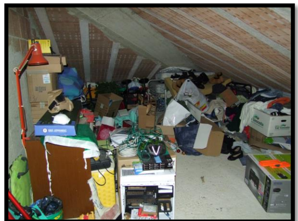
F. 30: INTERNO DELLA SOFFITTA UBICATA AL PIANO 2° SOTTOTETTO IN CONTRADA MARCIANESE, N. 140, LANCIANO (CH), P.LLA 4195 SUB. 2 (A/4)
