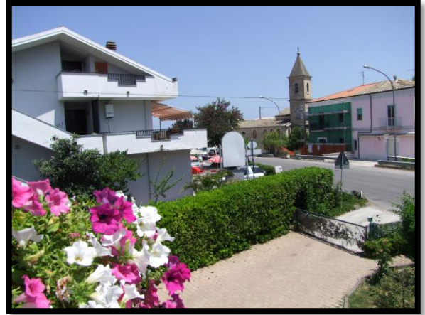
F. 26: VISTA DALL'ABITAZIONE UBICATA AL PIANO 1° IN CONTRADA MARCIANESE, N. 140 – LANCIANO P.LLA 4195 SUB. 2 (A/4)
