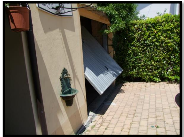
F. 34: INGRESSO DELLA LEGNAIA UBICATA AL PIANO TERRA IN CONTRADA MARCIANESE, N. 140, LANCIANO (CH), P.LLA 4195 SUB. 2 (A/4)
