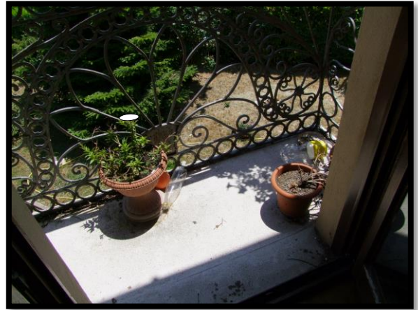
F. 22: BALCONE DELL'ABITAZIONE UBIcata AL PIANO 1° IN CONTRADA MARCIANESE, N. 140 – LANCIANO P.LLA 4195 SUB. 2 (A/4)
