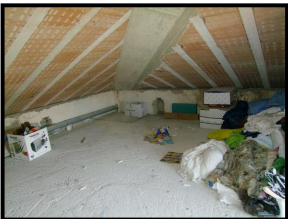
F. 29: INTERNO DELLA SOFFITTA UBICATA AL PIANO 2° SOTTOTETTO IN CONTRADA MARCIANESE, N. 140, LANCIANO (CH), P.LLA 4195 SUB. 2 (A/4)
