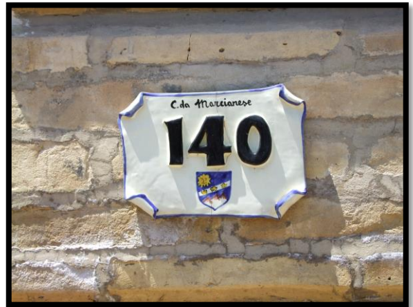
F. 10: INGRESSO DELL'ABITAZIONE UBICATA AL PIANO TERRA IN CONTRADA MARCIANESE, N. 140 – LANCIANO (CH), P.LLA 4195 SUB. 2 (A/4)
