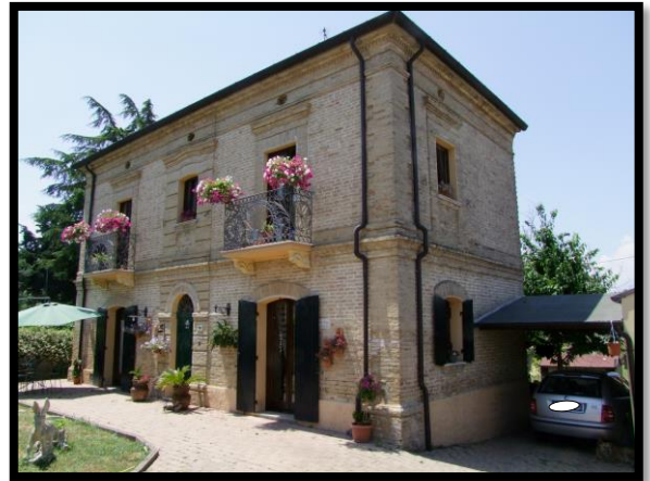
F. 04: FABBRICATO PLURIFAMILIARE UBICATO IN CONTRADA MARCIANESE, N. 140 – LANCIANO (CH), P.LLA 4195 SUB. 2 (A/4)
