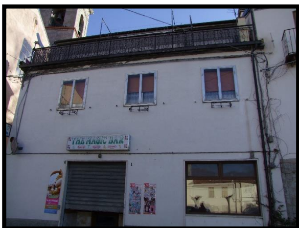
F. 05: FABBRICATO COMMERCIALE E RESIDENZIALE UBICATO AL CORSO UMBERTO I, N.1 E VIA XX SETTEMBRE, N. 1, IN SANT'ANGELO DEL PESCO (IS), P.LLA 290
