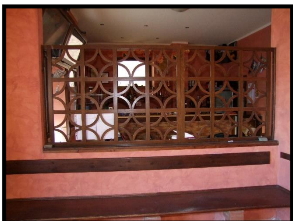
F. 41: INTERNO DEL LOCALE COMMERCIALE UBICATO AL PIANO TERRA AL CORSO UMBERTO I, N. 1, SANT'ANGELO DEL PESCO (IS), P.LLA 290 SUB. 5
