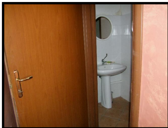
F. 38: INTERNO DEL LOCALE COMMERCIALE UBICATO AL PIANO TERRA AL CORSO UMBERTO I, N. 1, SANT'ANGELO DEL PESCO (IS), P.LLA 290 SUB. 5
