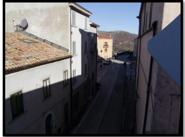
F. 26: VISTA DALL'APPARTAMENTO UBICATO AL PIANO PRIMO IN VIA XX SETTEMBRE, N. 1 – SANT'ANGELO DEL PESCO (IS), P.LLA 290 SUB. 6
