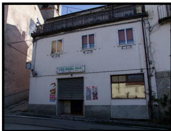
F. 04: FABBRICATO COMMERCIALE E RESIDENZIALE UBICATO AL CORSO UMBERTO I, N.1 E VIA XX SETTEMBRE, N. 1, IN SANT'ANGELO DEL PESCO (IS), P.LLA 290
