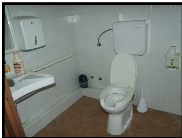
F. 40: INTERNO DEL LOCALE COMMERCIALE UBICATO AL PIANO TERRA AL CORSO UMBERTO I, N. 1, SANT'ANGELO DEL PESCO (IS), P.LLA 290 SUB. 5
