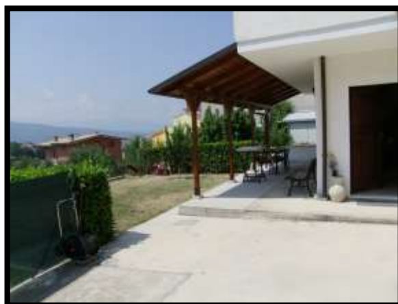
F. 06: CORTE ESCLUSIVA UBICATA AL PIANO TERRA IN VIA PIETRO MASCAGNI – CASALINCONTRADA (CH), P.LLA 454 SUB. 3 GRAFFATA ALLA 455 SUB. 3 (A/3)
