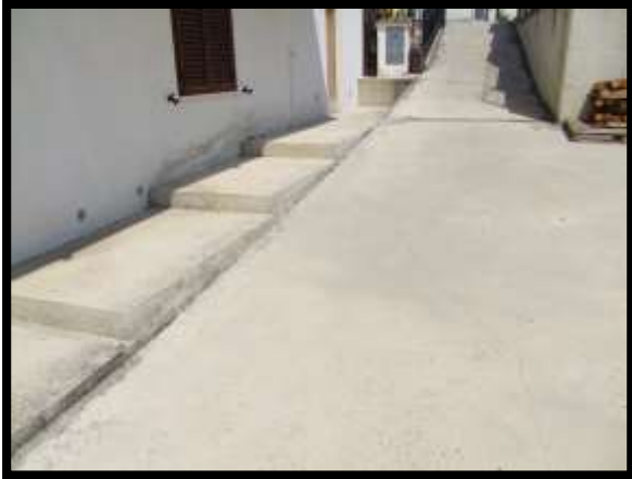
F. 07: CORTE ESCLUSIVA UBICATA AL PIANO TERRA IN VIA PIETRO MASCAGNI – CASALINCONTRADA (CH), P.LLA 454 SUB. 3 GRAFFATA ALLA 455 SUB. 3 (A/3)
