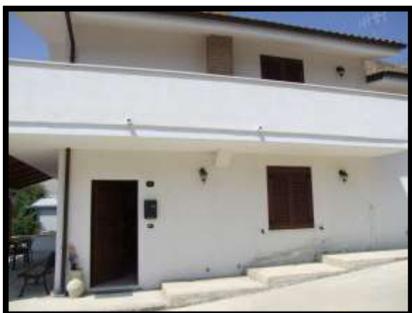
F. 05: INGRESSO DELL'APPARTAMENTO UBICATO AL PIANO TERRA IN VIA PIETRO MASCAGNI, N. 5, CASALINCONTRADA (CH), P.LLA 454 SUB. 3 GRAFFATA ALLA 455 SUB. 3 (A/3)
