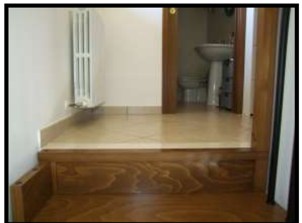
F. 18: ACCESSO ALL'APPARTAMENTO UBICATO AL PIANO 1° IN VIA PIETRO MASCAGNI – CASALINCONTRADA (CH), P.LLA 454 SUB. 3 GRAFFATA ALLA 455 SUB. 3 (A/3)
