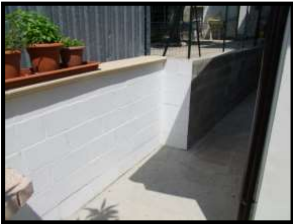
F. 09: CORTE ESCLUSIVA UBICATA AL PIANO TERRA IN VIA PIETRO MASCAGNI – CASALINCONTRADA (CH), P.LLA 454 SUB. 3 GRAFFATA ALLA 455 SUB. 3 (A/3)
