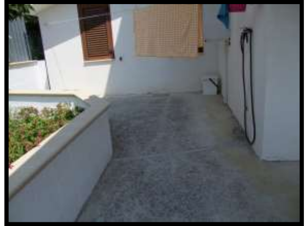
F. 08: CORTE ESCLUSIVA UBICATA AL PIANO TERRA IN VIA PIETRO MASCAGNI – CASALINCONTRADA (CH), P.LLA 454 SUB. 3 GRAFFATA ALLA 455 SUB. 3 (A/3)
