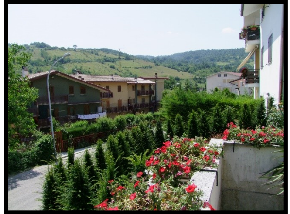
F. 20: CORTE ESCLUSIVA UBICATA AL PIANO TERRA IN VIA NUOVA SANT'ANTONIO, N. 11 – PALENA (CH), P LLA 4269 SUB. 8 (A/2)
