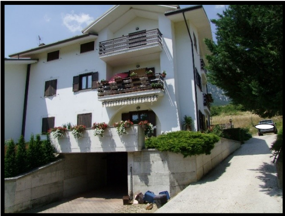
F. 03: FABBRICATO PLURIFAMILIARE UBICATO IN VIA NUOVA SANT'ANTONIO, N. 11 – PALENA (CH), P.LLA 4269
