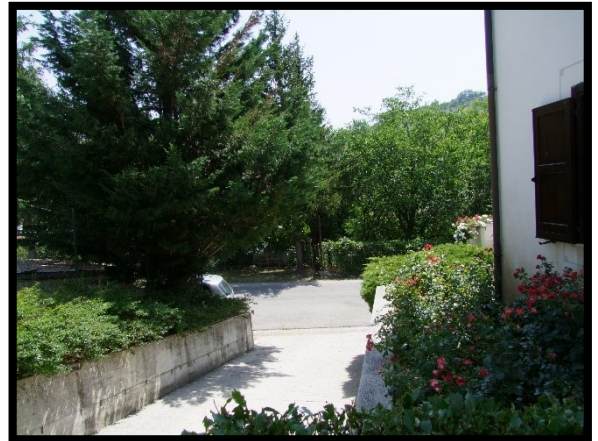
F. 04: FABBRICATO PURIFAMILIARE UBICATO IN VIA NUOVA SANT'ANTONIO, n. 11 – PALENA (CH), P.LLA 4269
