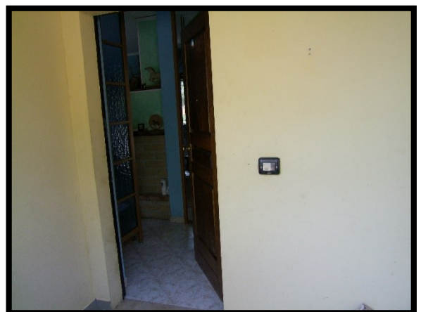
F. 06: INGRESSO DELL'ABITAZIONE INTERNO "3" UBICATA AL PIANO TERRA IN VIA NUOVA SANT'ANTONIO, N. 11 PALENA (CH), P LLA 4269 SUB. 8 (A/2)
