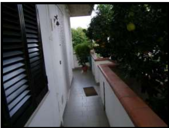
F. 11: PORTICO D'INGRESSO ALL'APPARTAMENTO UBICATO AL PIANO TERRA IN VIA OSIMO, N. 98, LOCALITÀ GONFALONE – CASALBORDINO (CH), P.LLA 195 SUB. 5 (A/4)
