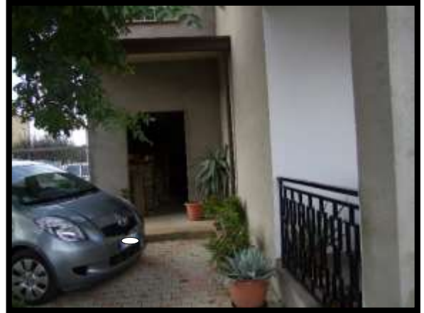
F. 08: AREA COMUNE UBICATA AL PIANO TERRA IN VIA OSIMO, N. 98, LOCALITÀ GONFALONE – CASALBORDINO (CH), P.LLA 195 SUB. 7 (B.C.N.C.)
