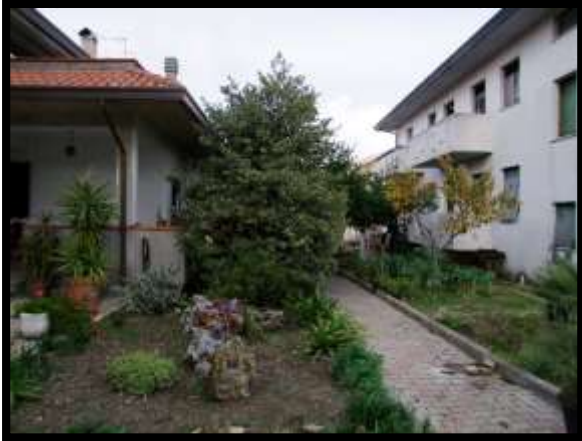
F. 07: AREA COMUNE UBICATA AL PIANO TERRA IN VIA OSIMO, N. 98, LOCALITÀ GONFALONE – CASALBORDINO (CH), P.LLA 195 SUB. 7 (B.C.N.C.)
