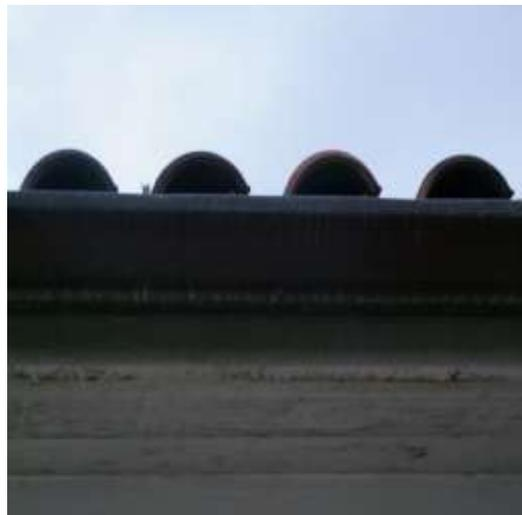
**FOTO 40: VISTA PARTICOLARE DEL CANALE DI GRONDA E DEL MANTO DI COPERTURA**
