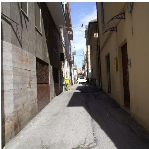
FOTO N. 33: ACCESSO AL FABBRICATO PLURI-FAMILIARE DA VIA GUGLIELMO PEPE – VASTO (CH)
