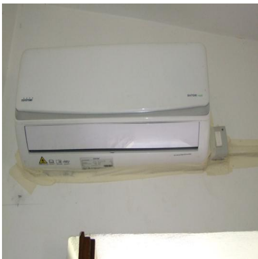
FOTO 67: APPARTAMENTO P. T., CIV. 3, P.LLA 543 SUB. 1 (A/4)
