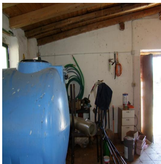
FOTO 112: RIMESSA P. T., CIV. 12, P.LLA 562 SUB. 0 (C/6)
