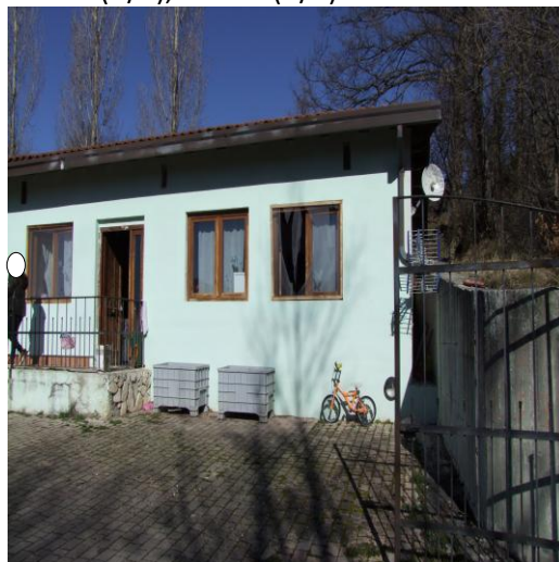
FOTO 04: APPARTAMENTO, CIV. 6, P.LLA 560 SUB. 2 (A/4)
