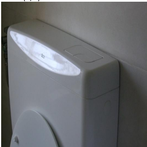
FOTO 63: APPARTAMENTO P. T., CIV. 3, P.LLA 543 SUB 1 (A/4)
