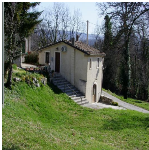
FOTO 50: APPARTAMENTI, CIV. 3, P.LLE 543 SUB. 1 (A/4), SUB. 2 (A/4) E TERRENO P.LLA 442
