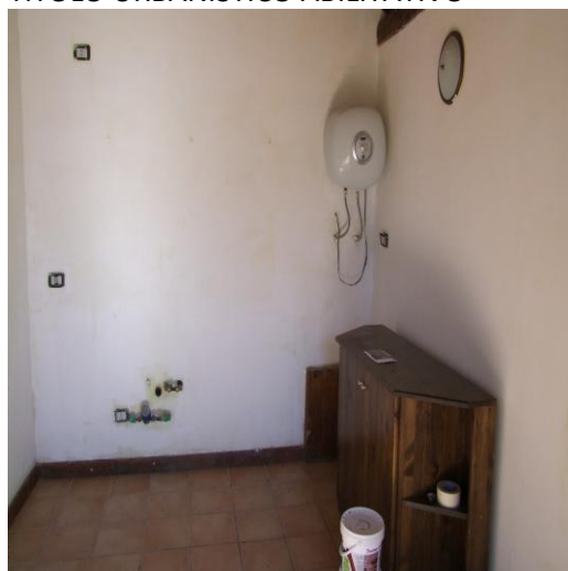
FOTO 96: FABBRICATO UNIF. P. T., CIV. 12, P.LLA 557 SUB. 0 (A/4) – NON VALUTATO PER MANCANZA DI TITOLO URBANISTICO ABILITATIVO
