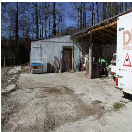
FOTO 101: RIMESSA P. T., CIV. 12, P.LLA 562 SUB. 0 (C/6)
