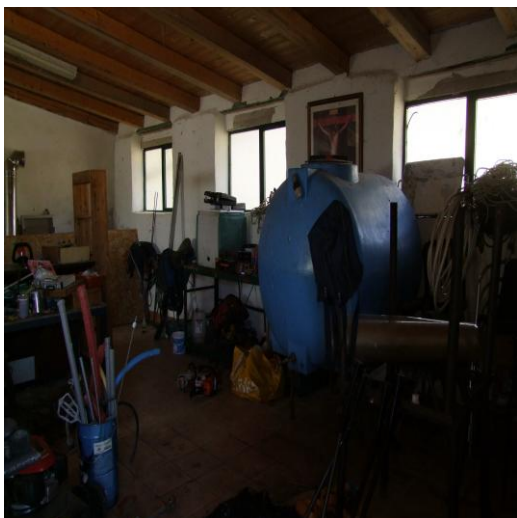
FOTO 107: RIMESSA P. T., CIV. 12, P.LLA 562 SUB. 0 (C/6)
