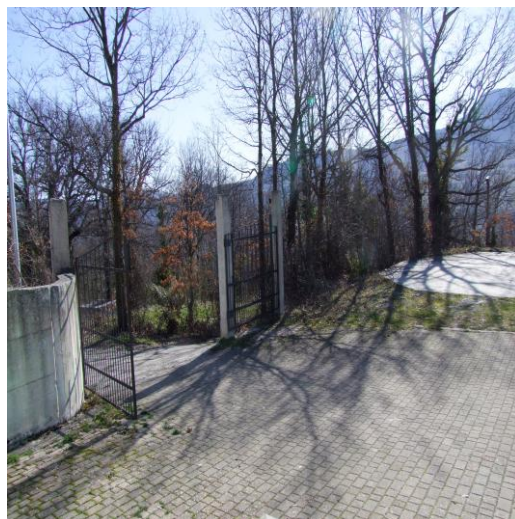
FOTO 44: APPARTAMENTI, CIV. 6, P.LLE 560 SUB. 1 (A/4), SUB. 2 (A/4) E TERRENO P.LLA 558
