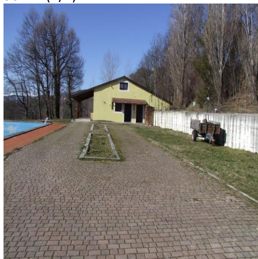
FOTO 06: APPARTAMENTI, CIV. 6, P.LLE 560 SUB. 1 (A/4), SUB. 2 (A/4) E TERRENO P.LLA 558
