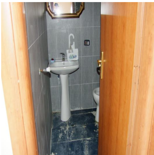
FOTO 97: FABBRICATO UNIF. P. T., CIV. 12, P.LLA 557 SUB. 0 (A/4) – NON VALUTATO PER MANCANZA DI TITOLO URBANISTICO ABILITATIVO
