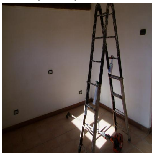
FOTO 94: FABBRICATO UNIF. P. T., CIV. 12, P.LLA 557 SUB. 0 (A/4) – NON VALUTATO PER MANCANZA DI TITOLO URBANISTICO ABILITATIVO
