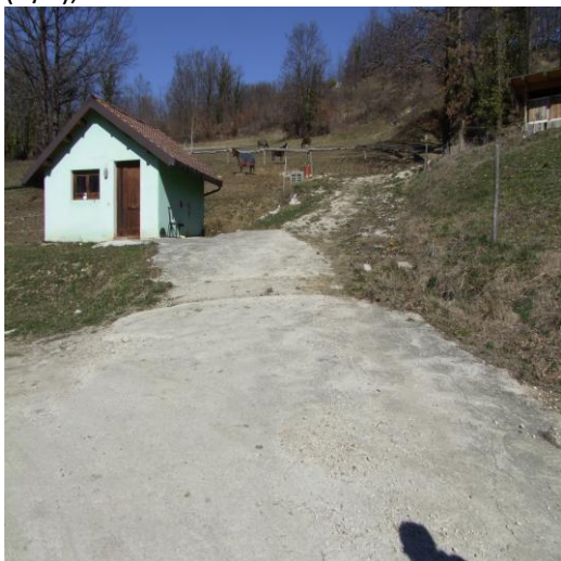
FOTO 87: FABBRICATO UNIF. P. T., CIV. 12, P.LLA 557 SUB. 0 (A/4) E TERRENO P.LLA 745
