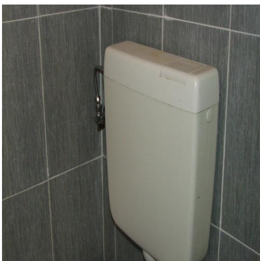
FOTO 99: FABBRICATO UNIF. P. T., CIV. 12, P.LLA 557 SUB. 0 (A/4) – NON VALUTATO PER MANCANZA DI TITOLO URBANISTICO ABILITATIVO
