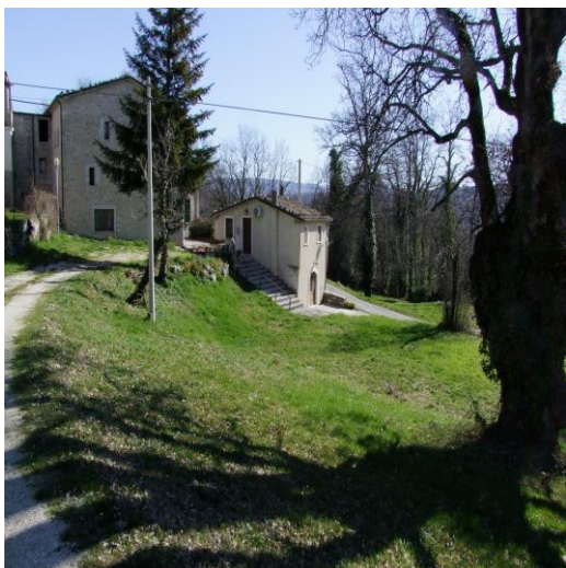
FOTO 49: APPARTAMENTI, CIV. 3, P.LLE 543 SUB. 1 (A/4), SUB. 2 (A/4) E TERRENO P.LLA 442
