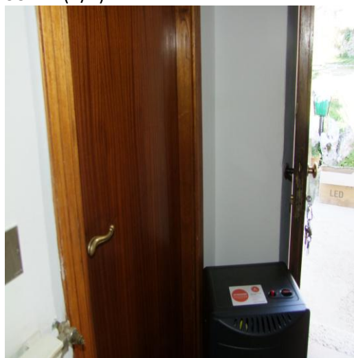
FOTO 60: APPARTAMENTO P. T., CIV. 3, P.LLA 543 SUB. 1 (A/4)
