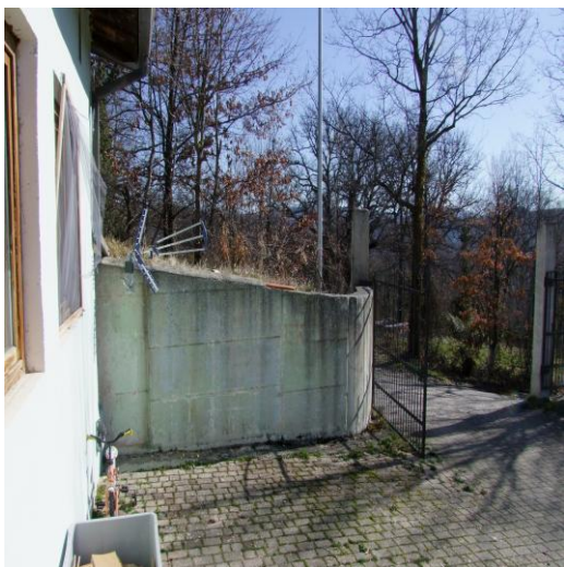
FOTO 47: APPARTAMENTI, CIV. 6, P.LLE 560 SUB. 1 (A/4), SUB. 2 (A/4) E TERRENO P.LLA 558
