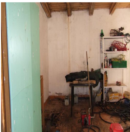
FOTO 111: RIMESSA P. T., CIV. 12, P.LLA 562 SUB. 0 (C/6)
