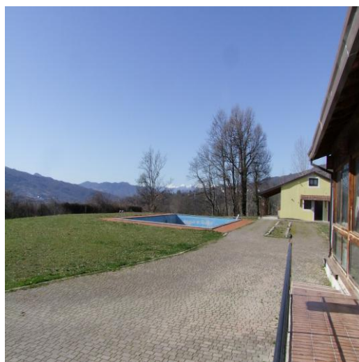
FOTO 46: APPARTAMENTI, CIV. 6, P.LLE 560 SUB. 1 (A/4), SUB. 2 (A/4) E TERRENO P.LLA 558
