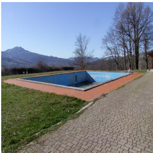
FOTO 07: APPARTAMENTI, CIV. 6, P.LLE 560 SUB. 1 (A/4), SUB. 2 (A/4) E TERRENO P.LLA 558
