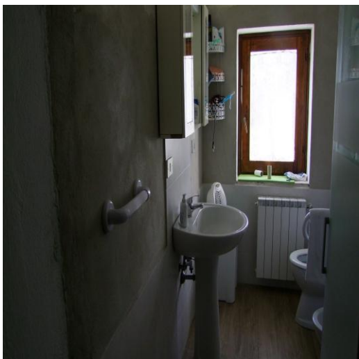
FOTO 61: APPARTAMENTO P. T., CIV. 3, P.LLA 543 SUB 1 (A/4)
