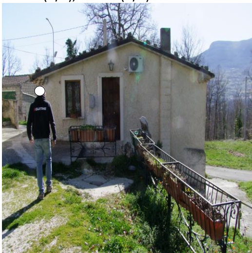
FOTO 51: APPARTAMENTI, CIV. 3, P.LLE 543 SUB. 1 (A/4), SUB. 2 (A/4) E TERRENO P.LLA 442
