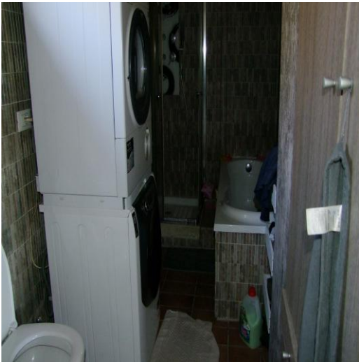
FOTO 19: APPARTAMENTO P. T., CIV. 6, P.LLA 560 SUB. 2 (A/4)
