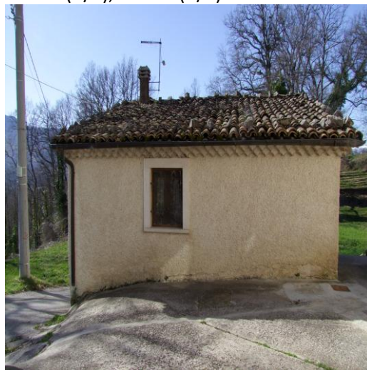
FOTO 52: APPARTAMENTI, CIV. 3, P.LLE 543 SUB. 1 (A/4), SUB. 2 (A/4) E TERRENO P.LLA 442
