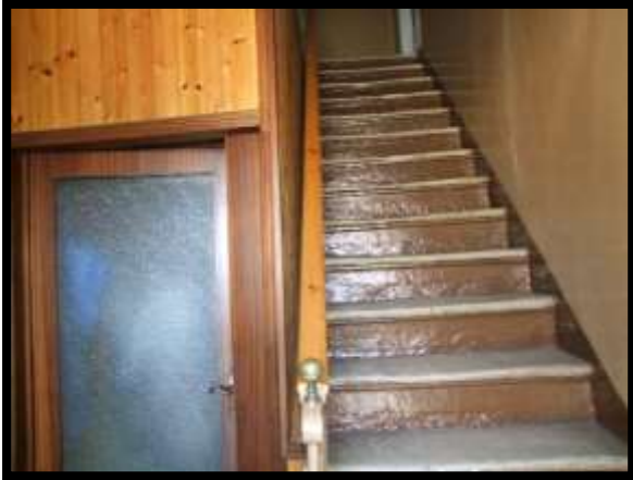
F. 07: ANDRONE COMUNE UBICATO AL PIANO TERRA IN VIA NICOLA SEBASTIANI, N. 53 – OVINDOLI (AQ), P.LLA 511
