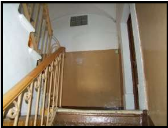
F. 09: ACCESSO ALL'APPARTAMENTO UBICATO AL PIANO 1° IN VIA NICOLA SEBASTIANI, N. 53 – OVINDOLI (AQ), P.LLA 511
