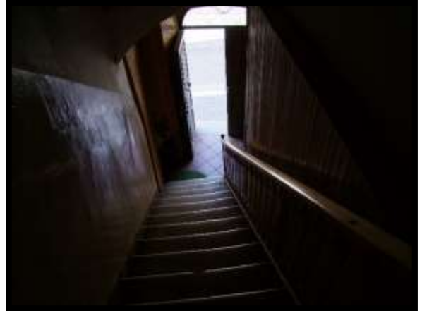
F. 08: ANDRONE COMUNE UBICATO AL PIANO TERRA IN VIA NICOLA SEBASTIANI, N. 53 – OVINDOLI (AQ), P.LLA 511
