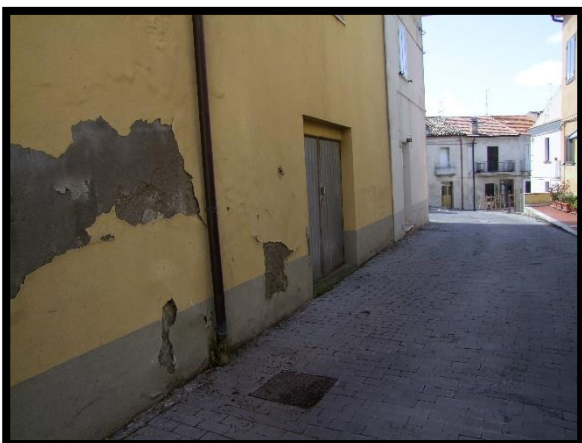
F. 47: INGRESSO DELLA CANTINA UBICATA AL PIANO TERRA DI VIA GIUSEPPE GARIBALDI, S.N.C. – MONTECILFONE (CB), P.LLA 161 SUB. 4 GRAFFATA ALLA P.LLA 499 SUB. 4
