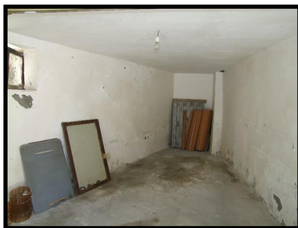
F. 42: INTERNO DELLA CANTINA UBICATA AL PIANO TERRA DI VIA FRANCESCO CRISPI, N. 2 – MONTECILFONE (CB), P.LLA 161 SUB. 4 GRAFFATA ALLA P.LLA 499 SUB. 4
