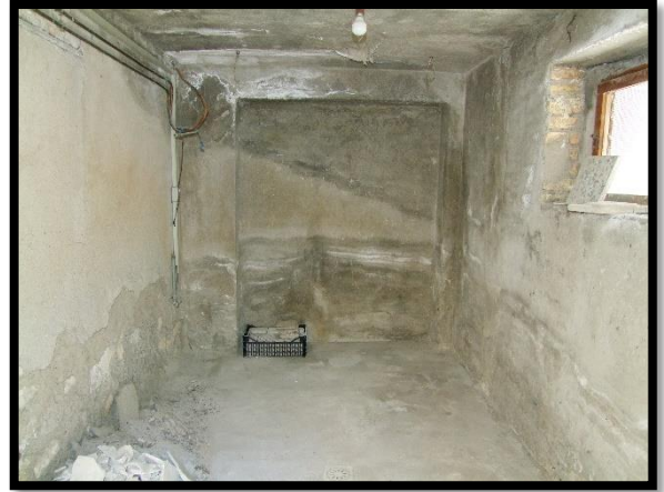
F. 44: INTERNO DELLA LEGNAIA UBICATA AL PIANO TERRA DI VIA FRANCESCO CRISPI, N. 2 – MONTECILFONE (CB), P.LLA 161 SUB. 4 GRAFFATA ALLA P.LLA 499 SUB. 4
