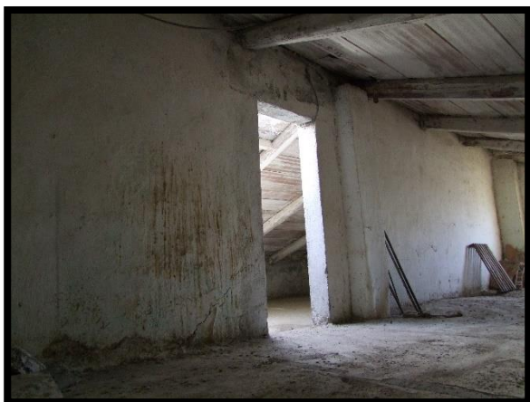
F. 39: INTERNO DELLA SOFFITTA UBICATA AL PIANO 3° SOTTOTETTO DI VIA FRANCESCO CRISPI, N. 2, MONTECILFONE (CB), P.LLA 161 SUB. 4 GRAFFATA ALLA P.LLA 499 SUB. 4
