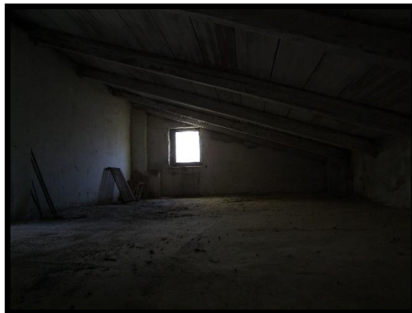
F. 38: INTERNO DELLA SOFFITTA UBICATA AL PIANO 3° SOTTOTETTO DI VIA FRANCESCO CRISPI, N. 2, MONTECILFONE (CB), P.LLA 161 SUB. 4 GRAFFATA ALLA P.LLA 499 SUB. 4
