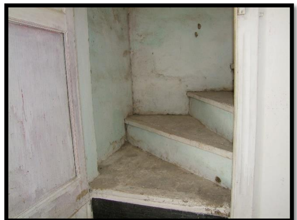
F. 36: ACCESSO ALLA SOFFITTA UBICATA AL PIANO 3° SOTTOTETTO DI VIA FRANCESCO CRISPI, N. 2, MONTECILFONE (CB), P.LLA 161 SUB. 4 GRAFFATA ALLA P.LLA 499 SUB. 4
