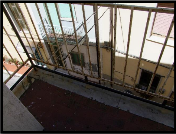
F. 33: BALCONE DELL'ABITAZIONE UBICATA AL PIANO 2° DI VIA FRANCESCO CRISPI, N. 2 – MONTECILFONE (CB), P.LLA 161 SUB. 4 GRAFFATA ALLA P.LLA 499 SUB. 4
