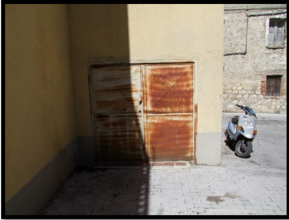
F. 43: INGRESSO DELLA LEGNAIA UBICATA AL PIANO TERRA DI VIA FRANCESCO CRISPI, N. 2 – MONTECILFONE (CB), P.LLA 161 SUB. 4 GRAFFATA ALLA P.LLA 499 SUB. 4
