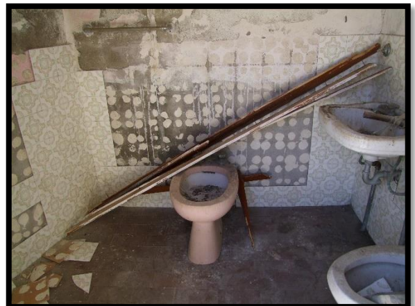
F. 30: INTERNO DEL W.C. UBICATO AL PIANO 2° DI VIA FRANCESCO CRISPI, N. 2 – MONTECILFONE (CB), P.LLA 161 SUB. 4 GRAFFATA ALLA P.LLA 499 SUB. 4 (CAUTELATIVAMENTE VALUTATO COME TERRAZZO PERCHÉ PROBABILMENTE È STATO COSTRUITO SUCCESSIVAMENTE AL 1967)
