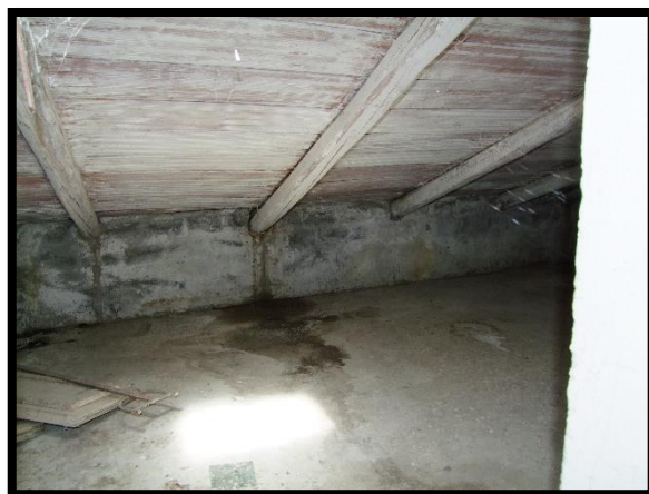
F. 40: INTERNO DELLA SOFFITTA UBICATA AL PIANO 3° SOTTOTETTO DI VIA FRANCESCO CRISPI, N. 2, MONTECILFONE (CB), P.LLA 161 SUB. 4 GRAFFATA ALLA P.LLA 499 SUB. 4
