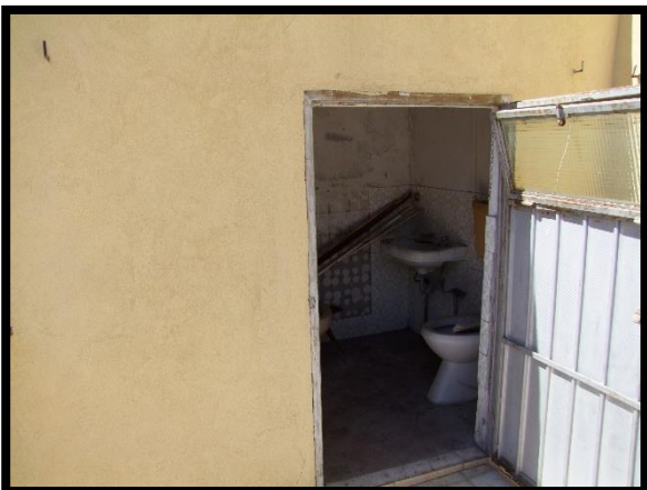
F. 29: INGRESSO DEL W.C. UBICATO AL PIANO 2° DI VIA FRANCESCO CRISPI, N. 2 – MONTECILFONE (CB), P.LLA 161 SUB. 4 GRAFFATA ALLA P.LLA 499 SUB. 4 (CAUTELATIVAMENTE VALUTATO COME TERRAZZO PERCHÉ PROBABILMENTE È STATO COSTRUITO SUCCESSIVAMENTE AL 1967)
