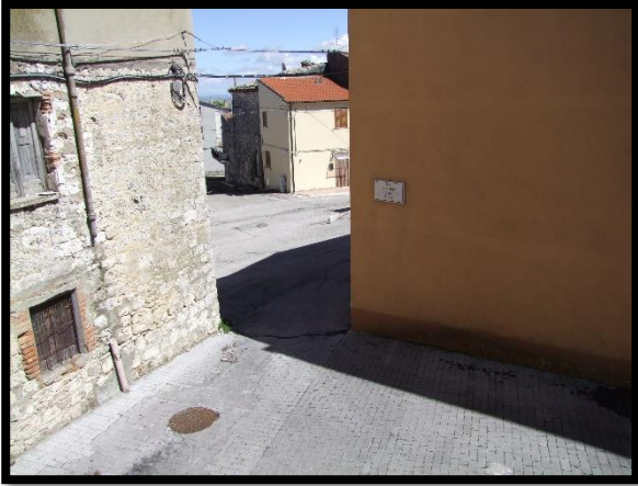
F. 19: VISTA DALL'ABITAZIONE UBICATA AL PIANO 1° DI VIA FRANCESCO CRISPI, N. 2 – MONTECILFONE (CB), P.LLA 161 SUB. 4 GRAFFATA ALLA P.LLA 499 SUB. 4
