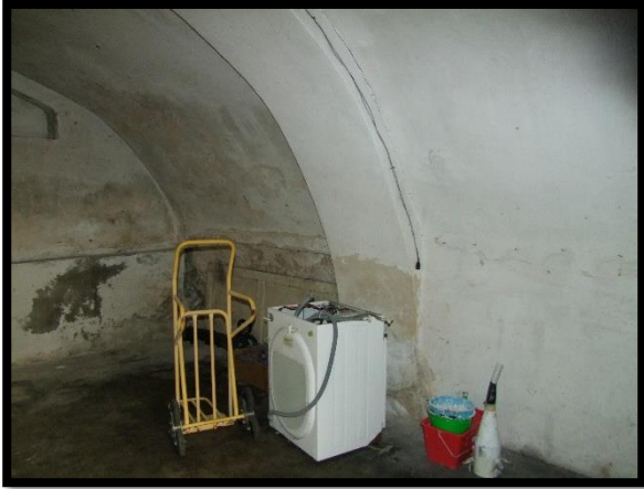
F. 49: INGRESSO DELLA CANTINA UBICATA AL PIANO TERRA DI VIA GIUSEPPE GARIBALDI, S.N.C. – MONTECILFONE (CB), P.LLA 161 SUB. 4 GRAFFATA ALLA P.LLA 499 SUB. 4
