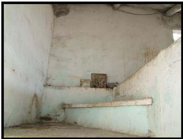
F. 37: ACCESSO ALLA SOFFITTA UBICATA AL PIANO 3° SOTTOTETTO DI VIA FRANCESCO CRISPI, N. 2, MONTECILFONE (CB), P.LLA 161 SUB. 4 GRAFFATA ALLA P.LLA 499 SUB. 4
