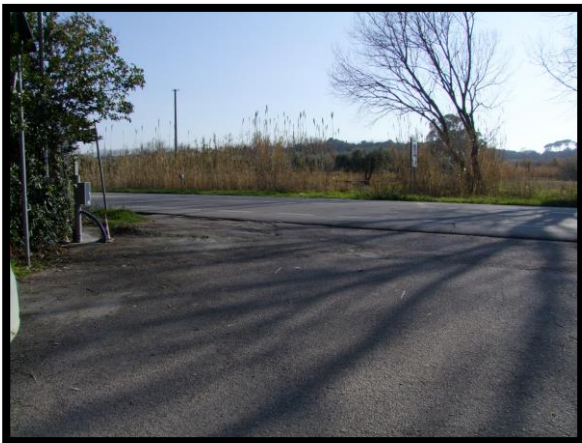
F. 03: ACCESSO AL FABBRICATO PLURIFAMILIARE DA VIA EMILIO BALDACCI, LOCALITÀ MARINELLE – VASTO (CH)
