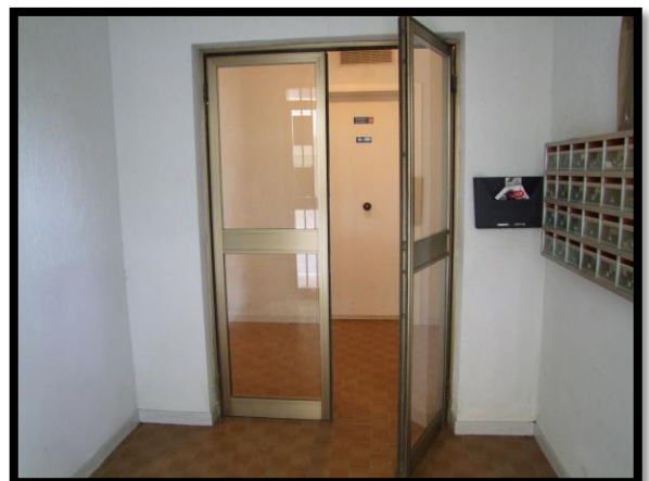
F. 12: ANDRONE COMUNE UBICATO AL PIANO TERRA DEL FABBRICATO "3" IN VIA EMILIO BALDACCI, N. 30, LOCALITÀ MARINELLE – VASTO (CH), P.LLA 4221
