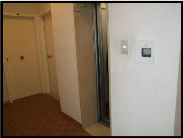
F. 15: ASCENSORE COMUNE UBICATO AL PIANO 3° DEL FABBRICATO "3" IN VIA EMILIO BALDACCI, N. 30, LOCALITÀ MARINELLE – VASTO (CH), P.LLA 4221
