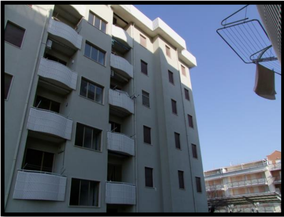
F. 09: FABBRICATO PLURIFAMILIARE UBICATO IN VIA EMILIO BALDACCI, N. 30, FABBRICATO "3", LOCALITÀ MARINELLE – VASTO (CH), P.LLA 4221
