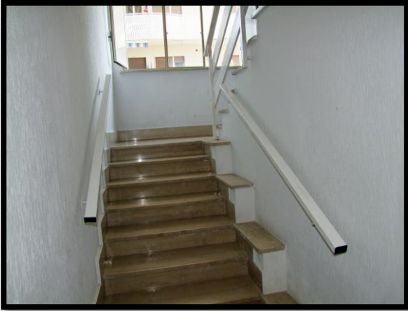
F. 13: ACCESSO ALL'APPARTAMENTO INTERNO "16" UBICATO AL PIANO 3° DEL FABBRICATO "3" IN VIA EMILIO BALDACCI, N. 30, LOCALITÀ MARINELLE – VASTO (CH), P.LLA 4221
