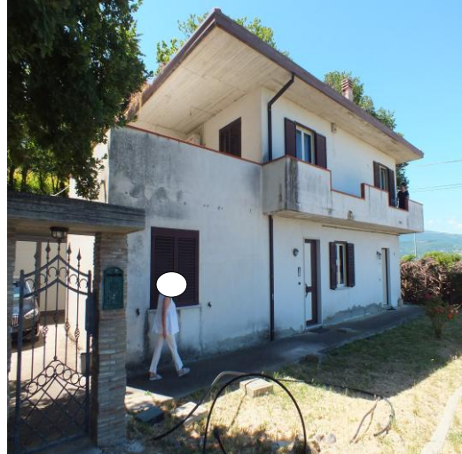
FOTO: 44: RELATIVA AL 2° SOPRALLUOGO DEL 30/06/2025
