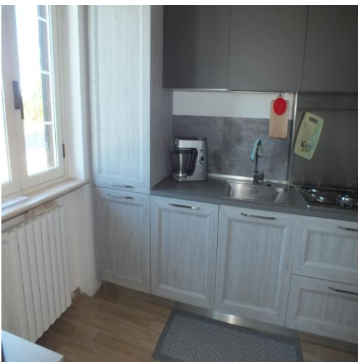
FOTO: 51: RELATIVA AL 2° SOPRALLUOGO DEL 30/06/2025
