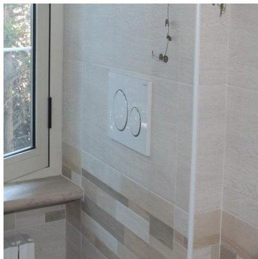
FOTO: 56: RELATIVA AL 2° SOPRALLUOGO DEL 30/06/2025
