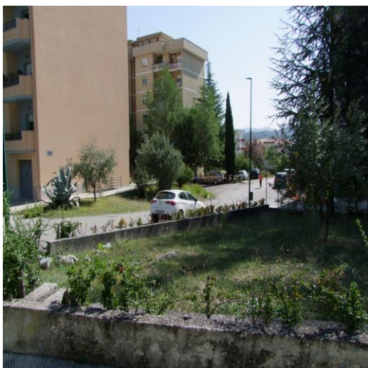
FOTO 03: ACCESSO AL FABBRICATO PLURIFAMILIARE DA VIA ANDREA MANTEGNA, QUARTIERE SAN LAZZARO, ISERNIA (IS)
