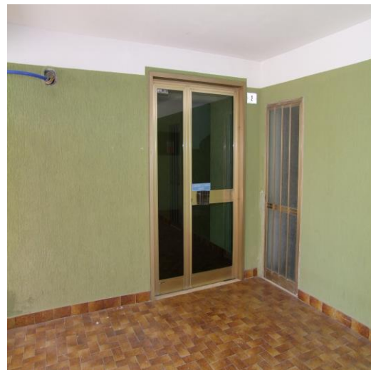
FOTO 12: INGRESSO COMUNE AL FABBRICATO PLURIFAMILIARE POSTO AL PIANO TERRA DI VIA ANDREA MANTEGNA, N. 2, ISERNIA (IS), P.LLA 372
