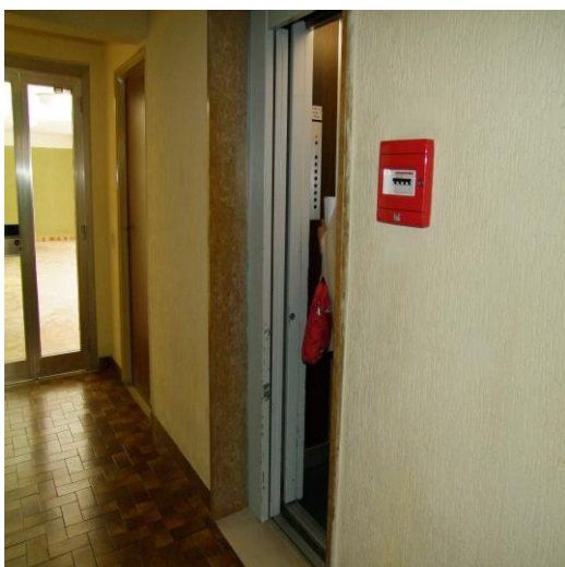
FOTO 15: ASCENSORE COMUNE AL FABBRICATO PLURIFAMILIARE POSTO AL PIANO TERRA DI VIA ANDREA MANTEGNA, N. 2, ISERNIA (IS), P.LLA 372
