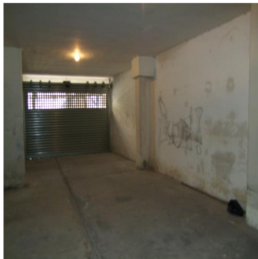
FOTO 60: ACCESSO AL GARAGE UBICATO AL PIANO INTERRATO, DI VIA ANDREA MANTEGNA, N. 2, ISERNIA (IS), P.LLA 372
