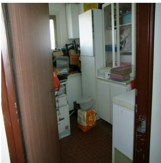
FOTO 55: INTERNO DELLA SOFFITTA INTERNO "7" UBICATO AL PIANO 7° SOTTOTETTO, DI VIA ANDREA MANTEGNA, N. 2, ISERNIA (IS), P.LLA 372 SUB. 21 (A/3)
