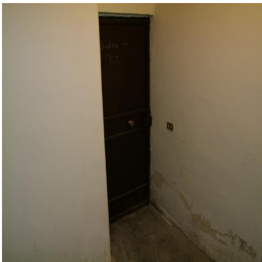
FOTO 59: ACCESSO AL GARAGE E CANTINA UBICATI AL PIANO INTERRATO, DI VIA ANDREA MANTEGNA, N. 2, ISERNIA (IS), P.LLA 372
