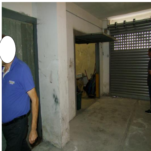
FOTO 61: INGRESSO DEL GARAGE UBICATO AL PIANO INTERRATO, DI VIA ANDREA MANTEGNA, N. 2, ISERNIA (IS), P.LLA 372 SUB. 1 (C/6)
