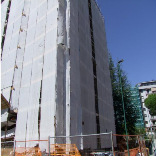
FOTO 05: FABBRICATO PLURIFAMILIARE UBICATO IN VIA ANDREA MANTEGNA, N. 2, QUARTIERE SAN LAZZARO, ISERNIA (IS), P.LLA 372, FABBRICATO OGGETTO DI CILAS N. 45262 DELL'11/11/2022 (SUPERBONUS 110%)
