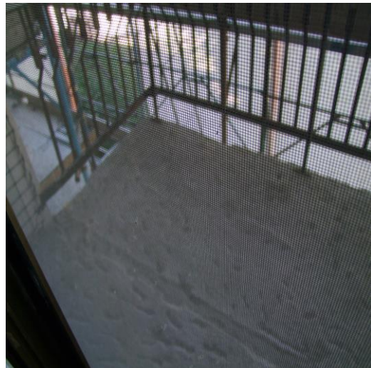
FOTO 24: BALCONE DELLA CUCINA UBICATO AL PIANO 5°, INTERNO "10", DI VIA ANDREA MANTEGNA, N. 2, ISERNIA (IS), P.LLA 372 SUB. 21 (A/3)
