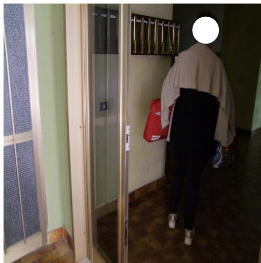
FOTO 14: INGRESSO COMUNE AL FABBRICATO PLURIFAMILIARE POSTO AL PIANO TERRA DI VIA ANDREA MANTEGNA, N. 2, ISERNIA (IS), P.LLA 372
