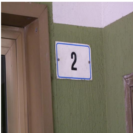
FOTO 13: INGRESSO COMUNE AL FABBRICATO PLURIFAMILIARE POSTO AL PIANO TERRA DI VIA ANDREA MANTEGNA, N. 2, ISERNIA (IS), P.LLA 372
