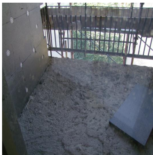
FOTO 44: BALCONE DELLA CAMERA DA LETTO "2", UBICATO AL PIANO 5°, INTERNO "10", DI VIA ANDREA MANTEGNA, N. 2, ISERNIA (IS), P.LLA 372 SUB. 21 (A/3)
