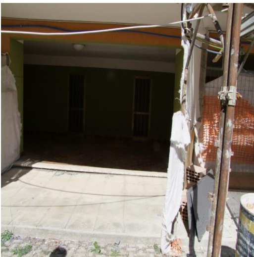
FOTO 11: INGRESSO COMUNE AL FABBRICATO PLURIFAMILIARE POSTO AL PIANO TERRA DI VIA ANDREA MANTEGNA, N. 2, ISERNIA (IS), P.LLA 372
