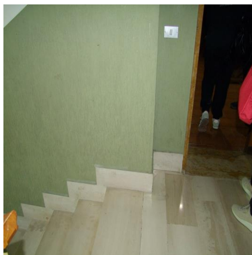
FOTO 16: ACCESSO ALL'APPARTAMENTO UBICATO AL PIANO 5°, INTERNO "10", DI VIA ANDREA MANTEGNA, N. 2, ISERNIA (IS), P.LLA 372
