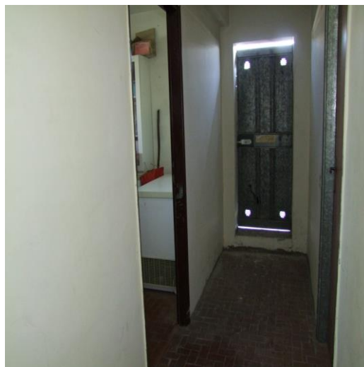
FOTO 54: ACCESSO ALLA SOFFITTA INTERNO "7" UBICATA AL PIANO 7° SOTTOTETTO, DI VIA ANDREA MANTEGNA, N. 2, ISERNIA (IS), P.LLA 372
