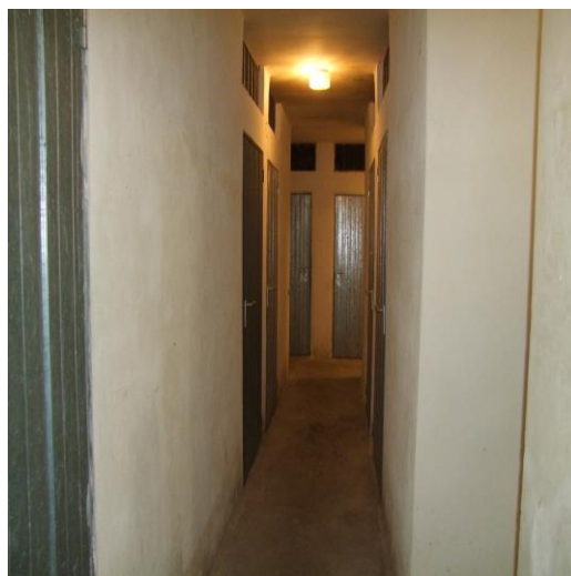
FOTO 64: ACCESSO ALLA CANTINA UBICATA AL PIANO INTERRATO, DI VIA ANDREA MANTEGNA, N. 2, ISERNIA (IS), P.LLA 372
