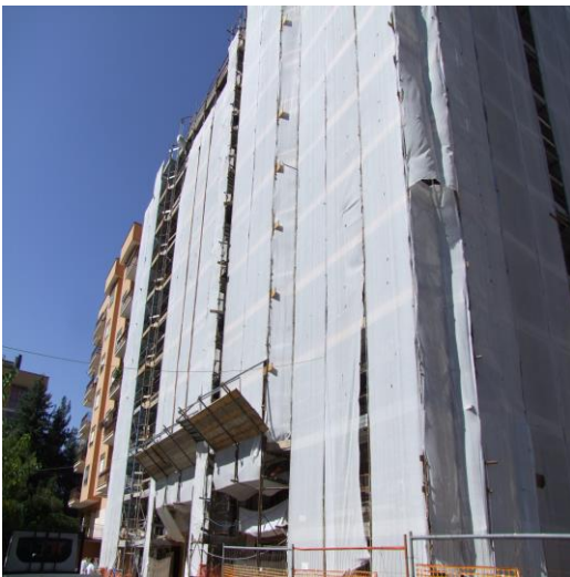
FOTO 07: FABBRICATO PLURIFAMILIARE UBICATO IN VIA ANDREA MANTEGNA, N. 2, QUARTIERE SAN LAZZARO, ISERNIA (IS), P.LLA 372, FABBRICATO OGGETTO DI CILAS N. 45262 DELL'11/11/2022 (SUPERBONUS 110%)
