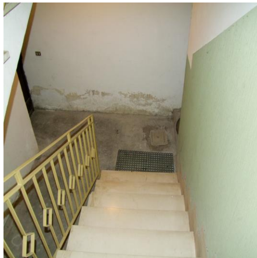
FOTO 58: ACCESSO AL GARAGE E CANTINA UBICATI AL PIANO INTERRATO, DI VIA ANDREA MANTEGNA, N. 2, ISERNIA (IS), P.LLA 372
