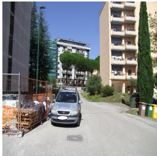
FOTO 08: FABBRICATO PLURIFAMILIARE UBICATO IN VIA ANDREA MANTEGNA, N. 2, QUARTIERE SAN LAZZARO, ISERNIA (IS), P.LLA 372, FABBRICATO OGGETTO DI CILAS N. 45262 DELL'11/11/2022 (SUPERBONUS 110%)
