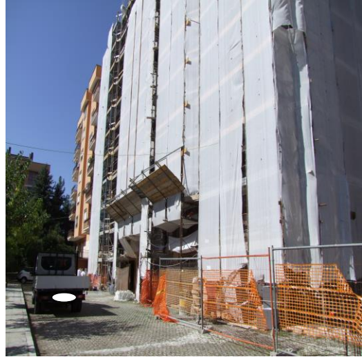
FOTO 06: FABBRICATO PLURIFAMILIARE UBICATO IN VIA ANDREA MANTEGNA, N. 2, QUARTIERE SAN LAZZARO, ISERNIA (IS), P.LLA 372, FABBRICATO OGGETTO DI CILAS N. 45262 DELL'11/11/2022 (SUPERBONUS 110%)
