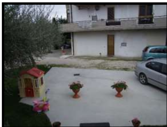
F. 06: CORTE COMUNE UBICATA AL PIANO TERRA IN VIA CASTELLATA, N. 284, LOCALITÀ BRECCIAIO, SANT'EUSANIO DEL SANGRO (CH), P.LLA 4115 SUB. 1 (B.C.N.C.)
