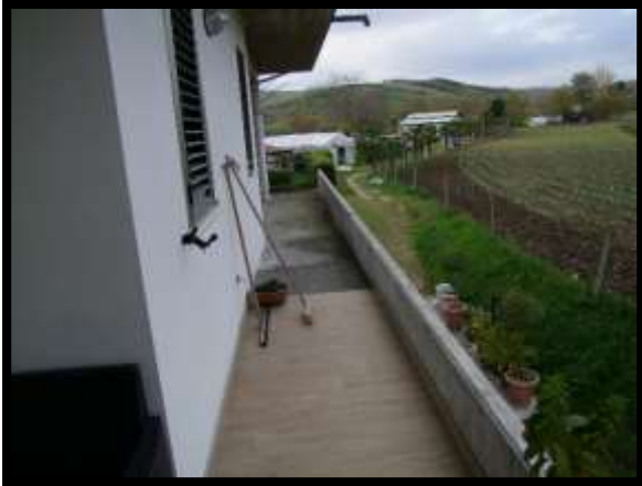
F. 13: BALCONE DELL'ABITAZIONE UBICATO AL PIANO TERRA IN VIA CASTELLATA, N. 284, LOCALITÀ BRECCIAIO, SANT'EUSANIO DEL SANGRO (CH), P.LLA 4115 SUB. 6 (A/3)
