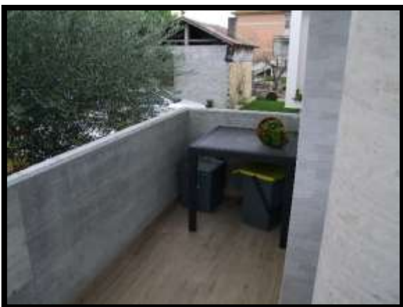
F. 17: BALCONE DELL'ABITAZIONE UBICATO AL PIANO TERRA IN VIA CASTELLATA, N. 284, LOCALITÀ BRECCIAIO, SANT'EUSANIO DEL SANGRO (CH), P.LLA 4115 SUB. 6 (A/3)
