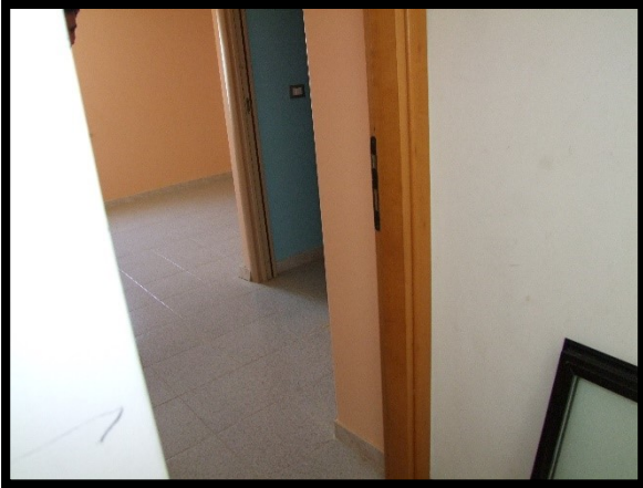
F. 25: INGRESSO DELLA SOFFITTA UBICATA AL PIANO 3° SOTTOTETTO DELLA SCALA "B" IN VIA DEI GERANI, N. 5 TERMOLI (CB), P.LLA 649 SUB. 30 (A/3)
