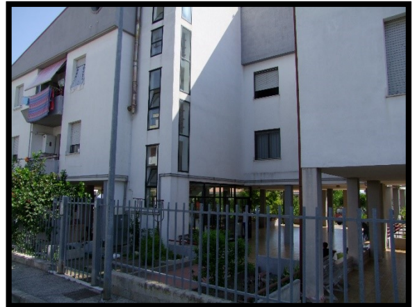
F. 04: FABBRICATO PLURIFAMILIARE UBICATO IN VIA DEI GERANI – TERMOLI (CB), P.LLA 649
