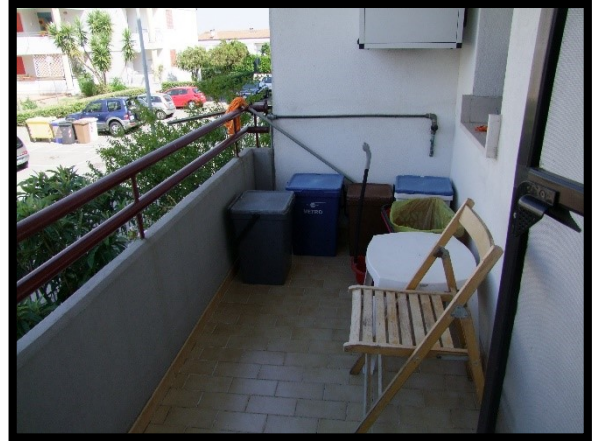
F. 14: BALCONE DELL'APPARTAMENTO N. "4" UBICATO AL PIANO 1° DELLA SCALA "B" IN VIA DEI GERANI, N. 5 TERMOLI (CB), P.LLA 649 SUB. 30 (A/3)
