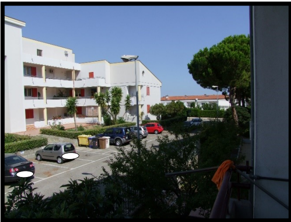
F. 15: VISTA DALL'APPARTAMENTO N. "4" UBICATO AL PIANO 1° DELLA SCALA "B" IN VIA DEI GERANI, N. 5 TERMOLI (CB), P.LLA 649 SUB. 30 (A/3)
