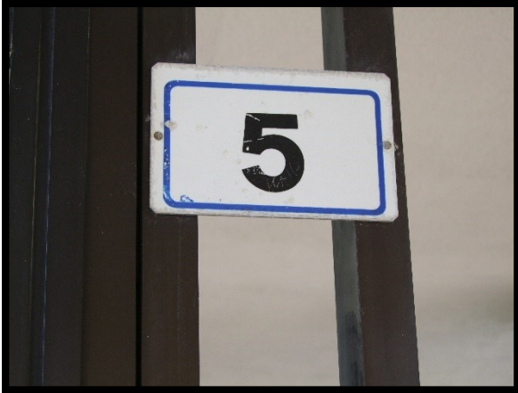
F. 07: INGRESSO COMUNE UBICATO AL PIANO TERRA DELLA SCALA "B" IN VIA DEI GERANI, N. 5 – TERMOLI (CB), P.LLA 649
