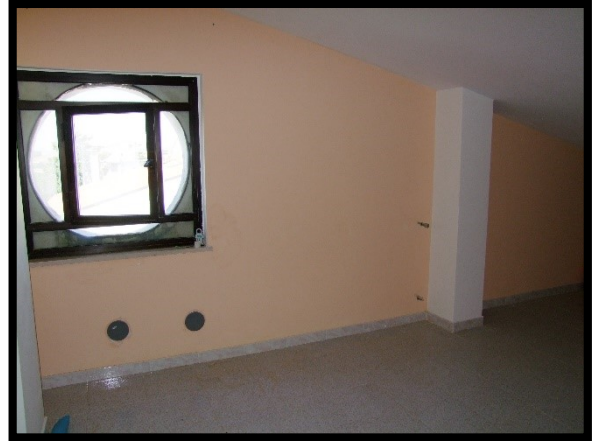
F. 26: INTERNO DELLA SOFFITTA UBICATA AL PIANO 3° SOTTOTETTO DELLA SCALA "B" IN VIA DEI GERANI, N. 5 TERMOLI (CB), P.LLA 649 SUB. 30 (A/3)
