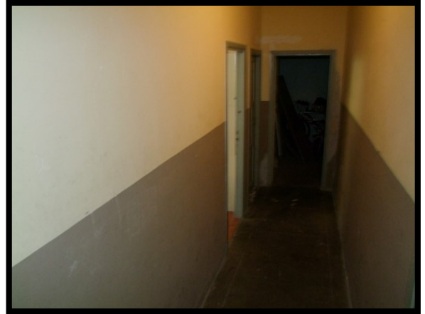
F. 20: ACCESSO ALLA CANTINA UBICATA AL PIANO SEMINTERRATO IN VIA MARIO MILANO, N. 4 – ISERNIA (IS), P.LLA 217
