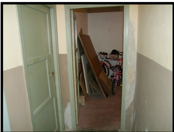
F. 23: ACCESSO AL LOCALE COMUNE RIMESSA MOTO UBICATO AL PIANO SEMINTERRATO IN VIA MARIO MILANO, N. 4 –ISERNIA (IS), P.LLA 217 (NON VALUTATO PERCHÉ TRATTASI DI LOCALE COMUNE)
