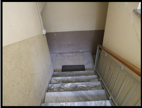
F. 19: ACCESSO ALLA CANTINA UBICATA AL PIANO SEMINTERRATO IN VIA MARIO MILANO, N. 4 – ISERNIA (IS), P.LLA 217
