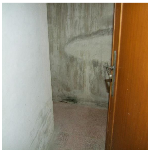
FOTO 40: ACCESSO AL LOCALE DEPOSITO UBICATO AL PIANO TERRA, P.LLA 1093
