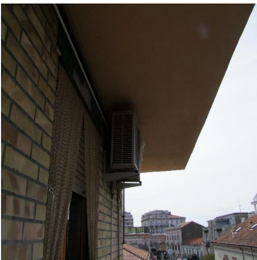
FOTO 19: BALCONE DELLA CUCINA/PRANZO UBICATO AL PIANO 4°, P.LLA 1093 SUB. 20 (A/2)
