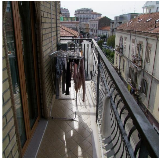
FOTO 18: BALCONE DELLA CUCINA/PRANZO UBICATO AL PIANO 4°, P.LLA 1093 SUB. 20 (A/2)
