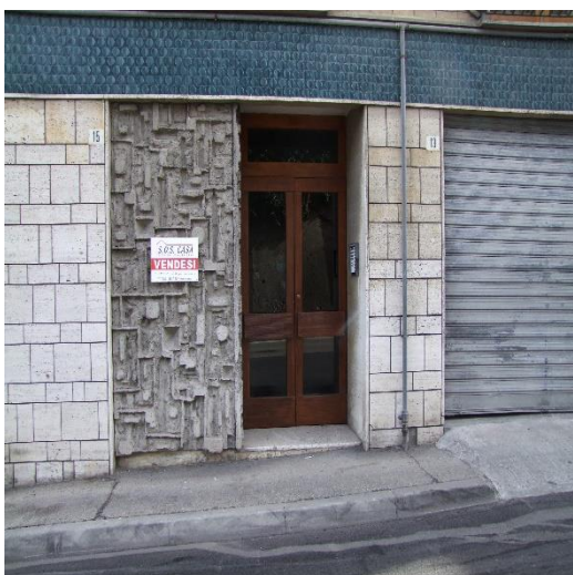
FOTO 07: FABBRICATO PLURIFAMILIARE UBICATO IN VIA LUIGI DOMMARCO, N. 15, P.LLA 1093
