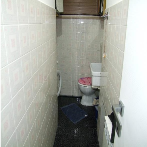
FOTO 33: INTERNO DEL W.C. UBICATO AL PIANO 4°, P.LLA 1093 SUB. 20 (A/2)
