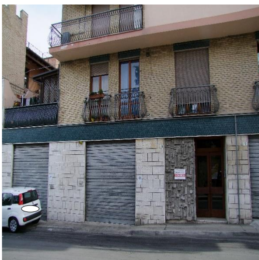
FOTO 03: FABBRICATO PLURIFAMILIARE UBICATO IN VIA LUIGI DOMMARCO, N. 15, P.LLA 1093
