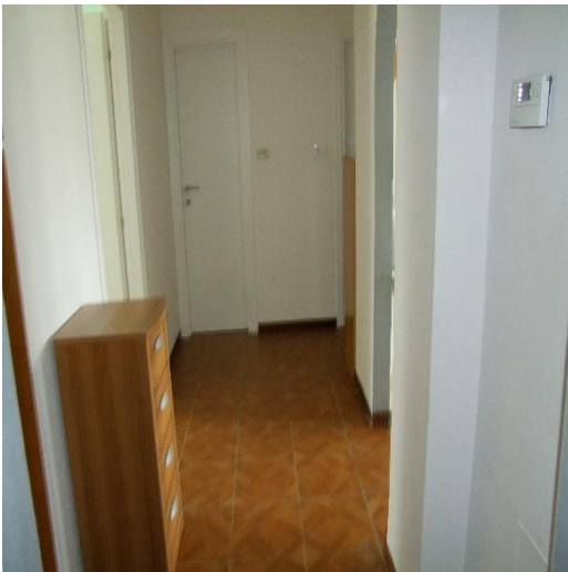
FOTO 15: INTERNO DEL DISIMPEGNO UBICATO AL PIANO 4°, P.LLA 1093 SUB. 20 (A/2)
