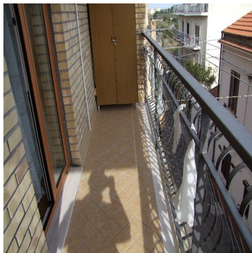
FOTO 26: BALCONE DELLA CAMERA "2" UBICATO AL PIANO 4°, P.LLA 1093 SUB. 20 (A/2)
