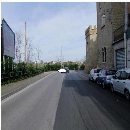
FOTO 01: ACCESSO AL FABBRICATO PLURIFAMILIARE DA VIA LUIGI DOMMARCO – ORTONA (CH)
