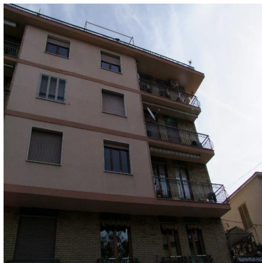
FOTO 06: FABBRICATO PLURIFAMILIARE UBICATO IN VIA LUIGI DOMMARCO, N. 15, P.LLA 1093
