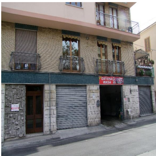
FOTO 05: FABBRICATO PLURIFAMILIARE UBICATO IN VIA LUIGI DOMMARCO, N. 15, P.LLA 1093
