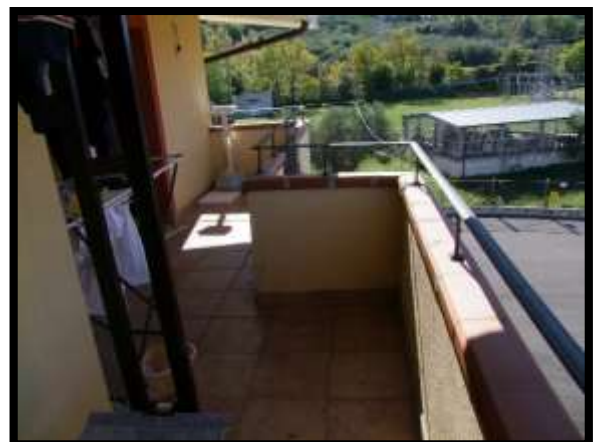
F. 36: BALCONE DELLA MANSARDA UBICATO AL PIANO 3° SOTTOTETTO IN VIA FRANCESCO VERLENGIA, N. 22, LOCALITÀ SELVA DI ALTINO – ALTINO (CH), P.LLA 4074 SUB. 5 (A/2)
