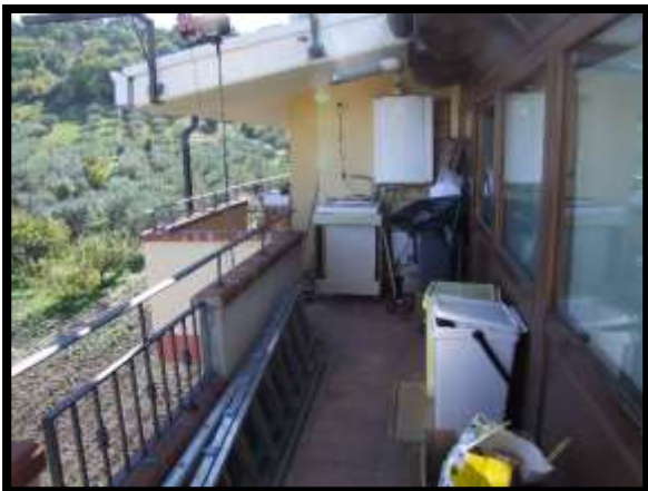
F. 21: BALCONE DELLA MANSARDA UBICATO AL PIANO 3° SOTTOTETTO IN VIA FRANCESCO VERLENGIA, N. 22, LOCALITÀ SELVA DI ALTINO – ALTINO (CH), P.LLA 4074 SUB. 5 (A/2)
