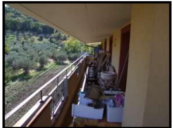
F. 22: BALCONE DELLA MANSARDA UBICATO AL PIANO 3° SOTTOTETTO IN VIA FRANCESCO VERLENGIA, N. 22, LOCALITÀ SELVA DI ALTINO – ALTINO (CH), P.LLA 4074 SUB. 5 (A/2)
