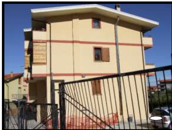
F. 02: FABBRICATO PLURIFAMILIARE UBICATO IN VIA FRANCESCO VERLENGIA, N. 22, LOCALITÀ SELVA DI ALTINO, ALTINO (CH), P.LLA 4074
