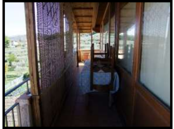
F. 20: BALCONE DELLA MANSARDA UBICATO AL PIANO 3° SOTTOTETTO IN VIA FRANCESCO VERLENGIA, N. 22, LOCALITÀ SELVA DI ALTINO – ALTINO (CH), P.LLA 4074 SUB. 5 (A/2)
