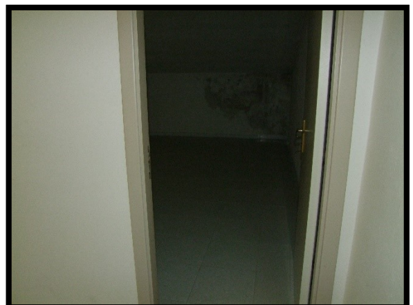
F. 24: INTERNO DELLA SOFFITTA UBICATA AL PIANO 1° SOTTOTETTO IN CONTRADA SANTA LIBERATA, N. 162, LANCIANO (CH), P.LLA 443 SUB. 5 (A/3)
