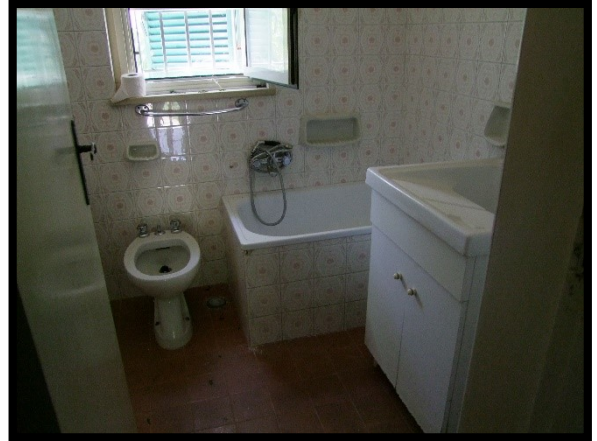
F. 20: INTERNO DEL W.C. UBICATO AL PIANO TERRA IN CONTRADA SANTA LIBERATA, N. 162 – LANCIANO (CH), P.LLA 443 SUB. 5 (A/3)
