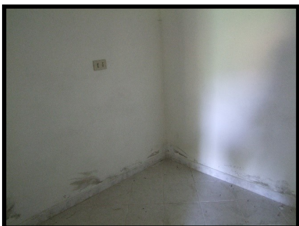
F. 35: INTERNO DEL RIPOSTIGLIO UBICATO AL PIANO SEMINTERRATO IN CONTRADA SANTA LIBERATA, N. 162, LANCIANO (CH), P.LLA 443 SUB. 4 (C/2)
