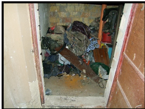
F. 40: INTERNO DEL RIPOSTIGLIO UBICATO AL PIANO SEMINTERRATO IN CONTRADA SANTA LIBERATA, N. 162, LANCiano (CH), P.LLA 443 SUB. 4 (C/2)
