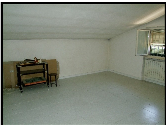
F. 23: INTERNO DELLA SOFFITTA UBICATA AL PIANO 1° SOTTOTETTO IN CONTRADA SANTA LIBERATA, N. 162, LANCIANO (CH), P.LLA 443 SUB. 5 (A/3)
