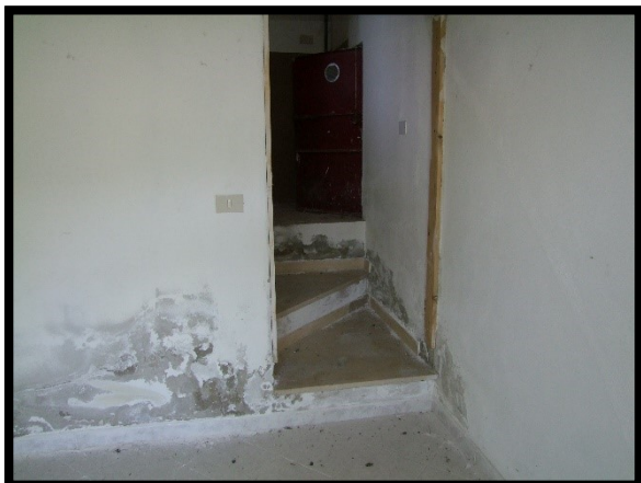
F. 39: ACCESSO AL RIPOSTIGLIO UBICATO AL PIANO SEMINTERRATO IN CONTRADA SANTA LIBERATA, N. 162, LANCiano (CH), P.LLA 443 SUB. 4 (C/2)
