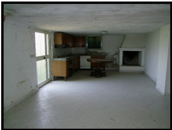
F. 33: INTERNO DELLA CANTINA UBICATA AL PIANO SEMINTERRATO IN CONTRADA SANTA LIBERATA, N. 162, LANCIANO (CH), P.LLA 443 SUB. 4 (C/2)
