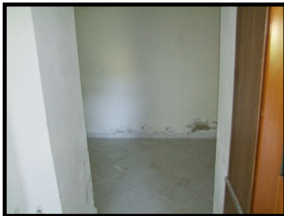
F. 34: INTERNO DEL RIPOSTIGLIO UBICATO AL PIANO SEMINTERRATO IN CONTRADA SANTA LIBERATA, N. 162, LANCIANO (CH), P.LLA 443 SUB. 4 (C/2)
