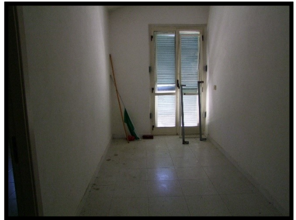
F. 22: INTERNO DELLA SOFFITTA UBICATA AL PIANO 1° SOTTOTETTO IN CONTRADA SANTA LIBERATA, N. 162, LANCIANO (CH), P.LLA 443 SUB. 5 (A/3)
