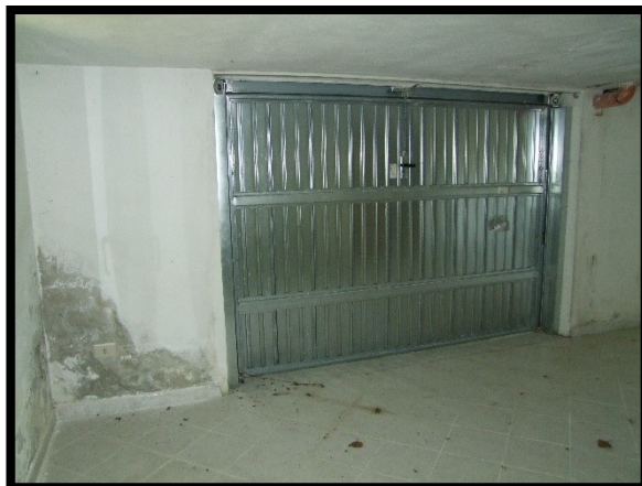
F. 32: INTERNO DELLA CANTINA UBICATA AL PIANO SEMINTERRATO IN CONTRADA SANTA LIBERATA, N. 162, LANCIANO (CH), P.LLA 443 SUB. 4 (C/2)
