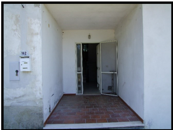
F. 07: INGRESSO PRINCIPALE UBICATO AL PIANO TERRA IN CONTRADA SANTA LIBERATA, N. 162 – LANCIANO (CH), P.LLA 443 SUB. 5 (A/3)
