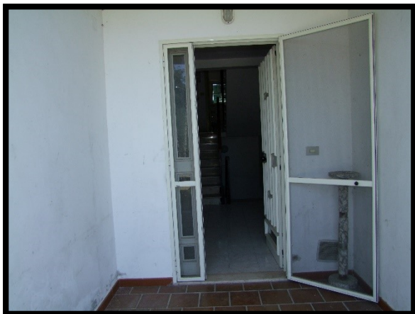
F. 09: INGRESSO PRINCIPALE UBICATO AL PIANO TERRA IN CONTRADA SANTA LIBERATA, N. 162 – LANCIANO (CH), P.LLA 443 SUB. 5 (A/3)
