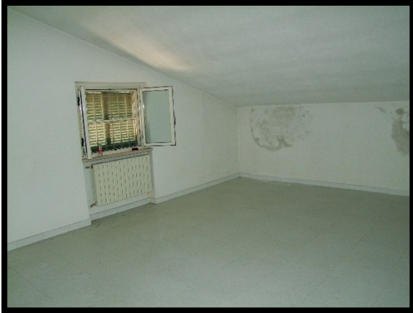
F. 25: INTERNO DELLA SOFFITTA UBICATA AL PIANO 1° SOTTOTETTO IN CONTRADA SANTA LIBERATA, N. 162, LANCIANO (CH), P.LLA 443 SUB. 5 (A/3)
