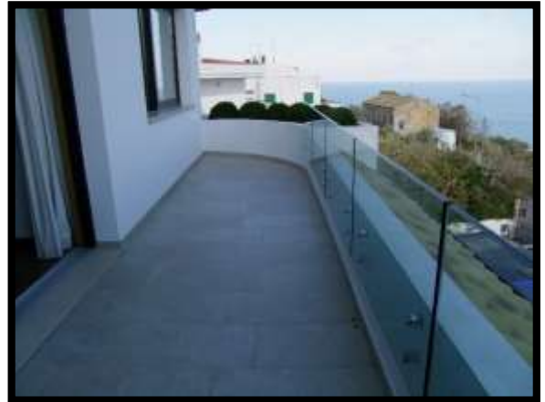
F. 80: TERRAZZO DELL'APPARTAMENTO UBICATO AL PIANO 1° IN VIA SANTA LUCIA, N. 85 – VASTO (CH), P.LLA 3534 SUB. 7 (A/7)
