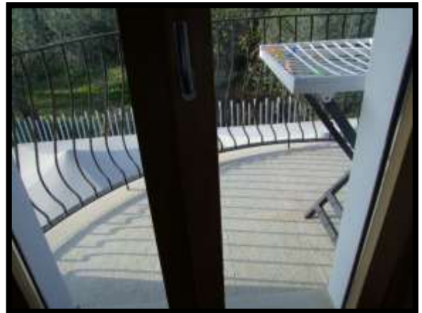
F. 86: BALCONE DELL'APPARTAMENTO UBICATO AL PIANO 1° IN VIA SANTA LUCIA, N. 85 – VASTO (CH), P.LLA 3534 SUB. 7 (A/7)
