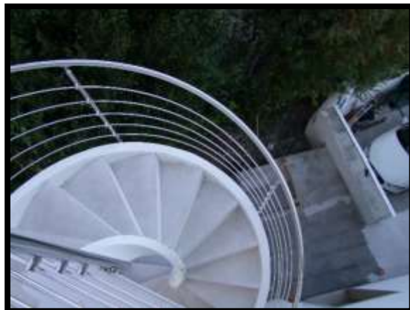
F. 90: ACCESSO ALLA MANSARDA UBICATA AL PIANO 2° SOTTOTETTO IN VIA SANTA LUCIA, N. 85 – VASTO (CH), P.LLA 3534 SUB. 8 (A/7)
