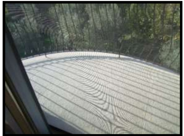
F. 98: BALCONE DELLA MANSARDA UBICATO AL PIANO 2° SOTTOTETTO IN VIA SANTA LUCIA, N. 85 – VASTO (CH), P.LLA 3534 SUB. 8 (A/7)
