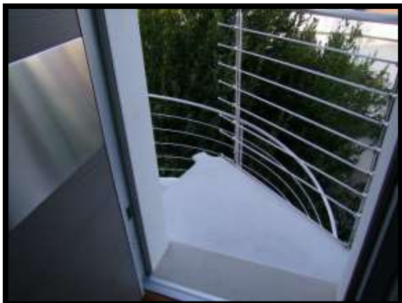
F. 89: INGRESSO DELLA MANSARDA UBICATA AL PIANO 2° SOTTOTETTO IN VIA SANTA LUCIA, N. 85 – VASTO (CH), P.LLA 3534 SUB. 8 (A/7)
