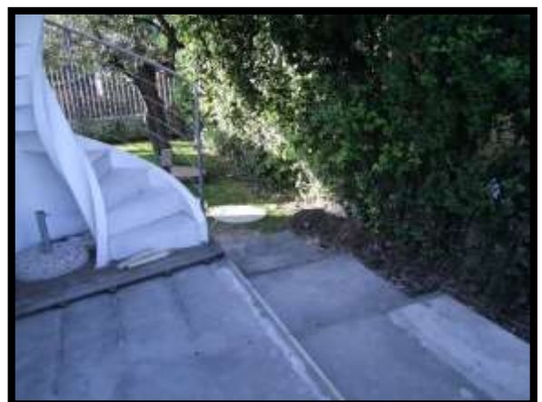
F. 100: ACCESSO ALLA MANSARDA UBICATA AL PIANO 2° SOTTOTETTO IN VIA SANTA LUCIA, N. 85 – VASTO (CH), P.LLA 3534 SUB. 8 (A/7), DAL PIANO TERRA
