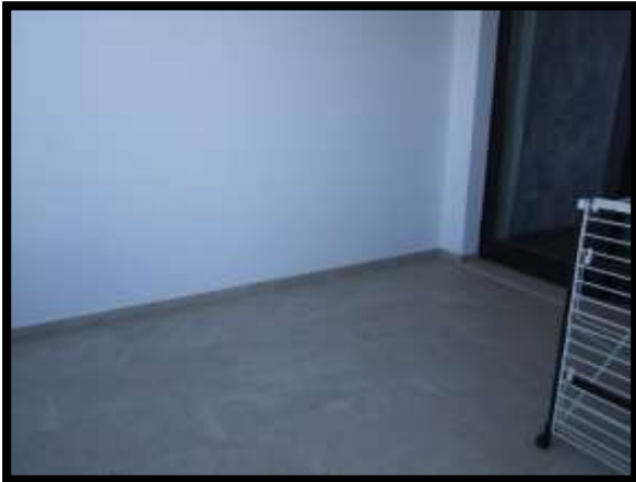
F. 79: TERRAZZO DELL'APPARTAMENTO UBICATO AL PIANO 1° IN VIA SANTA LUCIA, N. 85 – VASTO (CH), P.LLA 3534 SUB. 7 (A/7)
