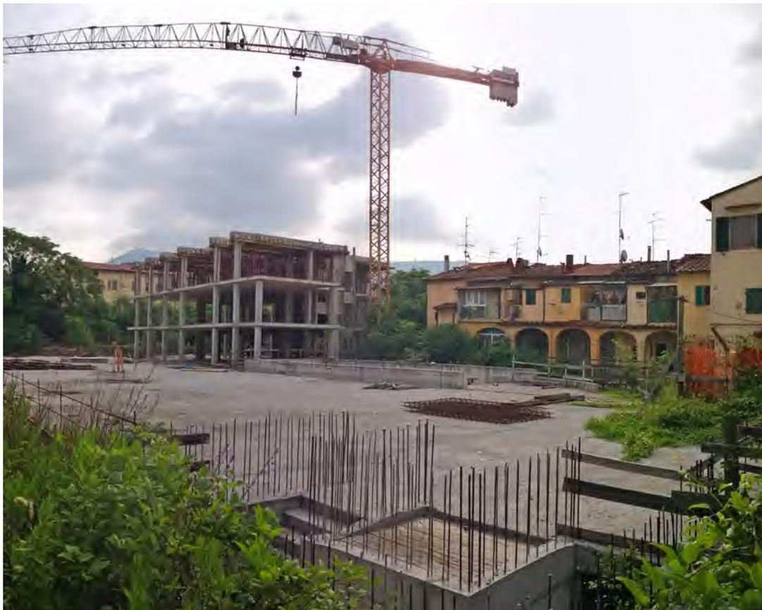
terra, travi e solai solo fino al 2°, mentre del terzo sono stati approntati parzialmente puntelli, casse-rature ed armature delle travi. Ovviamente non è stato eseguito il getto; a titolo esemplificativo della situazione si rinvia alla foto successiva:
