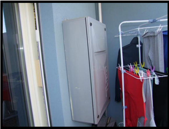
F. 21: INTERNO DELL'APPARTAMENTO POSTO AL PIANO 1°, P.LLA 1597 SUB. 8
