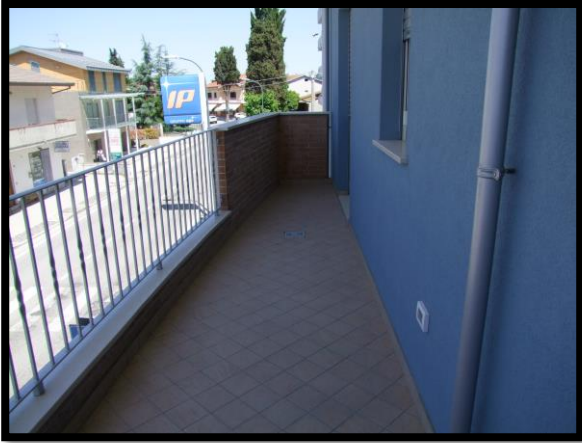
F. 13: BALCONE DELL'APPARTAMENTO POSTO AL PIANO 1°, P.LLA 1597 SUB. 8
