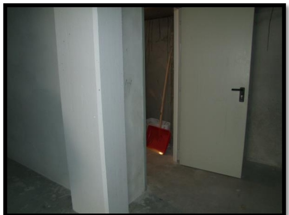
F. 28: ACCESSO ALLA CANTINA POSTA AL PIANO 1° INTERRATO, P.LLA 1597 SUB. 8
