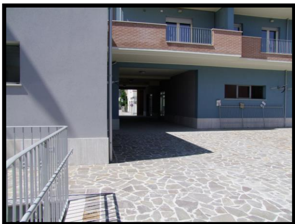
F. 36: ACCESSO AL FABBRICATO PLURIFAMILIARE DA VIA FRANCESCO ROMANI, P.LLA 1597 SUB. 55
