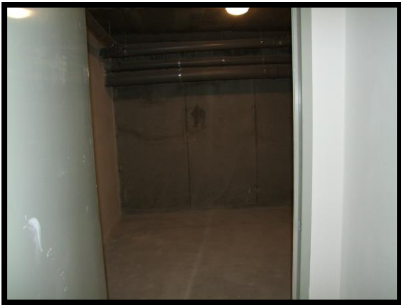
F. 23: INGRESSO DELLA CANTINA POSTA AL PIANO 1° INTERRATO, P.LLA 1597 SUB. 8
