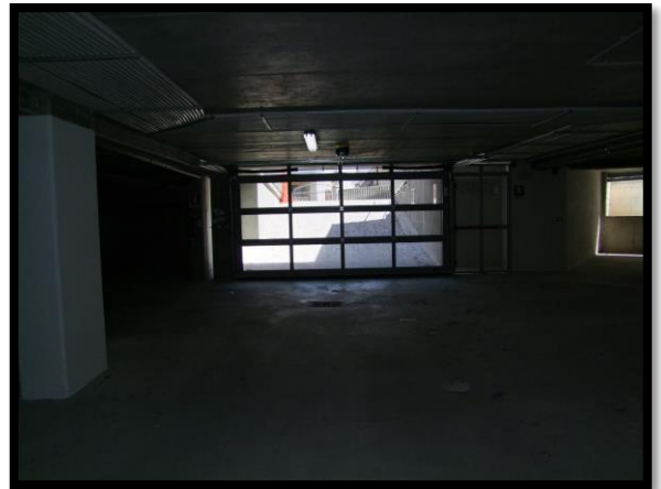
F. 30: ACCESSO CARRABILE DEI POSTI AUTO UBICATI AL PIANO INTERRATO, P.LLA 1597 SUB. 1
