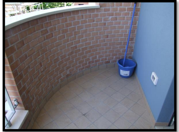
F. 20: BALCONE DELL'APPARTAMENTO POSTO AL PIANO 1°, P.LLA 1597 SUB. 8
