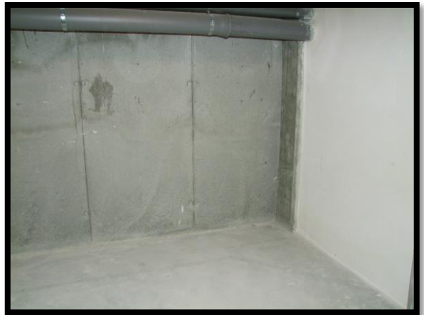
F. 24: INTERNO DELLA CANTINA POSTA AL PIANO 1° INTERRATO, P.LLA 1597 SUB. 8
