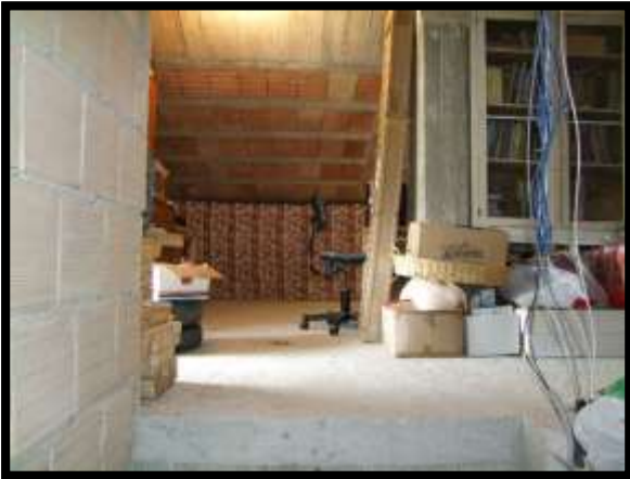
F. 45: INTERNO DELLA SOFFITTA UBICATO AL PIANO 3° SOTTOTETTO IN VIA CIPRANENSE, N. 38 – BUSO (CB), P.LLA 504 SUB. 6 (A/3)
