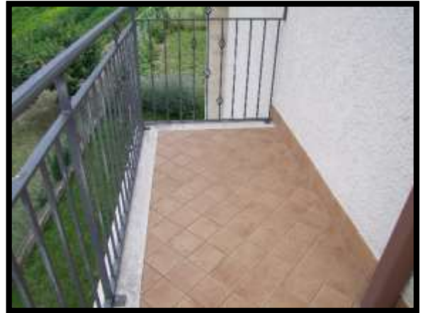
F. 40: BALCONE DELL'ABITAZIONE UBICATO AL PIANO 2° IN VIA CIPRANENSE, N. 38 – BUSSO (CB), P.LLA 504 SUB. 6 (A/3)
