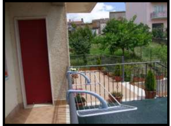
F. 26: BALCONE DELL'ABITAZIONE UBICATO AL PIANO 1° IN VIA CIPRANENSE, N. 38 – BUSSO (CB), P.LLA 504 SUB. 6 (A/3)
