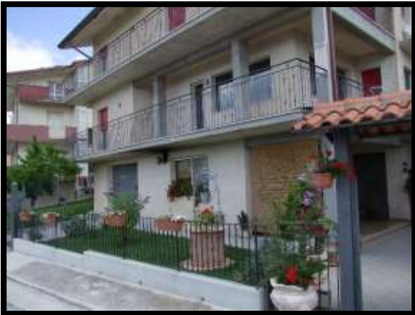
F. 03: FABBRICATO UNIFAMILIARE UBICATO IN VIA CIPRANENSE, N. 38 – BUSO (CB), P.LLE 504 SUB. 5 (C/6) E SUB. 6 (A/3)
