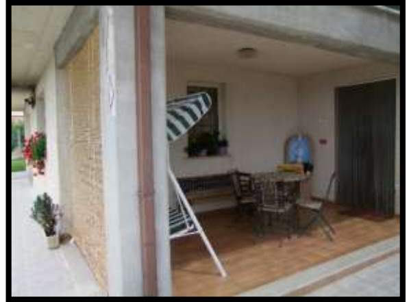
F. 08: PORTICO D'INGRESSO UBICATO AL PIANO TERRA IN VIA CIPRANENSE, N. 38 – BUSSO (CB), P.LLA 504 SUB. 6 (A/3)
