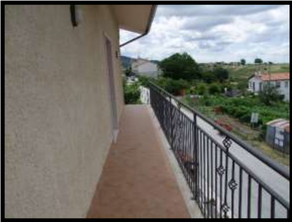
F. 39: BALCONE DELL'ABITAZIONE UBICATO AL PIANO 2° IN VIA CIPRANENSE, N. 38 – BUSSO (CB), P.LLA 504 SUB. 6 (A/3)
