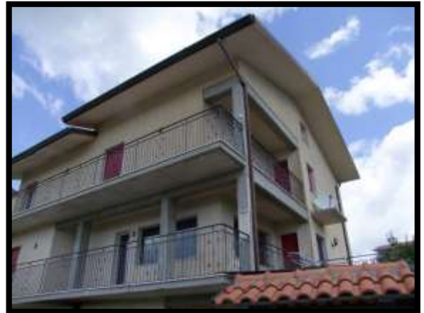
F. 04: FABBRICATO UNIFAMILIARE UBICATO IN VIA CIPRANENSE, N. 38 – BUSO (CB), P.LLE 504 SUB. 5 (C/6) E SUB. 6 (A/3)
