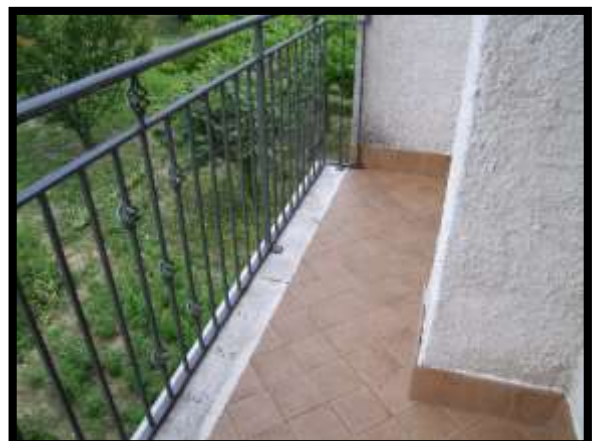
F. 42: BALCONE DELL'ABITAZIONE UBICATO AL PIANO 2° IN VIA CIPRANENSE, N. 38 – BUSSO (CB), P.LLA 504 SUB. 6 (A/3)
