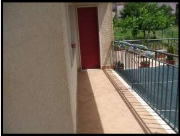
F. 25: BALCONE DELL'ABITAZIONE UBICATO AL PIANO 1° IN VIA CIPRANENSE, N. 38 – BUSSO (CB), P.LLA 504 SUB. 6 (A/3)
