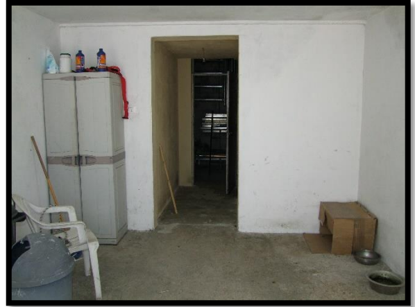
F. 44: INTERNO DEL DEPOSITO UBICATO AL PIANO TERRA IN CONTRADA ICONICELLA, N. 199 – LANCIANO (CH), P.LLA 682 SUB. 13 (C/2)
