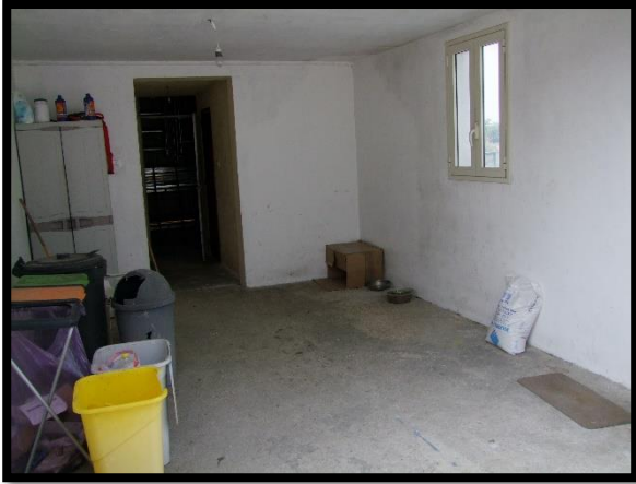
F. 43: INTERNO DEL DEPOSITO UBICATO AL PIANO TERRA IN CONTRADA ICONICELLA, N. 199 – LANCIANO (CH), P.LLA 682 SUB. 13 (C/2)
