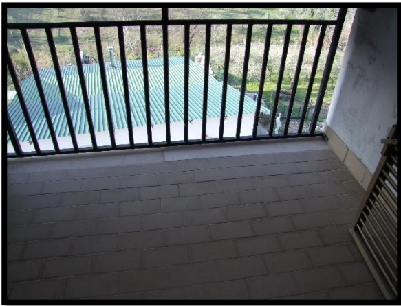
F. 15: BALCONE DELLA MANSARDA UBICATA AL PIANO 2° SOTTOTETTO IN CONTRADA ICONICELLA, N. 199, LANCIANO (CH), P.LLA 682 SUB. 17 (A/3)
