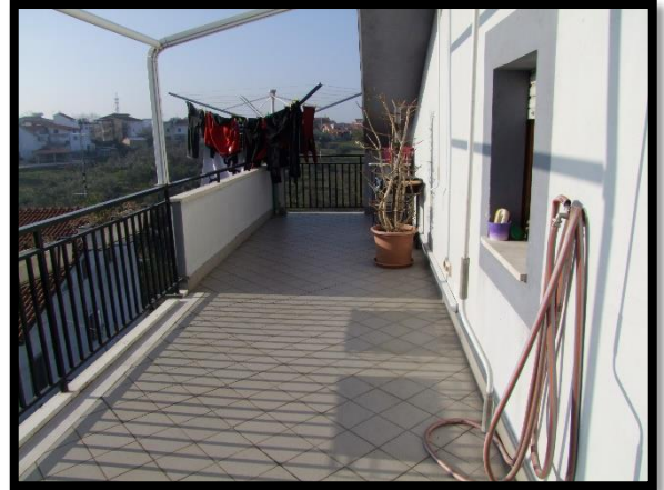
F. 20: BALCONE DELLA MANSARDA UBICATA AL PIANO 2° SOTTOTETTO IN CONTRADA ICONICELLA, N. 199, LANCIANO (CH), P.LLA 682 SUB. 17 (A/3)
