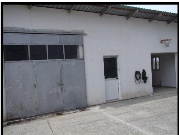
F. 35: ACCESSO AI DEPOSITI UBICATI AL PIANO TERRA IN CONTRADA ICONICELLA, N. 199 – LANCiano (CH), P.LLA 682 SUB. 14 (B.C.N.C.)
