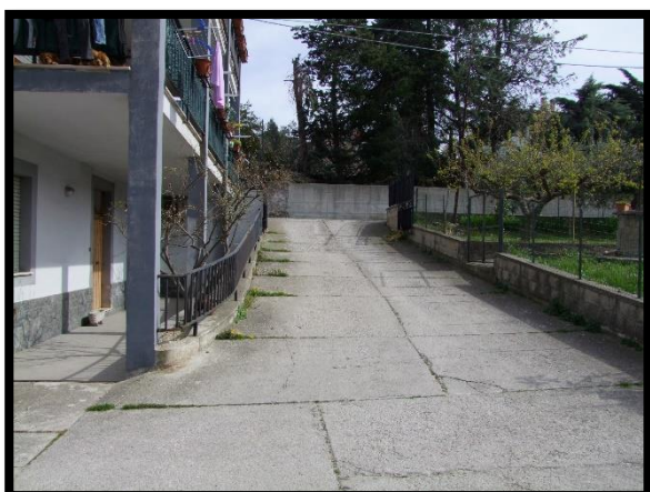
F. 41: ACCESSO AI DEPOSITI UBICATI AL PIANO TERRA IN CONTRADA ICONICELLA, N. 199 – LANCIANO (CH), P.LLA 682 SUB. 14 (B.C.N.C.)
