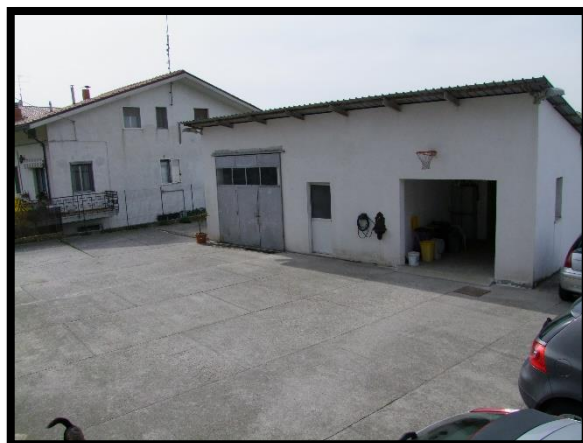
F. 56: VISTA DEI DEPOSITI UBICATI AL PIANO TERRA IN CONTRADA ICONICELLA, N. 199 – LANCIANO (CH), P.LLA 682 SUB. 12 E SUB. 13 (C/2)
