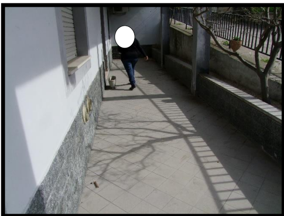
F. 47: PORTICO DEL DEPOSITO UBICATO AL PIANO TERRA IN CONTRADA ICONICELLA, N. 199 – LANCIANO (CH), P.LLA 682 SUB. 15 (C/2)
