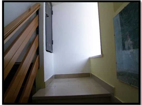
F. 28: ACCESSO AL TERRAZZO UBICATO AL PIANO 3° IN CONTRADA ICONICELLA, N. 199 – LANCIANO (CH), P.LLA 682 SUB. 17 (A/3)
