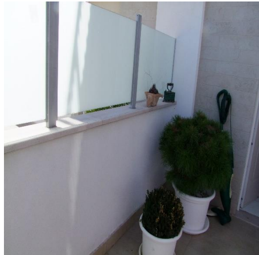
FOTO 08: TERRAZZO D'INGRESSO POSTO AL PIANO TERRA, P.LLA 4213 SUB. 7 (A/7)
