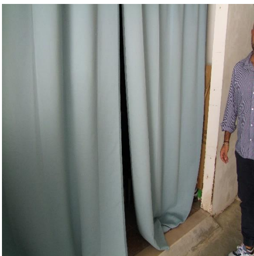
FOTO 47: INGRESSO DEL GARAGE POSTO AL PIANO SEMINTERRATO, P.LLA 4213 SUB. 6 (C/6)
