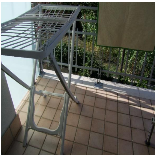
FOTO 25: BALCONE DEL W. C. POSTO AL PIANO 1°, P.LLA 4213 SUB. 7 (A/7)
