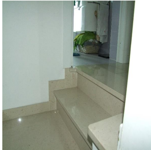
FOTO 22: ACCESSO AI RIPOSTIGLI POSTI AL PIANO 1°, P.LLA 4213 SUB. 7 (A/7)
