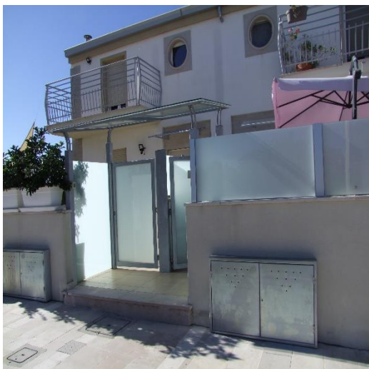
FOTO 03: FABBRICATO UNIFAMILIARE UBICATO IN C.DA SAN MARCO, N. 24, ORTONA (CH), P.LLA 4213 7 (A/7) E SUB. 6 (C/6)
