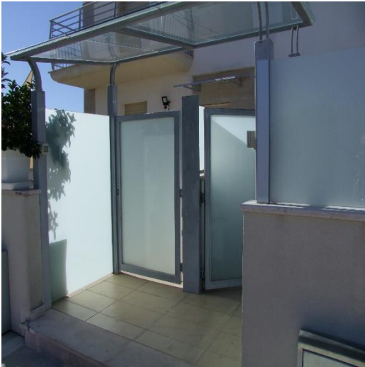
FOTO 05: INGRESSO ALL'ABITAZIONE POSTA AL PIANO TERRA, C.DA SAN MARCO, ORTONA (CH), P.LLA 4213 SUB. 1
