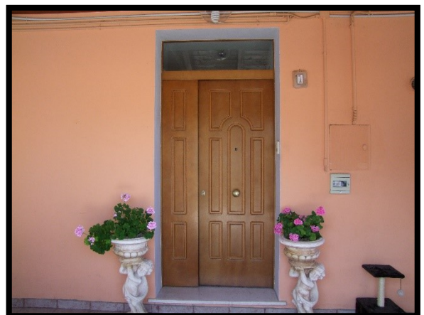
F. 06: INGRESSO COMUNE UBICATO AL PIANO TERRA IN VIA PIANA PELLEGRINA, N. 1 – ORSOGNA (CH), P.LLA 4220 SUB. 1 (B.C.N.C.)
