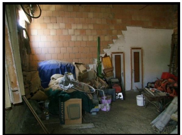
F. 36: INTERNO DEL DEPOSITO UBICATO AL PIANO TERRA IN VIA PIANA PELLEGRINA, N. 1 – ORSOGNA (CH), P.LLA 4220 SUB. 4 (C/2)
