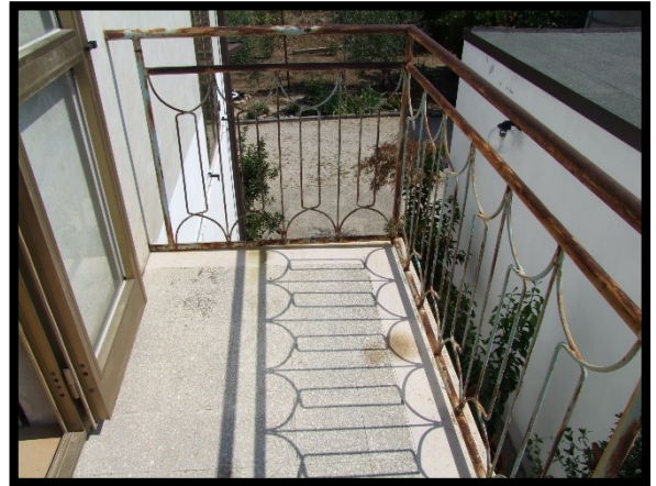
F. 16: BALCONE DELL'APPARTAMENTO UBICATO AL PIANO 1° IN VIA PIANA PELLEGRINA, N. 1 – ORSOGNA (CH), P.LLA 4220 SUB. 3 (A/3)
