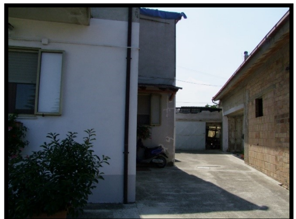
F. 30: ACCESSO ALLA RIMESSA UBICATA AL PIANO TERRA IN VIA PIANA PELLEGRINA, N. 1 – ORSOGNA (CH), P.LLA 4220 SUB. 1 (B.C.N.C.)
