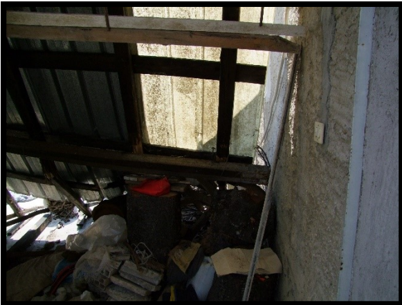
F. 33: INTERNO DELLA RIMESSA UBICATA AL PIANO TERRA IN VIA PIANA PELLEGRINA, N. 1 – ORSOGNA (CH), P.LLA 4220 SUB. 6 (C/6), VALUTATA SOLO L'AREA DI SEDIME PERCHÉ INAGIBILE
