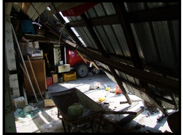
F. 32: INTERNO DELLA RIMESSA UBICATA AL PIANO TERRA IN VIA PIANA PELLEGRINA, N. 1 – ORSOGNA (CH), P.LLA 4220 SUB. 6 (C/6), VALUTATA SOLO L'AREA DI SEDIME PERCHÉ INAGIBILE
