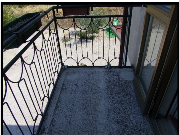
F. 11: BALCONE DELL'APPARTAMENTO UBICATO AL PIANO 1° IN VIA PIANA PELLEGRINA, N. 1 – ORSOGNA (CH), P.LLA 4220 SUB. 3 (A/3)
