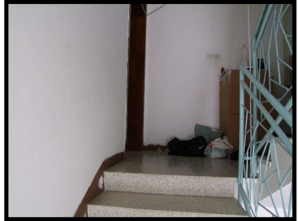
F. 08: ACCESSO ALL'APPARTAMENTO UBICATO AL PIANO 1° IN VIA PIANA PELLEGRINA, N. 1 – ORSOGNA (CH), P.LLA 4220 SUB. 1 (B.C.N.C.)
