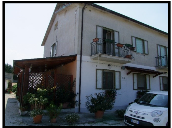
F. 04: FABBRICATO PLURIFAMILIARE UBICATO IN VIA PIANA PELLEGRINA, N. 1 – ORSOGNA (CH), P.LLA 4220
