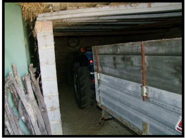
F. 38: INTERNO DEL DEPOSITO UBICATO AL PIANO TERRA IN VIA PIANA PELLEGRINA, N. 1 – ORSOGNA (CH), P.LLA 4220 SUB. 4 (C/2)
