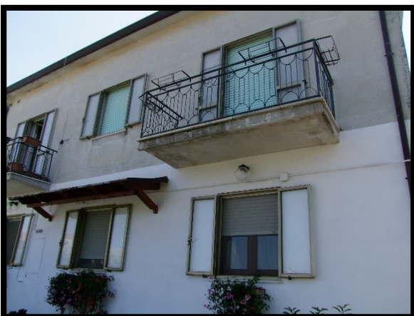
F. 05: FABBRICATO PLURIFAMILIARE UBICATO IN VIA PIANA PELLEGRINA, N. 1 – ORSOGNA (CH), P.LLA 4220
