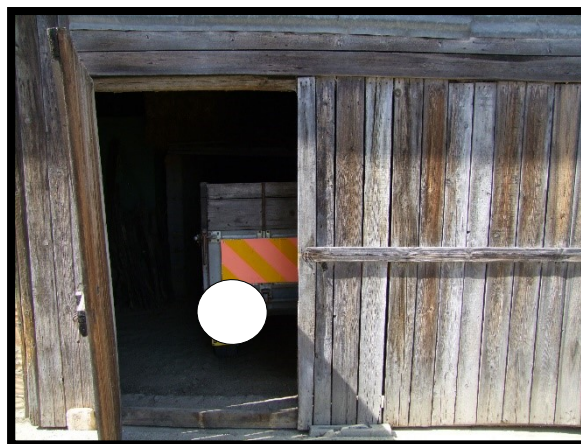
F. 35: INGRESSO DEL DEPOSITO UBICATO AL PIANO TERRA IN VIA PIANA PELLEGRINA, N. 1 – ORSOGNA (CH), P.LLA 4220 SUB. 4 (C/2)
