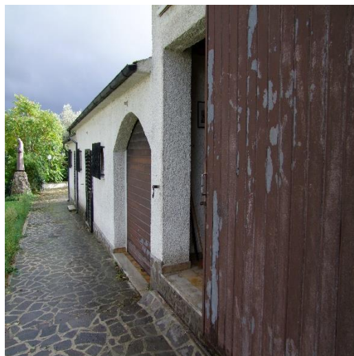
FOTO 62: MAGAZZINI AL PIANO TERRA (P.LLA 4121 SUB. 5 – C/2) NON VALUTATI CAUTELATIVAMENTE PERCHE' NON ASSENTITI URBANISTICAMENTE
