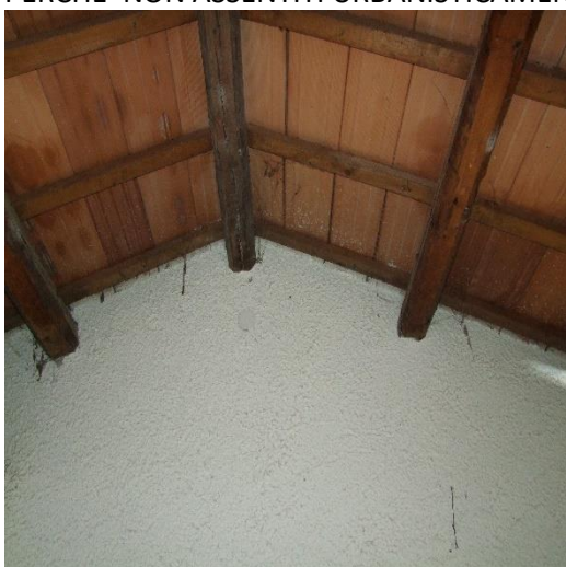
FOTO 81: MAGAZZINI AL PIANO TERRA (P.LLA 4121 SUB. 5 – C/2) NON VALUTATI CAUTELATIVAMENTE PERCHE' NON ASSENTITI URBANISTICAMENTE
