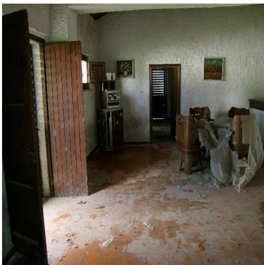
FOTO 71: MAGAZZINI AL PIANO TERRA (P.LLA 4121 SUB. 5 – C/2) NON VALUTATI CAUTELATIVAMENTE PERCHE' NON ASSENTITI URBANISTICAMENTE
