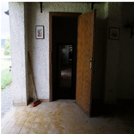
FOTO 67: MAGAZZINI AL PIANO TERRA (P.LLA 4121 SUB. 5 – C/2) NON VALUTATI CAUTELATIVAMENTE PERCHE' NON ASSENTITI URBANISTICAMENTE
