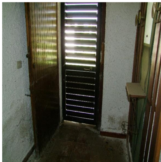
FOTO 78: MAGAZZINI AL PIANO TERRA (P.LLA 4121 SUB. 5 – C/2) NON VALUTATI CAUTELATIVAMENTE PERCHE' NON ASSENTITI URBANISTICAMENTE
