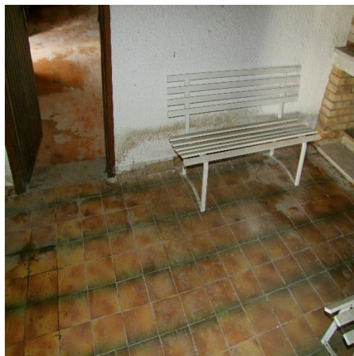
FOTO 68: MAGAZZINI AL PIANO TERRA (P.LLA 4121 SUB. 5 – C/2) NON VALUTATI CAUTELATIVAMENTE PERCHE' NON ASSENTITI URBANISTICAMENTE
