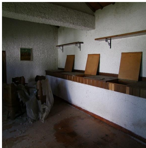
FOTO 72: MAGAZZINI AL PIANO TERRA (P.LLA 4121 SUB. 5 – C/2) NON VALUTATI CAUTELATIVAMENTE PERCHE' NON ASSENTITI URBANISTICAMENTE
