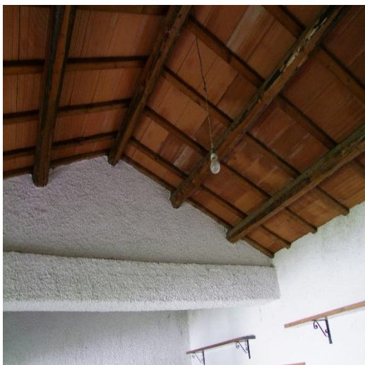
FOTO 73: MAGAZZINI AL PIANO TERRA (P.LLA 4121 SUB. 5 – C/2) NON VALUTATI CAUTELATIVAMENTE PERCHE' NON ASSENTITI URBANISTICAMENTE
