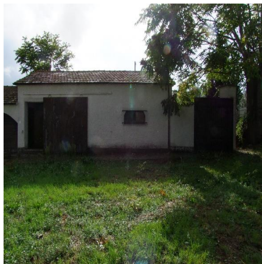
FOTO 60: MAGAZZINI AL PIANO TERRA (P.LLA 4121 SUB. 5 – C/2) NON VALUTATI CAUTELATIVAMENTE PERCHE' NON ASSENTITI URBANISTICAMENTE
