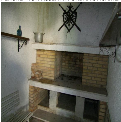
FOTO 69: MAGAZZINI AL PIANO TERRA (P.LLA 4121 SUB. 5 – C/2) NON VALUTATI CAUTELATIVAMENTE PERCHE' NON ASSENTITI URBANISTICAMENTE
