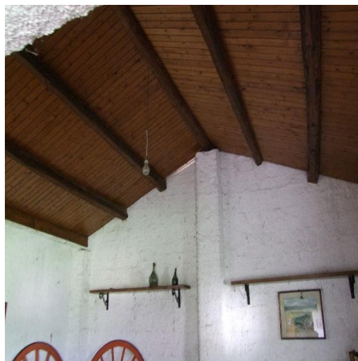
FOTO 66: MAGAZZINI AL PIANO TERRA (P.LLA 4121 SUB. 5 – C/2) NON VALUTATI CAUTELATIVAMENTE PERCHE' NON ASSENTITI URBANISTICAMENTE
