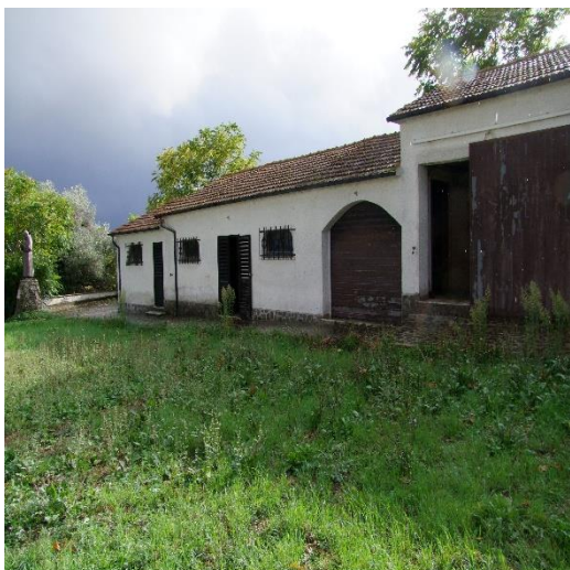
FOTO 61: MAGAZZINI AL PIANO TERRA (P.LLA 4121 SUB. 5 – C/2) NON VALUTATI CAUTELATIVAMENTE PERCHE' NON ASSENTITI URBANISTICAMENTE
