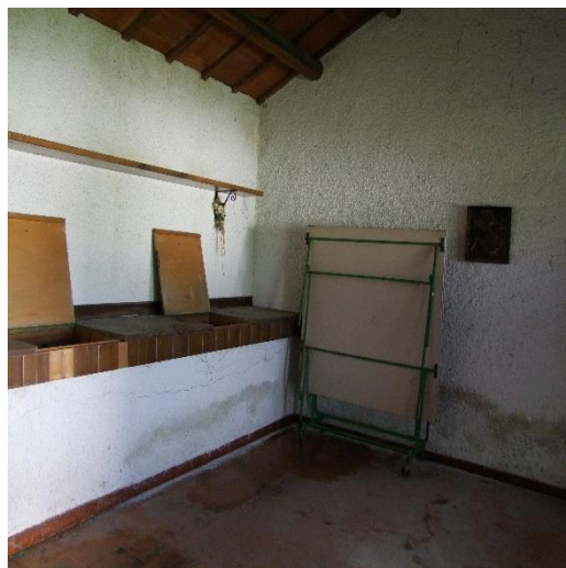
FOTO 74: MAGAZZINI AL PIANO TERRA (P.LLA 4121 SUB. 5 – C/2) NON VALUTATI CAUTELATIVAMENTE PERCHE' NON ASSENTITI URBANISTICAMENTE
