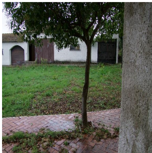
FOTO 32: MAGAZZINI AL PIANO TERRA (P.LLA 4121 SUB. 5 – C/2) NON VALUTATI CAUTELATIVAMENTE PERCHE' NON ASSENTITI URBANISTICAMENTE
