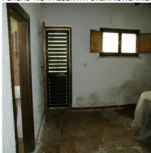
FOTO 76: MAGAZZINI AL PIANO TERRA (P.LLA 4121 SUB. 5 – C/2) NON VALUTATI CAUTELATIVAMENTE PERCHE' NON ASSENTITI URBANISTICAMENTE
