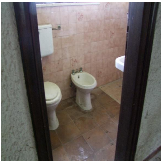
FOTO 79: MAGAZZINI AL PIANO TERRA (P.LLA 4121 SUB. 5 – C/2) NON VALUTATI CAUTELATIVAMENTE PERCHE' NON ASSENTITI URBANISTICAMENTE
