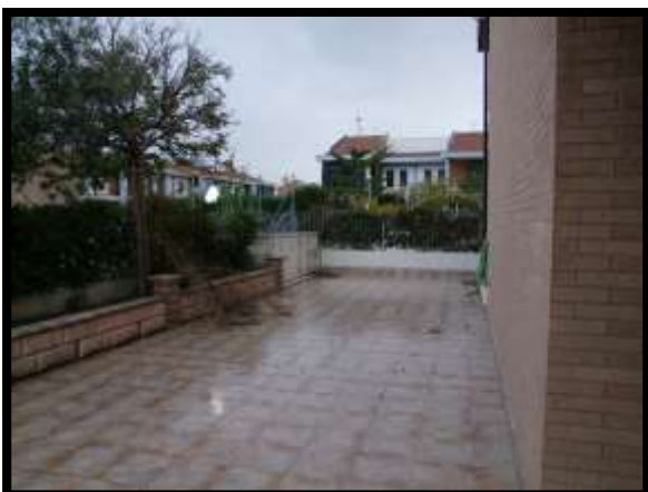
F. 11: CORTE ESCLUSIVA UBICATA AL PIANO TERRA IN VIA POTENZA, N. 53, LOTTO "C", LOCALITÀ MARINELLE, CAMPOMARINO (CB), P.LLA 2823 SUB. 31 GRAFFATA ALLA SUB. 32
