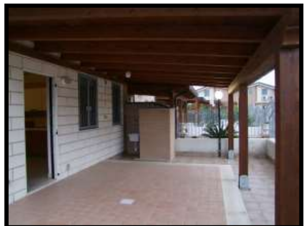
F. 12: PORTICO D'INGRESSO UBICATO AL PIANO TERRA IN VIA POTENZA, N. 53, LOTTO "C", LOCALITÀ MARINELLE, CAMPOMARINO (CB), P.LLA 2823 SUB. 31 GRAFFATA ALLA SUB. 32
