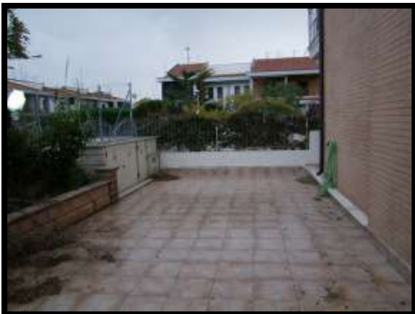
F. 09: CORTE ESCLUSIVA UBICATA AL PIANO TERRA IN VIA POTENZA, N. 53, LOTTO "C", LOCALITÀ MARINELLE, CAMPOMARINO (CB), P.LLA 2823 SUB. 31 GRAFFATA ALLA SUB. 32
