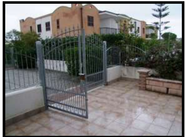
F. 10: CORTE ESCLUSIVA UBICATA AL PIANO TERRA IN VIA POTENZA, N. 53, LOTTO "C", LOCALITÀ MARINELLE, CAMPOMARINO (CB), P.LLA 2823 SUB. 31 GRAFFATA ALLA SUB. 32
