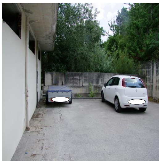
FOTO 48: AREA DI MANOVRA COMUNE UBICATA AL PIANO TERRA, IN CONTRADA GAUDO, N. 37, BARANELLO (CB), P.LLA 524 SUB. 1 (B.C.N.C.)
