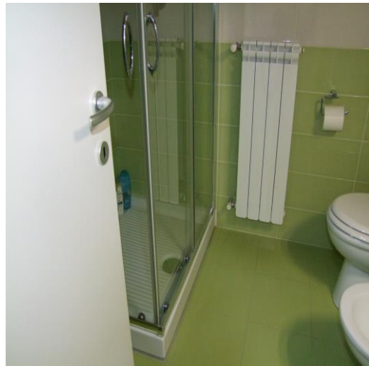
FOTO 24: INTERNO DEL BAGNO UBICATO AL PIANO 2°, IN CONTRADA GAUDO, N. 37, BARANELLO (CB), P.LLA 524 SUB. 30 (A/3)
