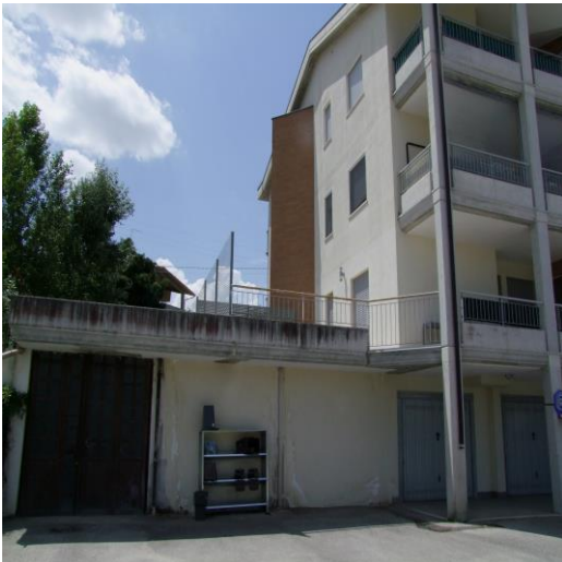
FOTO 09: FABBRICATO PLURIFAMILIARE UBICATO ALLA CONTRADA GAUDO, N. 37, BARANELLO (CB), P.LLA 524
