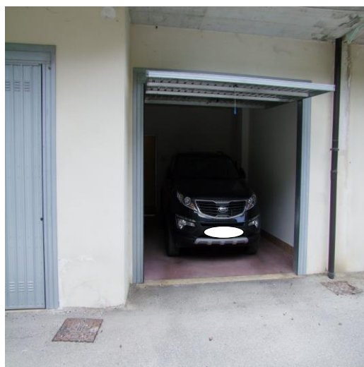
FOTO 44: INGRESSO DEL LOCALE GARAGE UBICATO AL PIANO TERRA, IN CONTRADA GAUDO, N. 37, BARANELLO (CB), P.LLA 524 SUB. 21 (C/6)
