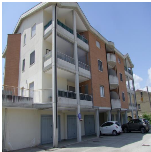
FOTO 08: FABBRICATO PLURIFAMILIARE UBICATO ALLA CONTRADA GAUDO, N. 37, BARANELLO (CB), P.LLA 524
