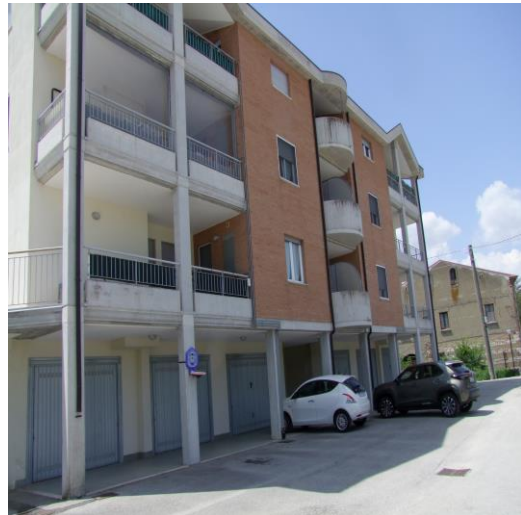
FOTO 10: FABBRICATO PLURIFAMILIARE UBICATO ALLA CONTRADA GAUDO, N. 37, BARANELLO (CB), P.LLA 524
