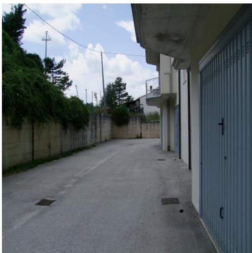
FOTO 49: AREA DI MANOVRA COMUNE UBICATA AL PIANO TERRA, IN CONTRADA GAUDO, N. 37, BARANELLO (CB), P.LLA 524 SUB. 1 (B.C.N.C.)
