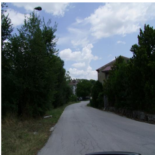
FOTO 03: ACCESSO AL FABBRICATO PLURIFAMILIARE DALLA CONTRADA GAUDO, BARANELLO (CB)
