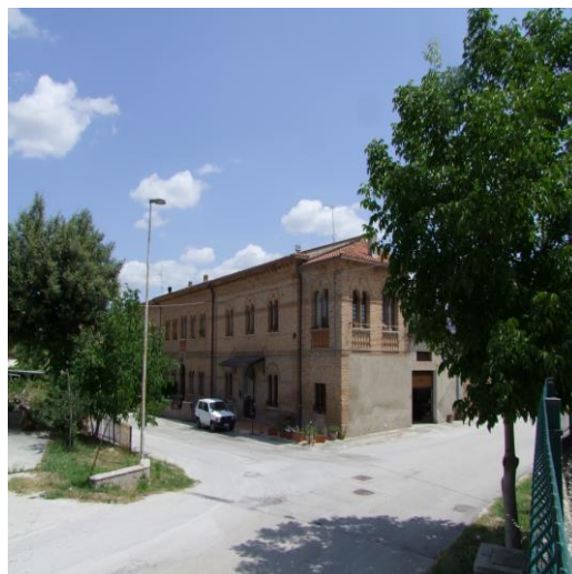
FOTO 06: ACCESSO AL FABBRICATO PLURIFAMILIARE DALLA CONTRADA GAUDO, BARANELLO (CB)
