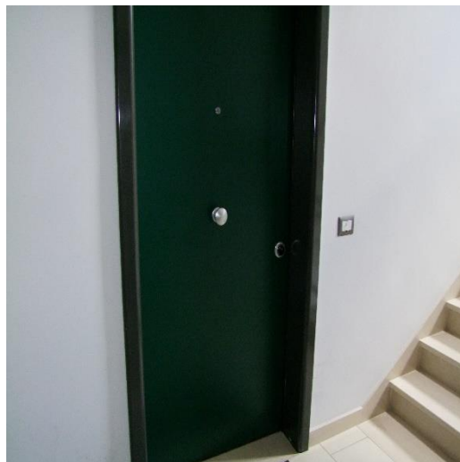
FOTO 16: INGRESSO DELL'APPARTAMENTO UBICATO AL PIANO 2°, IN CONTRADA GAUDO, N. 37, BARANELLO (CB), P.LLA 524 SUB. 30 (A/3)
