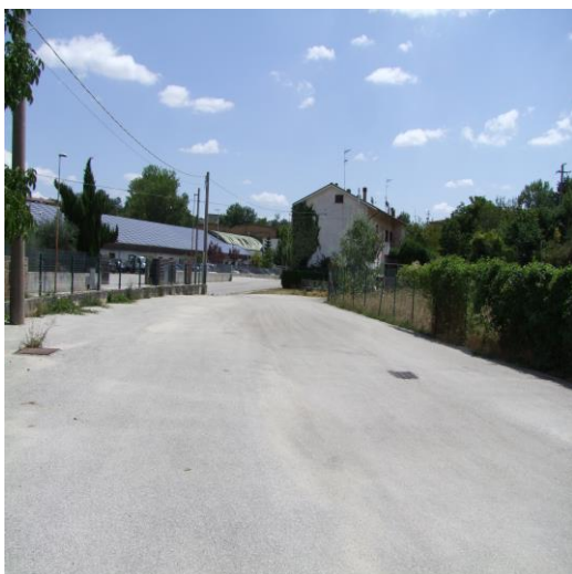
FOTO 07: ACCESSO AL FABBRICATO PLURIFAMILIARE DALLA CONTRADA GAUDO, BARANELLO (CB)
