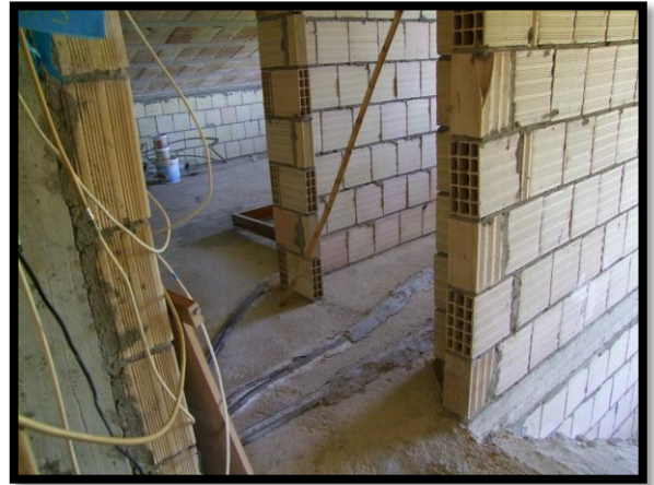
F. 34: INTERNO DELLA SOFFITTA UBICATA AL PIANO 1° SOTTOTETTO IN CONTRADA CAMPOGRANDE, N. 45 TORINO DI SANGRO (CH), P.LLA 4070 SUB. 2 (A/2)
