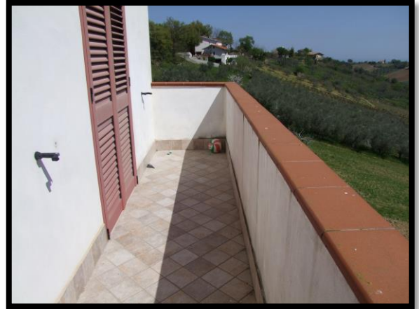
F. 20: BALCONE DELL'ABITAZIONE UBICATA AL PIANO TERRA IN CONTRADA CAMPOGRANDE, N. 45 – TORINO DI SANGRO (CH), P.LLA 4070 SUB. 2 (A/2)
