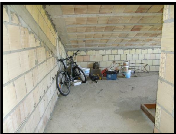
F. 35: INTERNO DELLA SOFFITTA UBICATA AL PIANO 1° SOTTOTETTO IN CONTRADA CAMPOGRANDE, N. 45, N. 45 – TORINO DI SANGRO (CH), P.LLA 4070 SUB. 2 (A/2)
