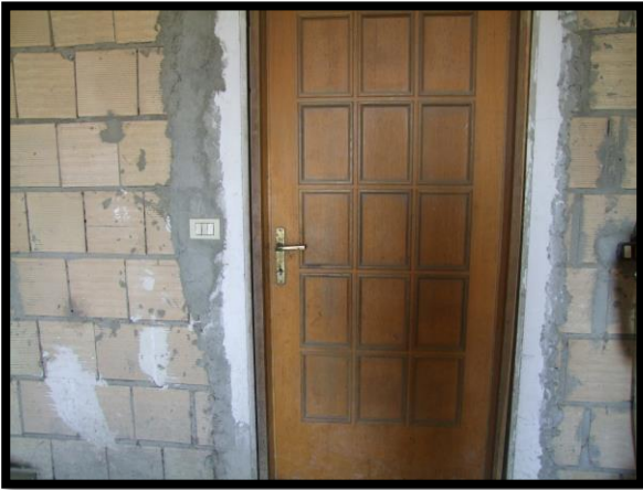
F. 39: ACCESSO ALLA LEGNAIA UBICATA AL PIANO 1° SOTTOSTRADA IN CONTRADA CAMPOGRANDE, N. 45, TORINO DI SANGRO (CH), P.LLA 4070 SUB. 2 (A/2)
