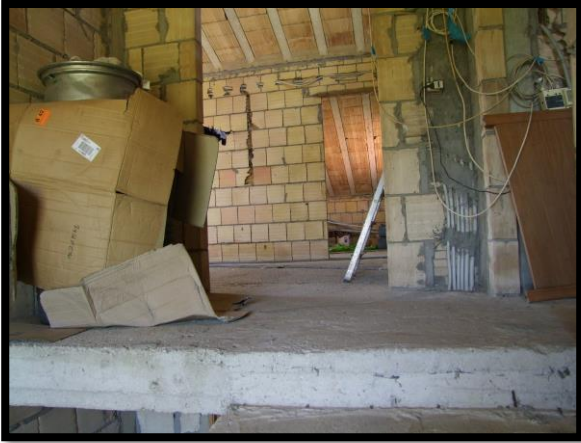
F. 25: ACCESSO ALLA SOFFITTA UBICATA AL PIANO 1° SOTTOTETTO IN CONTRADA CAMPOGRANDE, N. 45, N. 45 – TORINO DI SANGRO (CH), P.LLA 4070 SUB. 2 (A/2)
