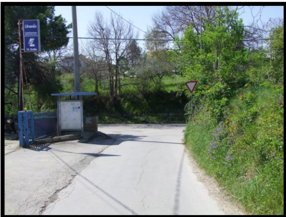
F. 03: ACCESSO AL FABBRICATO UNIFAMILIARE DALLA CONTRADA CAMPOGRANDE – TORINO DI SANGRO (CH), SAN VITO CHIETINO (CH), P.LLA 4476
