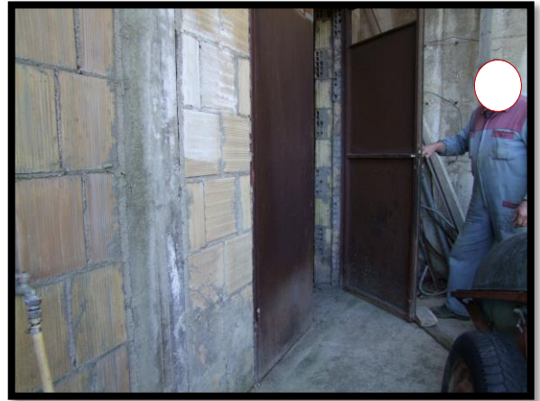
F. 40: INGRESSO DELLA LEGNAIA UBICATA AL PIANO 1° SOTTOSTRADA IN CONTRADA CAMPOGRANDE, N. 45, TORINO DI SANGRO (CH), P.LLA 4070 SUB. 2 (A/2)
