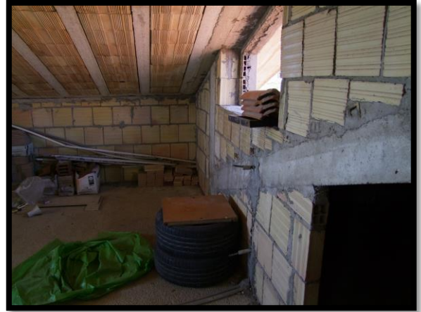
F. 32: INTERNO DELLA SOFFITTA UBICATA AL PIANO 1° SOTTOTETTO IN CONTRADA CAMPOGRANDE, N. 45 TORINO DI SANGRO (CH), P.LLA 4070 SUB. 2 (A/2)
