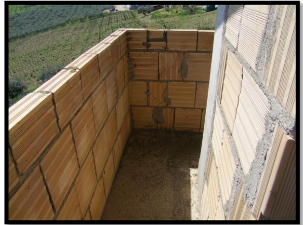
F. 28: BALCONE DELLA SOFFITTA UBICATA AL PIANO 1° SOTTOTETTO IN CONTRADA CAMPOGRANDE, N. 45 TORINO DI SANGRO (CH), P.LLA 4070 SUB. 2 (A/2)
