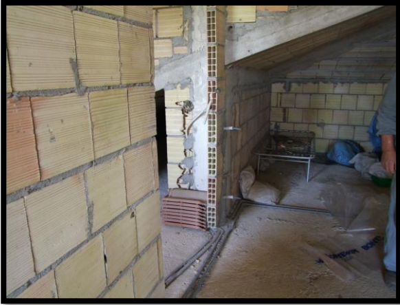
F. 31: INTERNO DELLA SOFFITTA UBICATA AL PIANO 1° SOTTOTETTO IN CONTRADA CAMPOGRANDE, N. 45, N. 45 – TORINO DI SANGRO (CH), P.LLA 4070 SUB. 2 (A/2)
