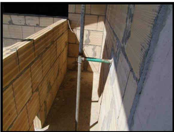
F. 29: BALCONE DELLA SOFFITTA UBICATA AL PIANO 1° SOTTOTETTO IN CONTRADA CAMPOGRANDE, N. 45, N. 45 – TORINO DI SANGRO (CH), P.LLA 4070 SUB. 2 (A/2)
