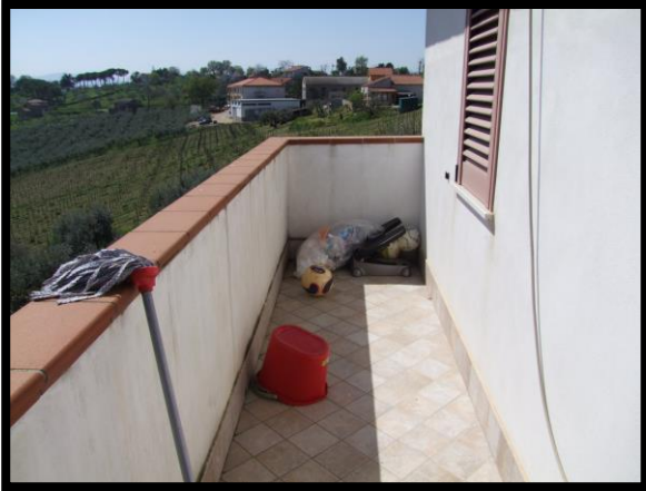
F. 19: BALCONE DELL'ABITAZIONE UBICATA AL PIANO TERRA IN CONTRADA CAMPOGRANDE, N. 45 – TORINO DI SANGRO (CH), P.LLA 4070 SUB. 2 (A/2)
