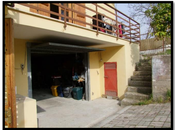
F. 34: INGRESSO DEL GARAGE UBICATO AL PIANO SEMINTERRATO IN CONTRADA COLLE PIZZUTO, N. 64/B, LANCIANO (CH), P.LLA 959 SUB. 3 (C/6)
