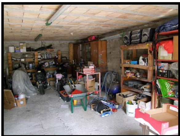
F. 37: INTERNO DEL GARAGE UBICATO AL PIANO SEMINTERRATO IN CONTRADA COLLE PIZZUTO, N. 64/B, LANCIANO (CH), P.LLA 959 SUB. 3 (C/6)
