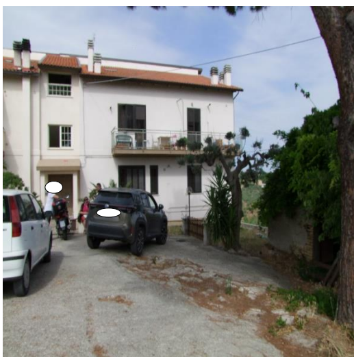
FOTO 03: FABBRICATO PLURIFAMILIARE UBICATO IN VIA SAN BIAGIO, S.N.C. VASTO (CH), P.LLA 504
