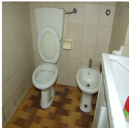
FOTO 20: INTERNO DEL W.C. UBICATO AL PIANO PIANO SEMINTERRATO IN VIA SAN BIAGIO, S.N.C., VASTO (CH), P.LLA 504 SUB 1 (A/3)
