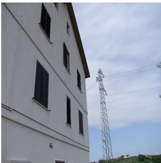
FOTO 13: FABBRICATO PLURIFAMILIARE UBICATO IN VIA SAN BIAGIO, S.N.C. VASTO (CH), P.LLA 504
