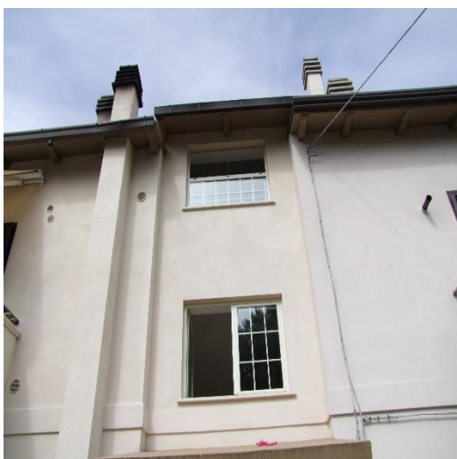
FOTO 07: FABBRICATO PLURIFAMILIARE UBICATO IN VIA SAN BIAGIO, S.N.C. VASTO (CH), P.LLA 504
