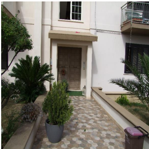
FOTO 05: FABBRICATO PLURIFAMILIARE UBICATO IN VIA SAN BIAGIO, S.N.C. VASTO (CH), P.LLA 504
