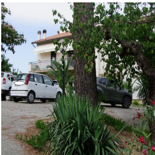
FOTO 39: FABBRICATO PLURIFAMILIARE UBICATO IN VIA SAN BIAGIO, S.N.C. VASTO (CH), P.LLA 504
