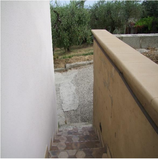
FOTO 09: FABBRICATO PLURIFAMILIARE UBICATO IN VIA SAN BIAGIO, S.N.C. VASTO (CH), P.LLA 504
