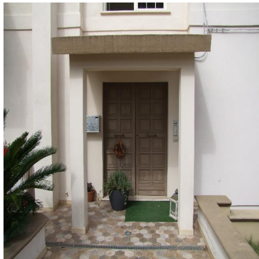
FOTO 06: FABBRICATO PLURIFAMILIARE UBICATO IN VIA SAN BIAGIO, S.N.C. VASTO (CH), P.LLA 504
