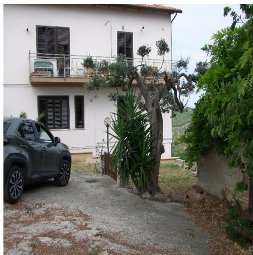
FOTO 40: FABBRICATO PLURIFAMILIARE UBICATO IN VIA SAN BIAGIO, S.N.C. VASTO (CH), P.LLA 504
