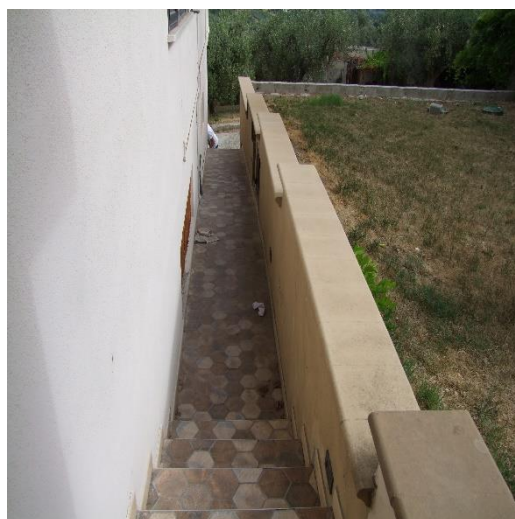
FOTO 08: FABBRICATO PLURIFAMILIARE UBICATO IN VIA SAN BIAGIO, S.N.C. VASTO (CH), P.LLA 504
