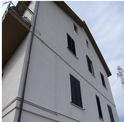
FOTO 12: FABBRICATO PLURIFAMILIARE UBICATO IN VIA SAN BIAGIO, S.N.C. VASTO (CH), P.LLA 504
