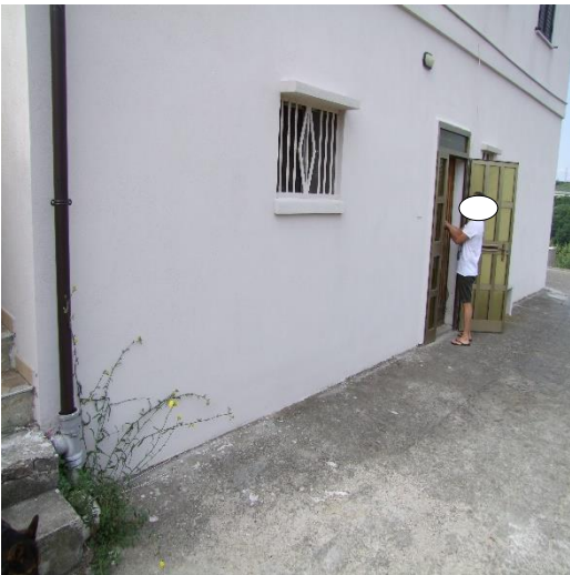
FOTO 11: INGRESSO DELL'APPARTAMENTO UBICATO AL PIANO SEMINTERRATO IN VIA SAN BIAGIO, S.N.C., VASTO (CH), P.LLA 504 SUB 1 (A/3)
