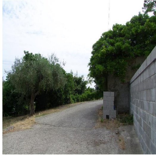
FOTO 10: FABBRICATO PLURIFAMILIARE UBICATO IN VIA SAN BIAGIO, S.N.C. VASTO (CH), P.LLA 504
