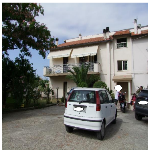
FOTO 04: FABBRICATO PLURIFAMILIARE UBICATO IN VIA SAN BIAGIO, S.N.C. VASTO (CH), P.LLA 504
