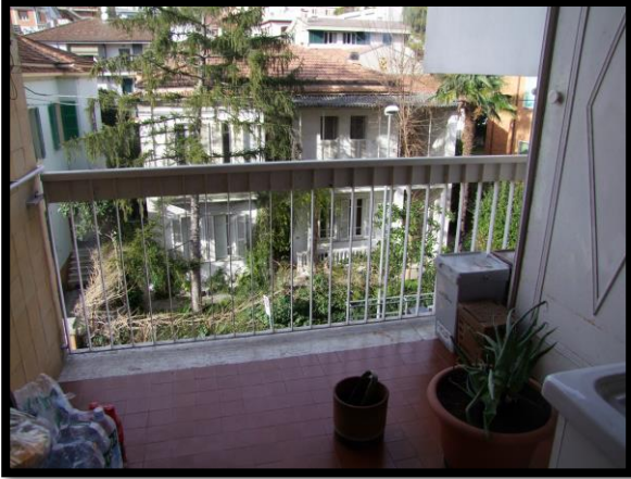
F. 19: BALCONE DELL'APPARTAMENTO POSTO AL PIANO 3°, INTERNO 24, P.LLA 214 SUB. 24
