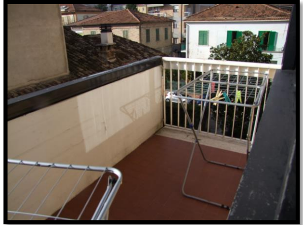
F. 14: BALCONE DELL'APPARTAMENTO POSTO AL PIANO 3°, INTERNO 24, P.LLA 214 SUB. 24
