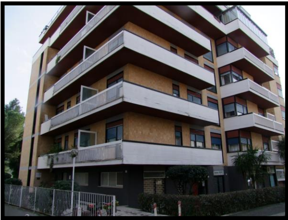
F. 03: FABBRICATO PLURIFAMILIARE UBICATO IN VIA VINCENZO PIGLIACELLI, N. 1 – TERAMO (TE), P.LLA 214
