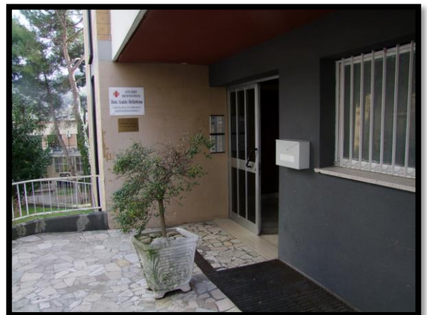
F. 06: INGRESSO COMUNE POSTO AL PIANO TERRA DI VIA GIORGIO VINCENZO PIGLIACELLI, N. 1 – TERAMO (TE), P.LLA 214
