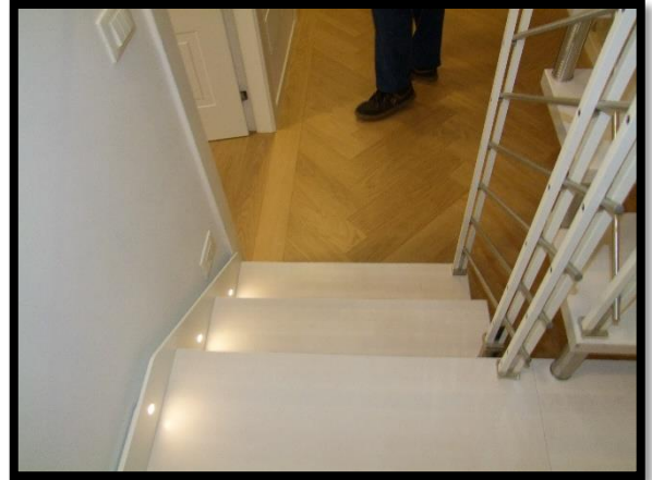
F. 20: ACCESSO ALL'ABITAZIONE UBICATA AL PIANO TERRA IN VIA NAZIONALE, N. 79 – FARA SAN MARTINO (CH), P.LLA 1162 SUB. 3
