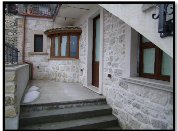
F. 06: INGRESSO ATTRAVERSO LA CORTE ESCLUSIVA UBICATO AL PIANO TERRA IN VIA NAZIONALE, N. 79, FARA SAN MARTINO (CH), P.LLA 1162 SUB. 3
