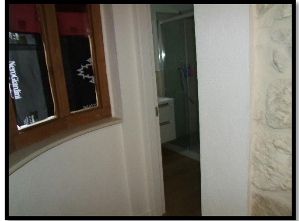
F. 26: INTERNO DELL'ABITAZIONE UBICATO AL PIANO TERRA VIA NAZIONALE, N. 79 – FARA SAN MARTINO (CH), P.LLA 1162 SUB. 3
