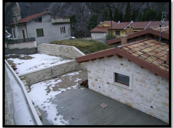
F. 38: VISTA DEL FABBRICATO UNIFAMILIARE UBICATO IN VIA NAZIONALE, N. 79 – FARA SAN MARTINO (CH), P.LLA 1162 SUB. 3
