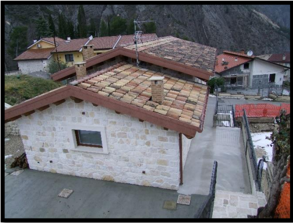
F. 39: VISTA DEL FABBRICATO UNIFAMILIARE UBICATO IN VIA NAZIONALE, N. 79 – FARA SAN MARTINO (CH), P.LLA 1162 SUB. 3
