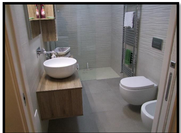
F. 24: INTERNO DELL'ABITAZIONE UBICATO AL PIANO TERRA VIA NAZIONALE, N. 79 – FARA SAN MARTINO (CH), P.LLA 1162 SUB. 3
