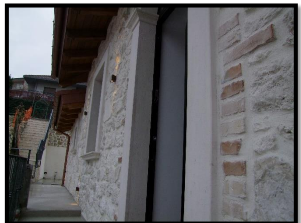
F. 12: INGRESSO DELL'ABITAZIONE UBIcato AL PIANO 1° IN VIA NAZIONALE, N. 79 – FARA SAN MARTINO (CH), P.LLA 1162 SUB. 3
