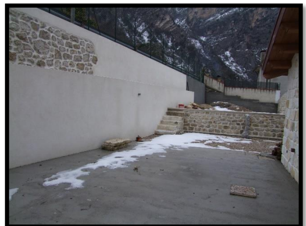
F. 30: AREA ESCLUSIVA PERTINENZIALE UBICATA AL PIANO 1° IN VIA NAZIONALE, N. 79 – FARA SAN MARTINO (CH), P.LLA 1162 SUB. 3
