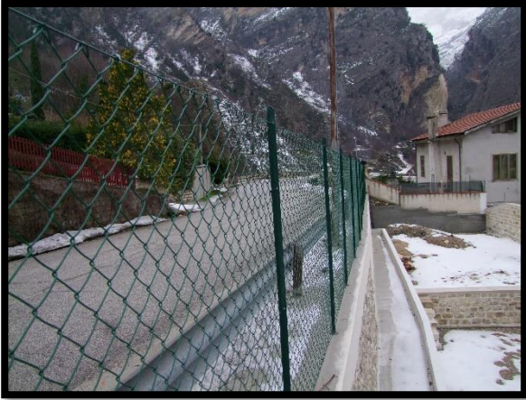
F. 37: ACCESSO LATO POSTERIORE DA VIA NAZIONALE UBICATO AL PIANO 1° IN VIA NAZIONALE, N. 79 – FARA SAN MARTINO (CH), P.LLA 1162 SUB. 3
