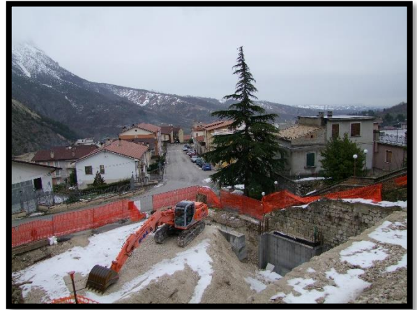
F. 40: VISTA DAL FABBRICATO UNIFAMILIARE UBICATO IN VIA NAZIONALE, N. 79 – FARA SAN MARTINO (CH), P.LLA 1162 SUB. 3
