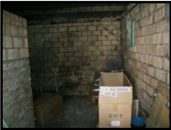
F. 21: INTERNO DELLA CANTINA UBICATA AL PIANO TERRA IN CONTRADA SINAGLIA, N. 90 – PAGLIETA (CH), P.LLA 407 SUB. 2 (A/3)
