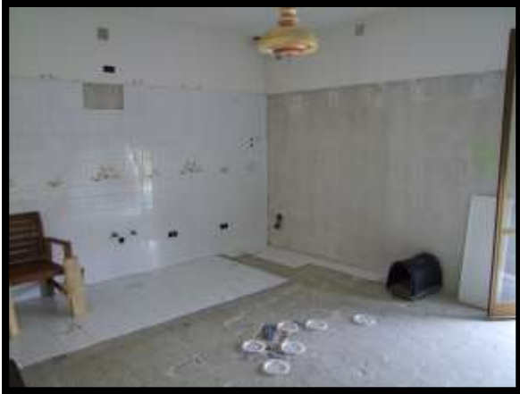
F. 31: INTERNO DELL'APPARTAMENTO UBICATO AL PIANO 1° IN CONTRADA SINAGLIA, N. 90 – PAGLIETA (CH), P.LLA 407 SUB. 3 (A/3)
