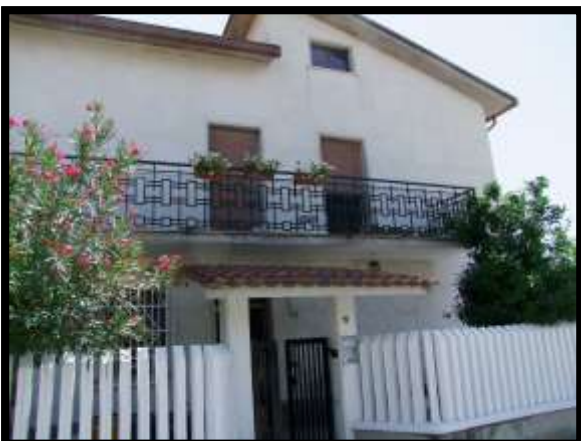
F. 05: FABBRICATO BIFAMILIARE UBICATO IN CONTRADA SINAGLIA, N. 90 – PAGLIETA (CH), P.LLE 407 SUB. 2 (A/3), SUB. 3 (A/3) E P.LLA 50 AL N.C.T.
