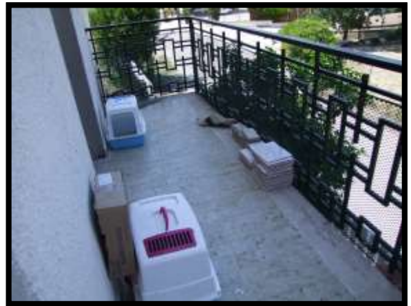
F. 28: BALCONE DELL'APPARTAMENTO UBICATO AL PIANO 1° IN CONTRADA SINAGLIA, N. 90 – PAGLIETA (CH), P.LLA 407 SUB. 3 (A/3)
