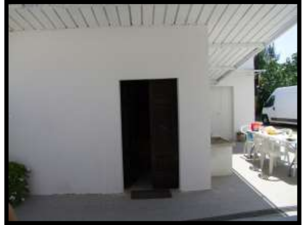
F. 20: INGRESSO DELLA CANTINA UBICATA AL PIANO TERRA IN CONTRADA SINAGLIA, N. 90 – PAGLIETA (CH), P.LLA 407 SUB. 2 (A/3)
