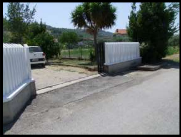
F. 07: FABBRICATO BIFAMILIARE UBICATO IN CONTRADA SINAGLIA, N. 90 – PAGLIETA (CH), P.LLE 407 SUB. 2 (A/3), SUB. 3 (A/3) E P.LLA 50 AL N.C.T.
