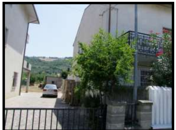
F. 06: FABBRICATO BIFAMILIARE UBICATO IN CONTRADA SINAGLIA, N. 90 – PAGLIETA (CH), P.LLE 407 SUB. 2 (A/3), SUB. 3 (A/3) E P.LLA 50 AL N.C.T.
