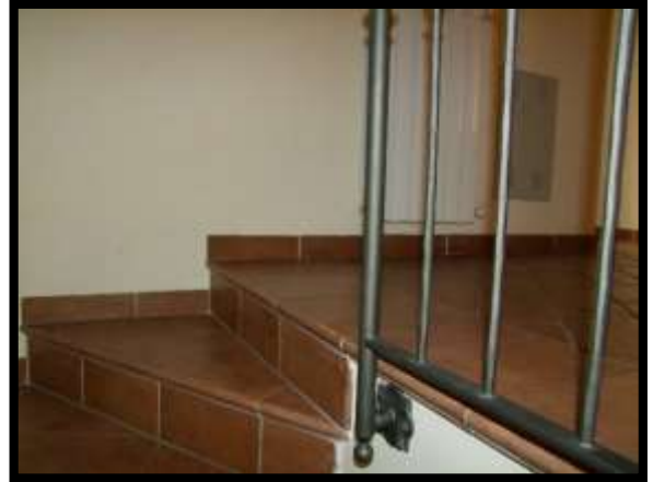
F. 20: ACCESSO ALLA CAMERA, SOTTOTETTO E VOLUMI TECNICI UBICATI AL PIANO 2° SOTTOTETTO IN VICO DELL'OSPEDALE, N. 20 – SULMONA (AQ), P.LLA 1163 SUB. 6 GRAFFATA ALLA P.LLA 1164 SUB. 3 (A/2)
