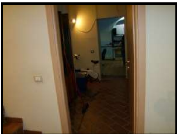
F. 29: ACCESSO ALLA CANTINA UBICATA AL PIANO TERRA IN VICO DELL'OSPEDALE, N. 20 – SULMONA (AQ), P.LLA 1164 SUB. 1 (C/2)
