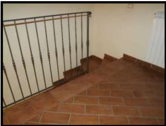
F. 27: ACCESSO ALL'INGRESSO E CANTINA UBICATI AL PIANO TERRA IN VICO DELL'OSPEDALE, N. 20 – SULMONA (AQ), P.LLA 1163 SUB. 5 GRAFFATA ALLA 1164 SUB. 2 (A/2)
