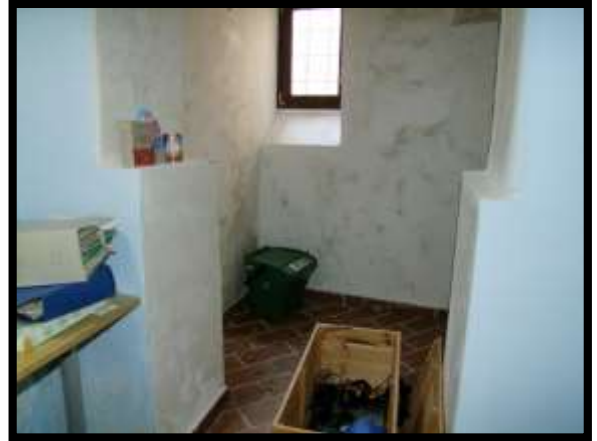
F. 32: INTERNO DELLA CANTINA UBICATO AL PIANO TERRA IN VICO DELL'OSPEDALE, N. 20 – SULMONA (AQ), P.LLA 1164 SUB. 1 (C/2)
