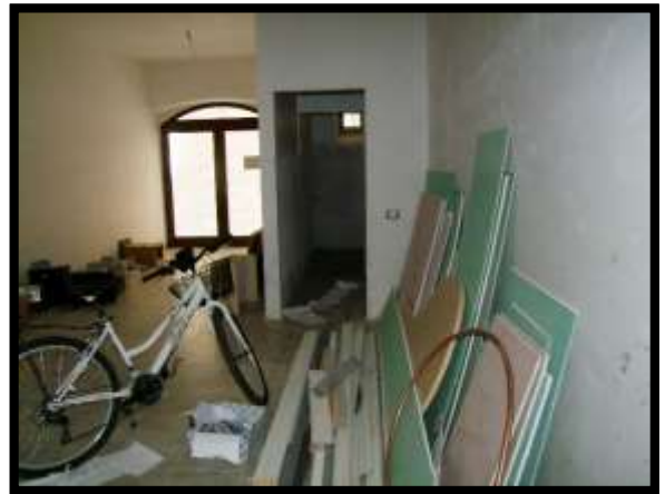
F. 34: INTERNO DEL LOCALE COMMERCIALE UBICATO AL PIANO TERRA IN VICO DELL'OSPEDALE, N. 20 – SULMONA (AQ), P.LLA 1163 SUB. 4 (C/1)
