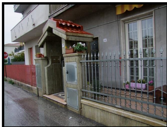
F. 06: INGRESSO PRINCIPALE POSTO AL PIANO TERRA DI VIA DELLE PALUDI, N. 28, PINETO (TE), P.LLA 211 SUB. 2
