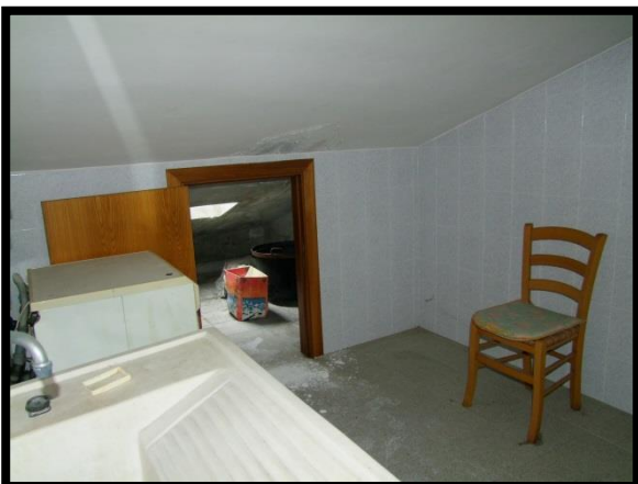
F. 29: INTERNO DELLA SOFFITTA POSTA AL PIANO 2° SOTTOTETTO, P.LLA 211 SUB. 12
