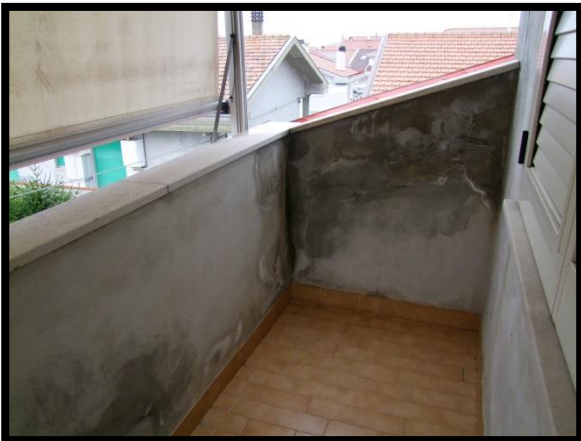
F. 27: TERRAZZINO DELLA SOFFITTA POSTA AL PIANO SOTTOTETTO, P.LLA 211 SUB. 12
