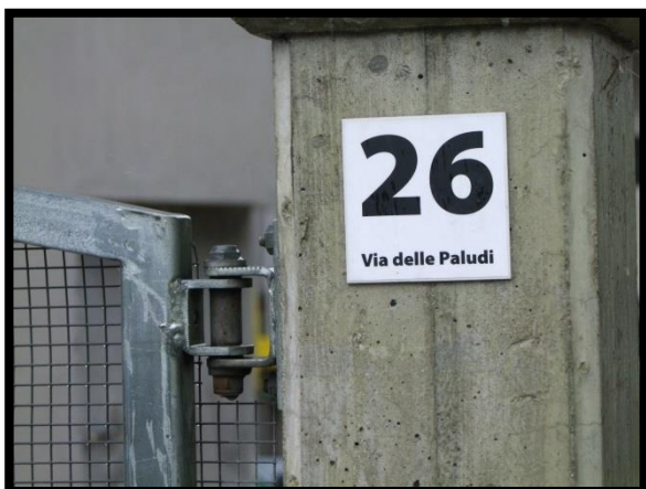
F. 05: INGRESSO AI RIPOSTIGLI POSTI AL PIANO TERRA DI VIA DELLE PALUDI, N. 26, PINETO (TE), P.LLA 211 SUB. 6
