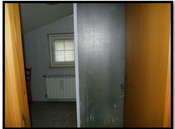
F. 28: INTERNO DELLA SOFFITTA POSTA AL PIANO 2° SOTTOTETTO, P.LLA 211 SUB. 12
