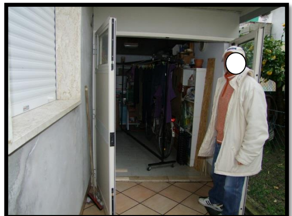
F. 30: ACCESSO AL RIPOSTIGLIO POSTO AL PIANO TERRA, P.LLA 211 SUB. 6
