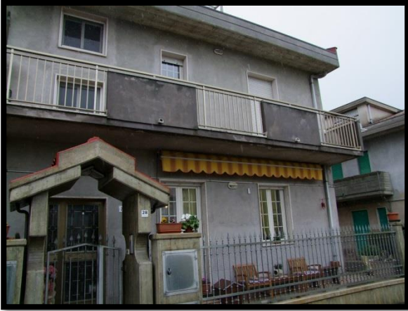
F. 07: FABBRICATO PLURIFAMILIARE SITO IN VIA DELLE DELLE PALUDI, N. 26/28, PINETO (TE), P.LLA 211
