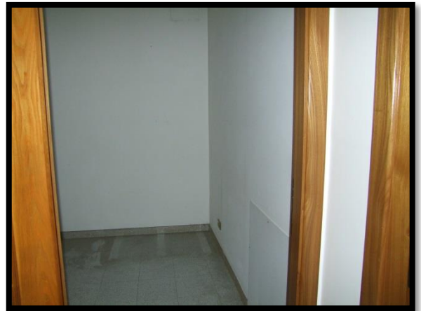
F. 16: INTERNO DELL'APPARTAMENTO POSTO AL PIANO 1°, P.LLA 211 SUB. 12
