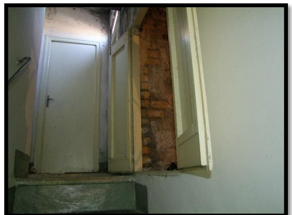
F. 30: INGRESSO DELLA SOFFITTA UBICATA AL PIANO 2° SOTTOTETTO IN VIA FISCHIE, N. 8 – PALENA (CH), P.LLA 430 SUB. 2
