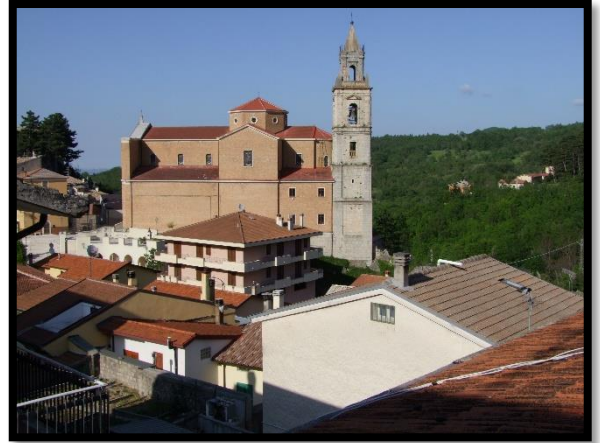
F. 26: VISTA DAL TERRAZZO UBICATO AL PIANO 2° SOTTOTETTO IN VIA FISCHIE, N. 8 – PALENA (CH), P.LLA 430 SUB. 2
