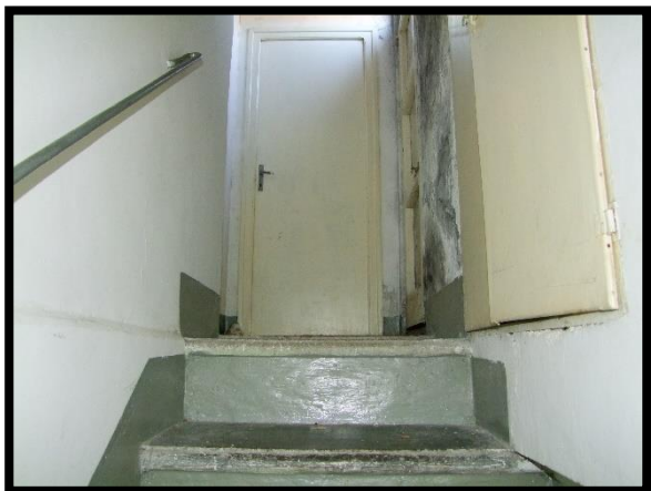
F. 21: ACCESSO AL RIPOSTIGLIO E SOFFITTA UBICATI AL PIANO 2° SOTTOTETTO IN VIA FISCHIE, N. 8, PALENA (CH), P.LLA 430 SUB. 2
