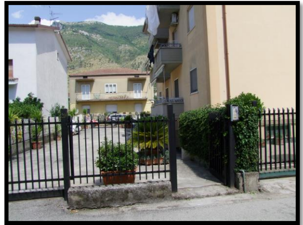
F. 04: INGRESSO COMUNE UBICATO AL PIANO TERRA IN VIA RAFFAELLO SANZIO, N. 22 – VENAFRO (IS), P.LLA 1389 SUB. 3 (B.C.N.C.)
