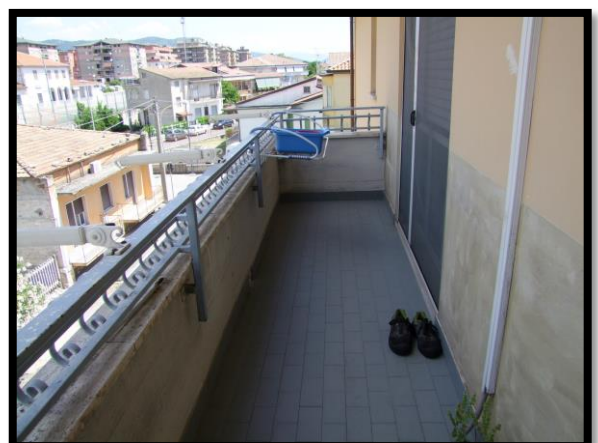
F. 12: BALCONE DELL'APPARTAMENTO UBICATO AL PIANO 3° IN VIA RAFFAELLO SANZIO, N. 22 – VENAFRO (IS), P.LLA 1389 SUB. 20 (A/2)
