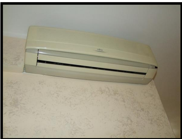
F. 23: INTERNO DELL'APPARTAMENTO UBICATO AL PIANO 3° IN VIA RAFFAELLO SANZIO, N. 22 – VENAFRO (IS), P.LLA 1389 SUB. 20 (A/2)
