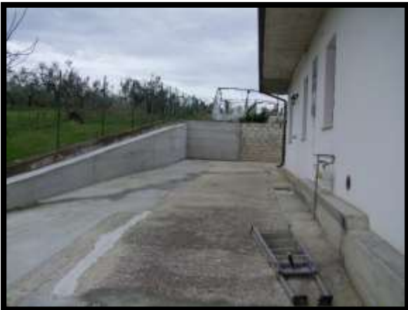
F. 09: INGRESSO DEL FABBRICATO UNIFAMILIARE DA VIA GIOVANNI FALCONE, N. 7, LOCALITÀ BADIA – FRISA (CH), P.LLA 4139 AL N.C.T. (NON OGGETTO DI VALUTAZIONE PERCHÉ INTESATA DIVERSAMENTE, SI HA SOLO LA SERVITÙ DI PASSAGGIO)
