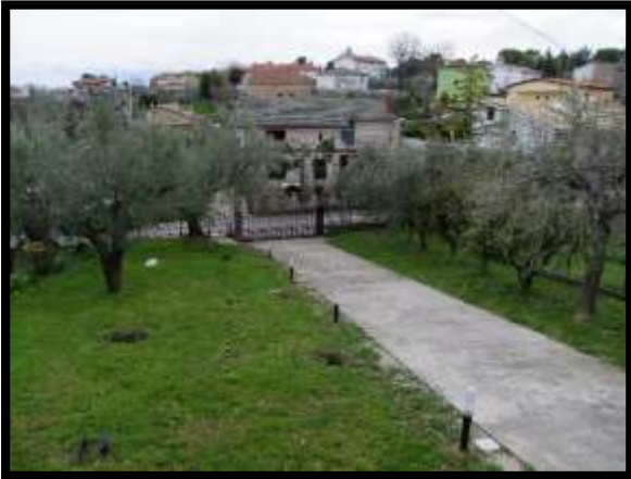
F. 07: INGRESSO DEL FABBRICATO UNIFAMILIARE DA VIA GIOVANNI FALCONE, N. 7, LOCALITÀ BADIA – FRISA (CH), P.LLA 4139 AL N.C.T. (NON OGGETTO DI VALUTAZIONE PERCHÉ INTESATA DIVERSAMENTE, SI HA SOLO LA SERVITÙ DI PASSAGGIO)
