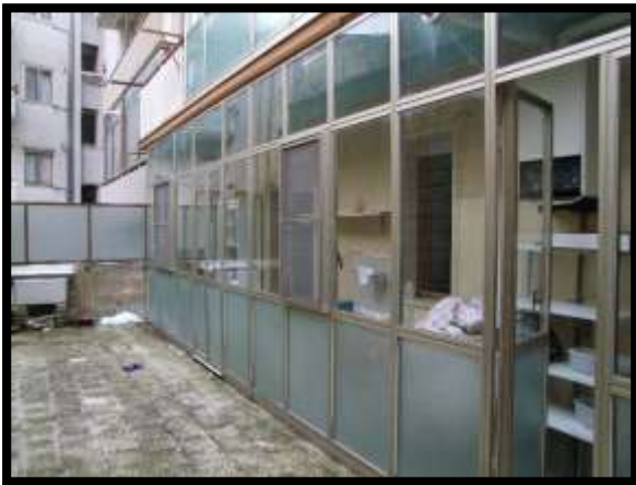
F. 27: VERANDA DELL'APPARTAMENTO UBICATA AL PIANO 1° IN VIA MATESE, N. 55 – FERRAZZANO (CB), P.LLA 317 SUB. 6 (A/4)
