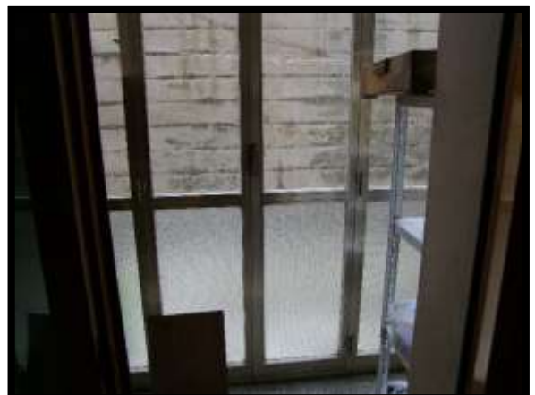
F. 24: VERANDA DELL'APPARTAMENTO UBICATA AL PIANO 1° IN VIA MATESE, N. 55 – FERRAZZANO (CB), P.LLA 317 SUB. 6 (A/4)
