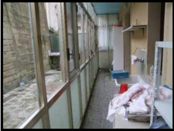
F. 25: VERANDA DELL'APPARTAMENTO UBICATA AL PIANO 1° IN VIA MATESE, N. 55 – FERRAZZANO (CB), P.LLA 317 SUB. 6 (A/4)
