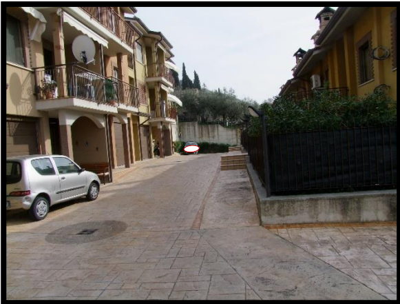
F. 09: ACCESSO AL POSTO AUTO ESTERNO UBICATO AL PIANO TERRA IN CONTRADA PASSO TUCCI, N. 26, LOCALITÀ MARINA DI SAN VITO, SAN VITO CHIETINO (CH), P.LLA 4476 SUB. 40 (B.C.N.C.)
