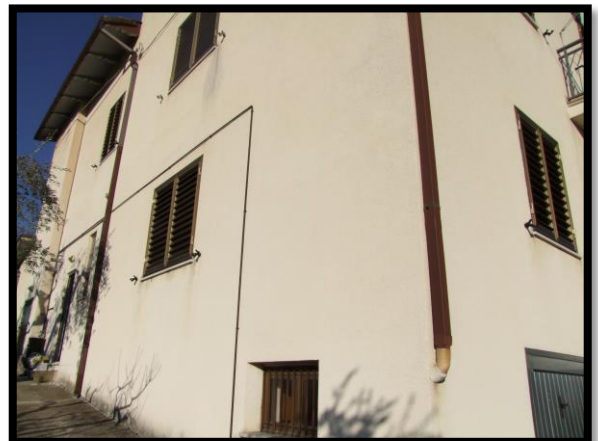
F. 29: FABBRICATO PLURIFAMILIARE UBICATO ALLA FRAZIONE TRIGNANO, N. 39, ISOLA DEL GRAN SASSO D'ITALIA (TE), P.LLA 303 (VISTA POSTERIORE)
