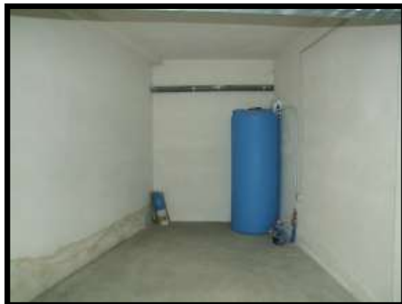
F. 26: INTERNO DEL GARAGE UBICATO AL PIANO INTERRATO IN VIA FRANCESCO PAOLO TOSTI, N. 16, VASTO (CH), P.LLA 4691 SUB. 33 (C/6)
