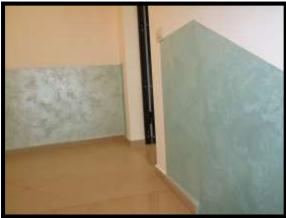
F. 09: ACCESSO ALL'APPARTAMENTO UBICATO AL PIANO 1° IN VIA FRANCESCO PAOLO TOSTI, N. 16 – VASTO (CH), P.LLA 4691 SUB. 2 (B.C.N.C.)
