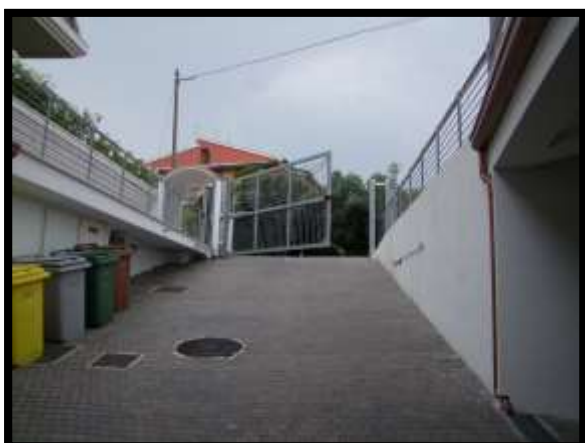
F. 23: RAMPA DI ACCESSO AL GARAGE UBICATO AL PIANO INTERRATO IN VIA FRANCESCO PAOLO TOSTI, N. 16, VASTO (CH), P.LLA 4691 SUB. 1 (B.C.N.C.)
