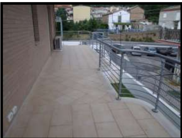
F. 17: BALCONE DELL'APPARTAMENTO UBICATO AL PIANO 1° IN VIA FRANCESCO PAOLO TOSTI, N. 16 – VASTO (CH), P.LLA 4691 SUB. 13 (A/2)
