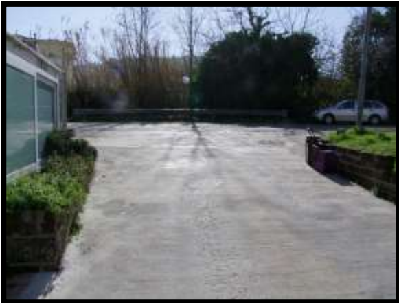
F. 03: FABBRICATO PLURIFAMILIARE UBICATO IN VIA BELVEDERE, N. 10/A – SAN GIOVANNI TEATINO (CH), P.LLA 5032 SUB. 22 (B.C.N.C.)
