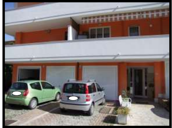
F. 08: FABBRICATO PLURIFAMILIARE UBICATO IN VIA BELVEDERE, N. 10/A – SAN GIOVANNI TEATINO (CH), P.LLA 5032 SUB. 22 (B.C.N.C.)
