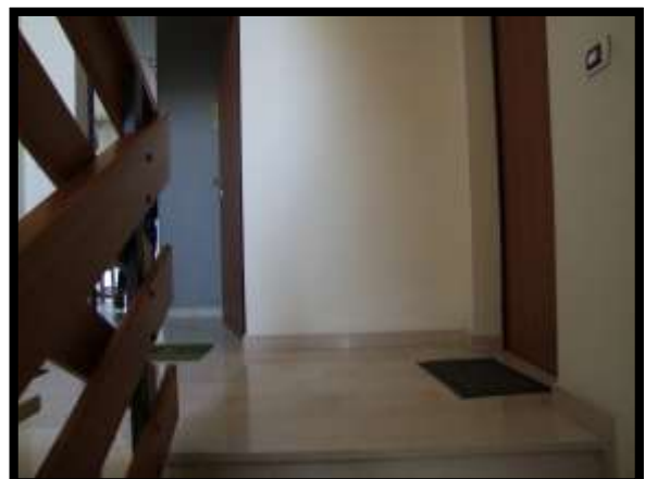
F. 12: ACCESSO ALL'APPARTAMENTO UBICATO AL PIANO TERRA IN VIA BELVEDERE, N. 10/A – SAN GIOVANNI TEATINO (CH), P.LLA 5032 SUB. 1 (B.C.N.C.)
