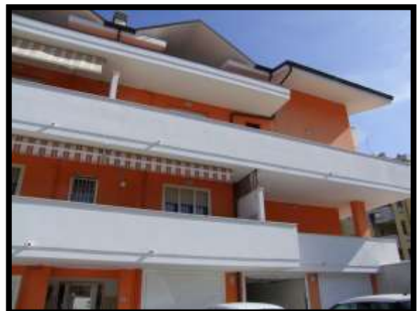
F. 06: FABBRICATO PLURIFAMILIARE UBICATO IN VIA BELVEDERE, N. 10/A – SAN GIOVANNI TEATINO (CH), P.LLA 5032
