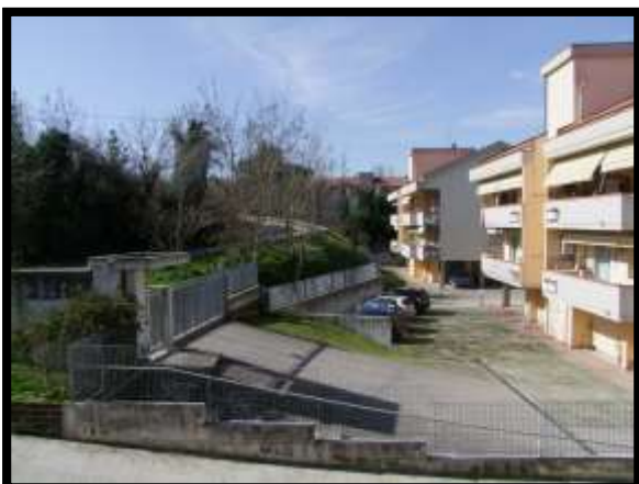
F. 17: VISTA DALL'APPARTAMENTO UBICATA AL PIANO TERRA IN VIA BELVEDERE, N. 10/A – SAN GIOVANNI TEATINO (CH), P.LLA 5032 SUB. 3 (A/2)
