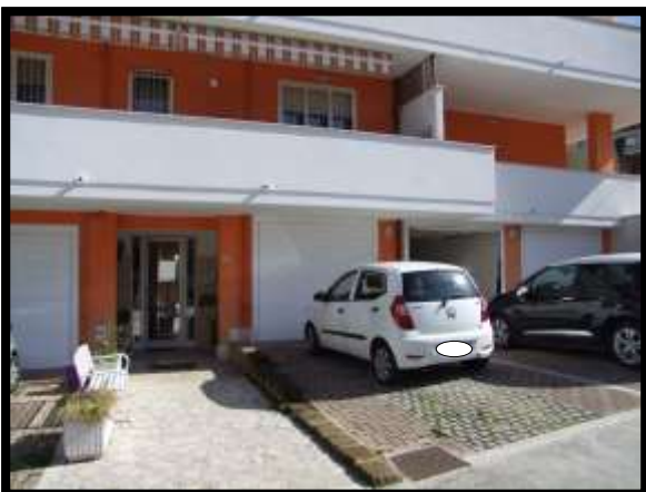
F. 05: FABBRICATO PLURIFAMILIARE UBICATO IN VIA BELVEDERE, N. 10/A – SAN GIOVANNI TEATINO (CH), P.LLA 5032 SUB. 22 (B.C.N.C.)
