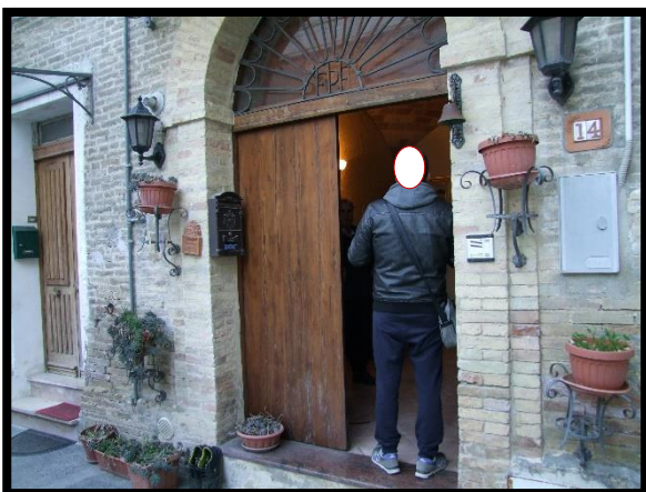
F. 11: INGRESSO DELL'APPARTAMENTO UBICATO AL PIANO TERRA IN VICO PATRIZI, N. 14 – CUPELLO (CH), P.LLA 183 SUB. 10 GRAFFATA ALLA P.LLA 184 SUB. 14 (A/4)
