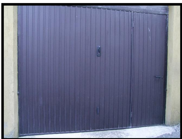
F. 05: INGRESSO DEL GARAGE UBICATO AL PIANO TERRA IN VICO PATRIZI, S.N.C. – CUPELLO (CH), P.LLA 181 SUB. 1 (C/6)
