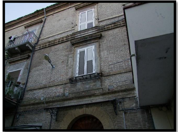
F. 10: FABBRICATO PLURIFAMILIARE UBICATO IN VICO PATRIZI, N. 14 – CUPELLO (CH), P.LLA 183 E P.LLA 184
