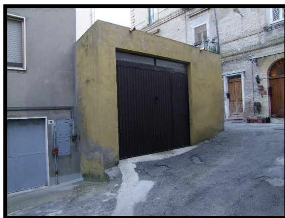
F. 04: ACCESSO AL GARAGE UBICATO AL PIANO TERRA IN VICO PATRIZI, S.N.C. – CUPELLO (CH), P.LLA 181 SUB. 1 (C/6)
