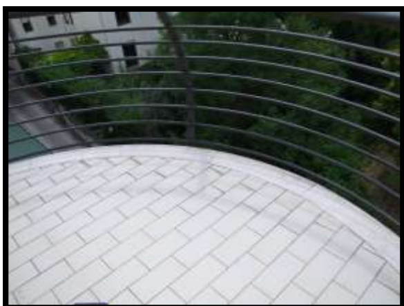
F. 23: BALCONE DELLA MANSARDA UBICATO AL PIANO 5° DA VIA GALILEO GALILEI, N. 9, SCALA "A" E PIANO 3° DA VIA MARCONI – VINCHIATURO (CB), P.LLA 857 SUB. 86 (A/3)
