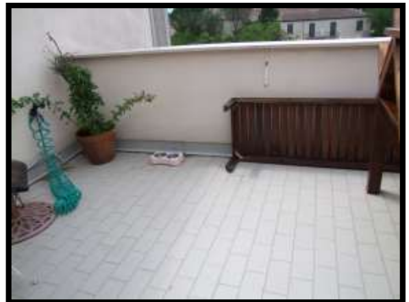
F. 16: TERRAZZO DELLA MANSARDA UBICATO AL PIANO 5° DA VIA GALILEO GALILEI, N. 9, SCALA "A" E PIANO 3° DA VIA MARCONI – VINCHIATURO (CB), P.LLA 857 SUB. 86 (A/3)
