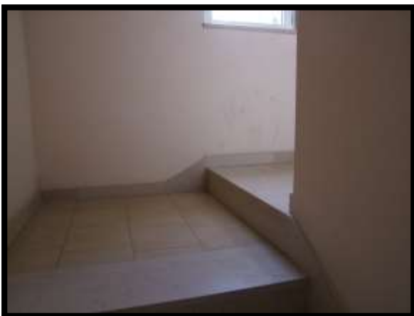
F. 11: ACCESSO ALLA MANSARDA UBICATA AL PIANO 5° DA VIA GALILEO GALILEI, N. 9, SCALA "A" E PIANO 3° DA VIA MARCONI – VINCHIATURO (CB), P.LLA 857 SUB. 99 (B.C.N.C.)
