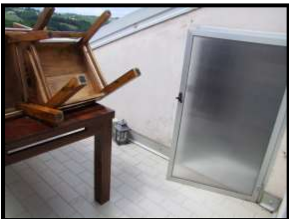
F. 17: INGRESSO DELLA SOFFITTA UBICATO AL PIANO 5° DA VIA GALILEO GALILEI, N. 9, SCALA "A" E PIANO 3° DA VIA MARCONI – VINCHIATURO (CB), P.LLA 857 SUB. 86 (A/3)
