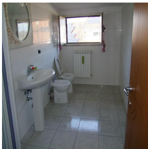
FOTO 28: INTERNO DEL W.C. AL PIANO 1°, P.LLA 4259 SUB. 7 (A/2)
