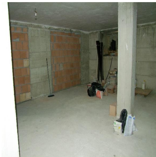
FOTO 50: INTERNO DEL GARAGE AL PIANO SEMINTERRATO, P.LLA 4259 SUB. 8 (C/6)
