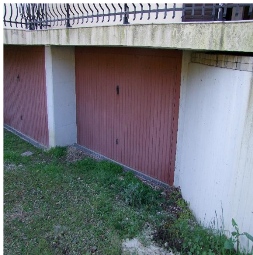
FOTO 46: INGRESSO DEL GARAGE AL PIANO SEMINTERRATO, P.LLA 4259 SUB. 8 (C/6)
