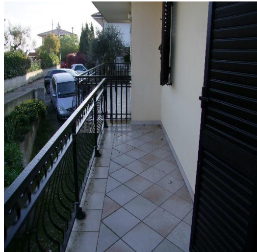
FOTO 14: BALCONE DEL SOGGIORNO AL PIANO TERRA, P.LLA 4259 SUB. 7 (A/2)
