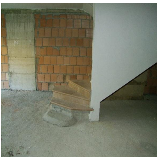
FOTO 51: INTERNO DEL GARAGE AL PIANO SEMINTERRATO, P.LLA 4259 SUB. 8 (C/6)
