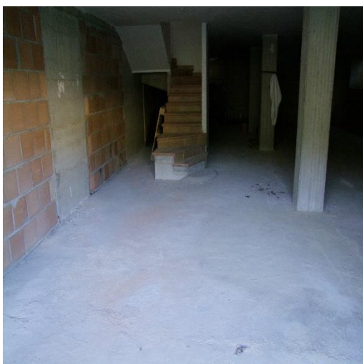
FOTO 47: INTERNO DEL GARAGE AL PIANO SEMINTERRATO, P.LLA 4259 SUB. 8 (C/6)
