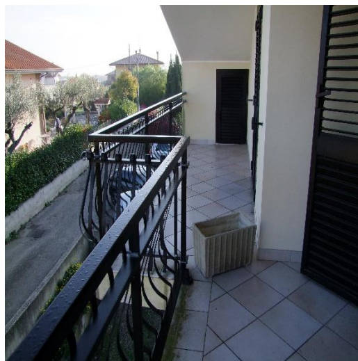
FOTO 26: BALCONE DELLO STENDITOIO "2" AL PIANO 1°, P.LLA 4259 SUB. 7 (A/2)
