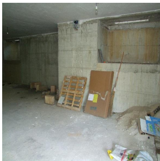
FOTO 48: INTERNO DEL GARAGE AL PIANO SEMINTERRATO, P.LLA 4259 SUB. 8 (C/6)
