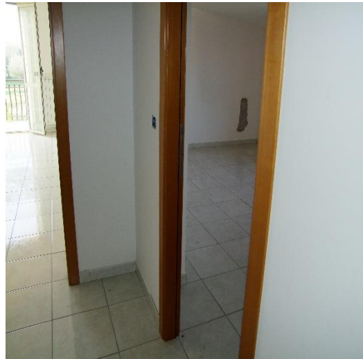
FOTO 30: ACCESSO AL RIPOSTIGLIO AL PIANO 1°, P.LLA 4259 SUB. 7 (A/2)
