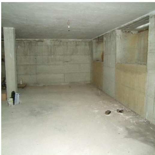
FOTO 49: INTERNO DEL GARAGE AL PIANO SEMINTERRATO, P.LLA 4259 SUB. 8 (C/6)
