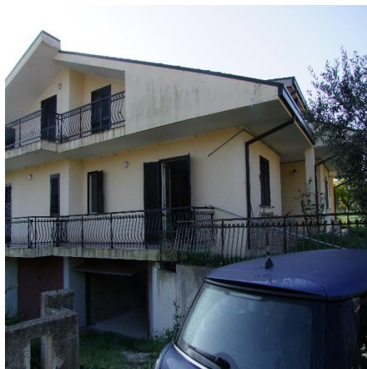
FOTO 42: FABBRICATO UNIFAMILIARE IN VIA SAN GIORGIO, 78, P.LLE 4259 SUB. 2, 7 E 8
