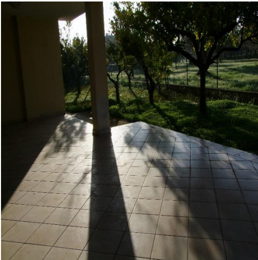
FOTO 09: PORTICO AL PIANO TERRA, P.LLA 4259 SUB. 7 (A/2)
